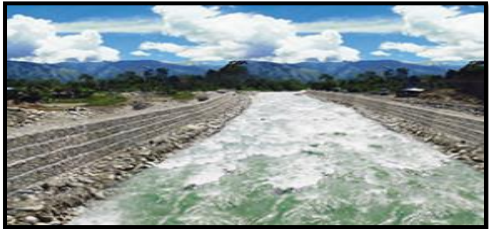
Figura N° 2: Muros de gaviones Fuente: TDM Perú más allá siempre (20)
