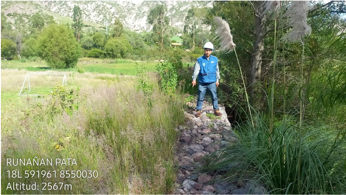
Foto 5: Se aprecia normal crecimiento de vegetación a los laterales de los muros de gaviones.
