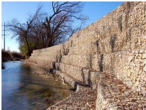
Figura 1. Muro de gavión
