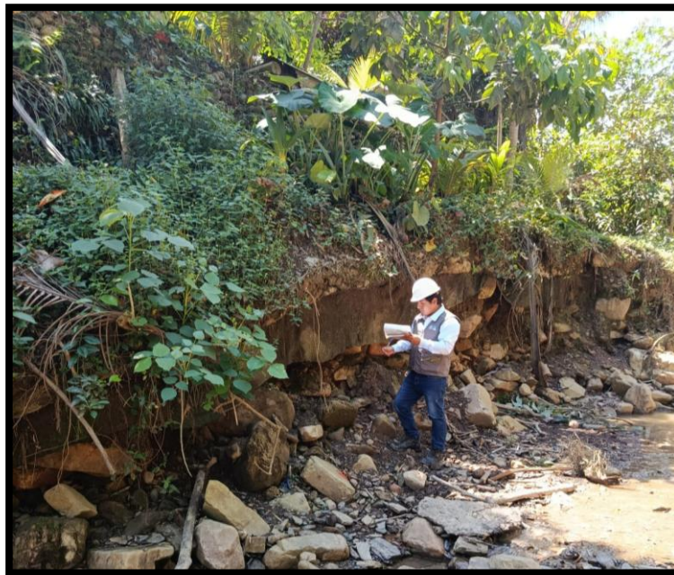
Fotografía 25 Continúa con la presencia de socavación a lo largo del muro de gaviones en el tramo VI
