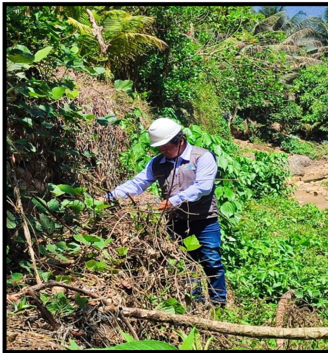
Fotografía 17 Se aprecia la medición de cada escalón del muro de gaviones las cuales miden 50 cm.
