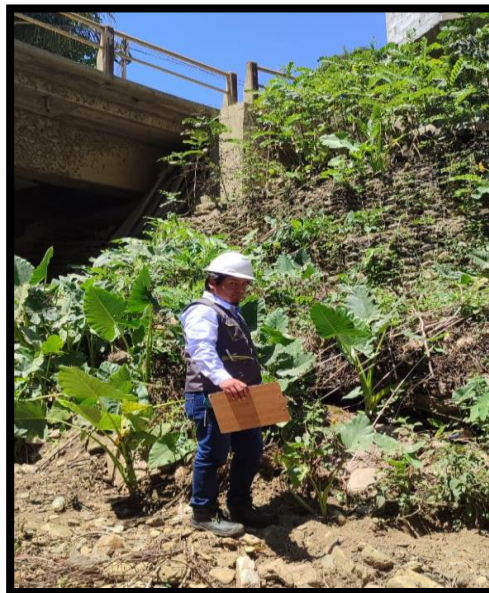
Fotografía 31 Final de la progresiva 0+300 a 0+350
