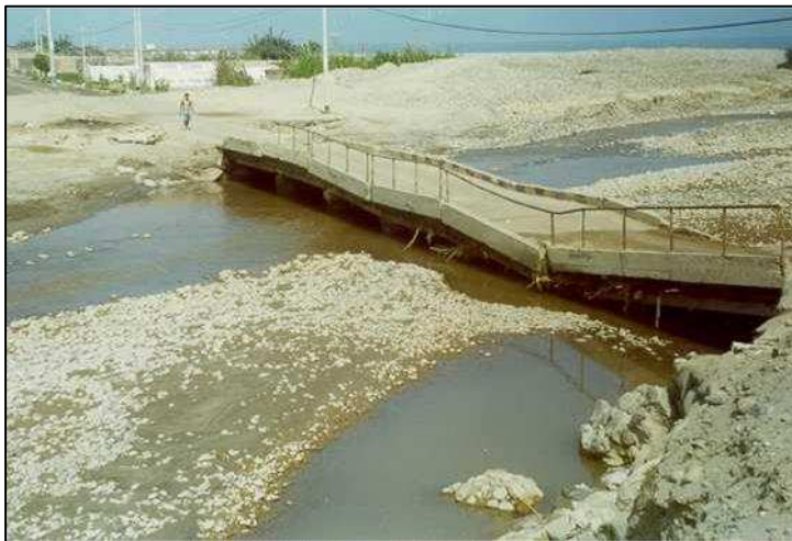
Figura 3. Socavación
