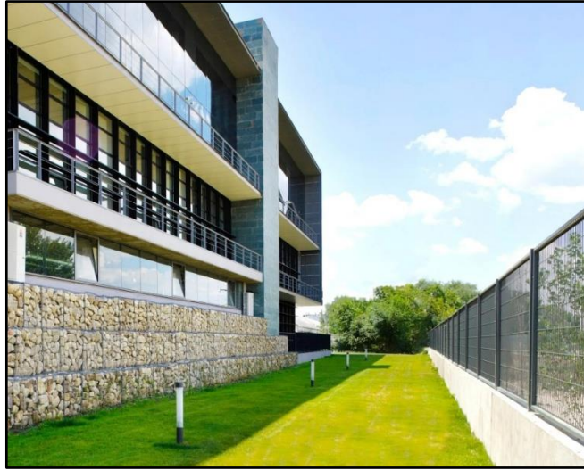
Figura 14. Uso estético de un muro de gavión
