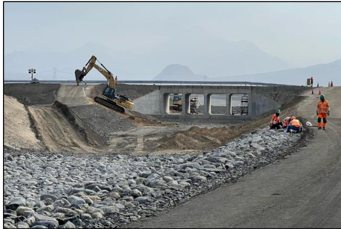
Figura 1. Construcción de una defensa ribereña
