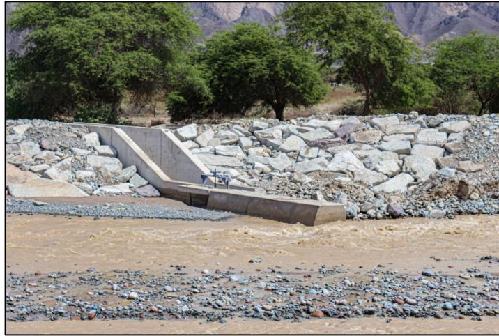
Figura 6. Enrocados con roca al volteo
