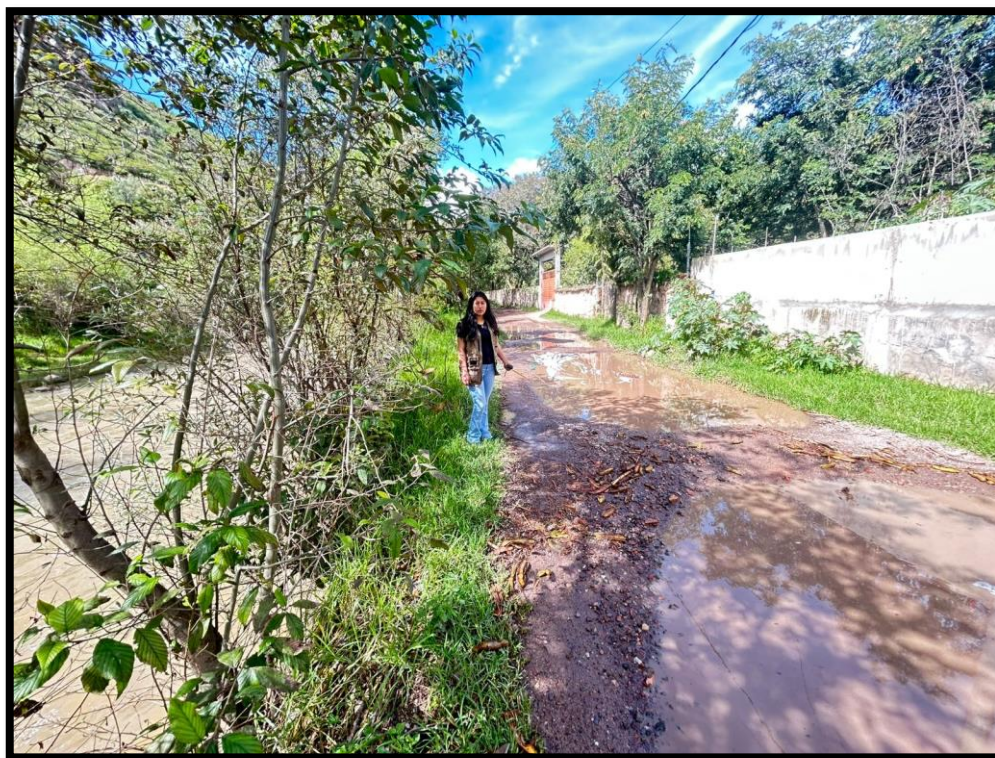
Figura 45. Cercanía del muro de gavión con la carretera no asfaltada
