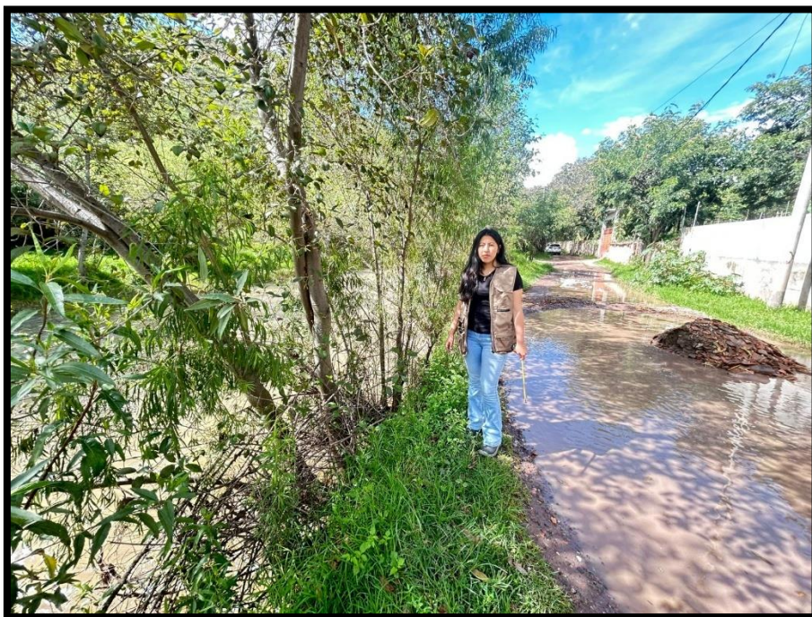
Figura 42. Charcos de agua en la carretera no asfaltada, progrs. 9+300 y 9+400
