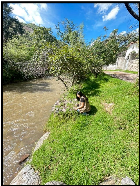
Figura 49. Final del muro de gavión
