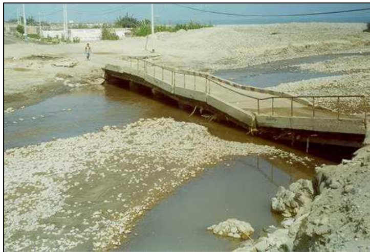
Figura 3. Socavación
