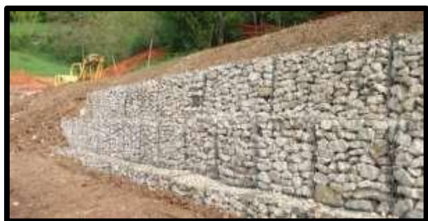
Figura 7: Gaviones tipo muro de contención
