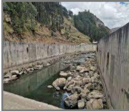
Figura 23: Muros de concreto armado
