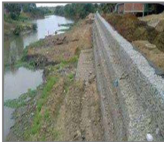
Figura 24: Muro de gaviones
