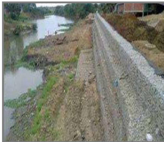
Figura 24: Muro de gaviones
