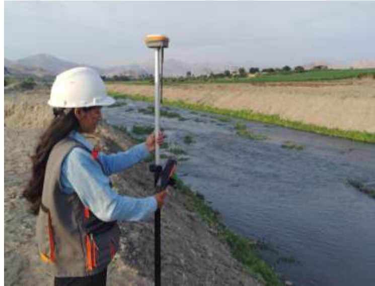
Foto 13: Topografía y reconocimiento del terreno
