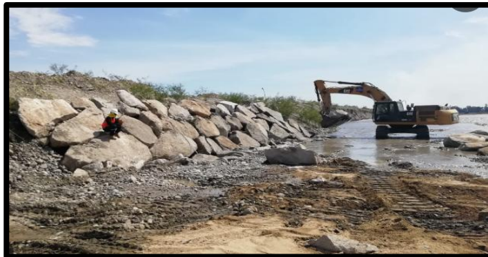
Figura N° 07: Enrocado suelto
