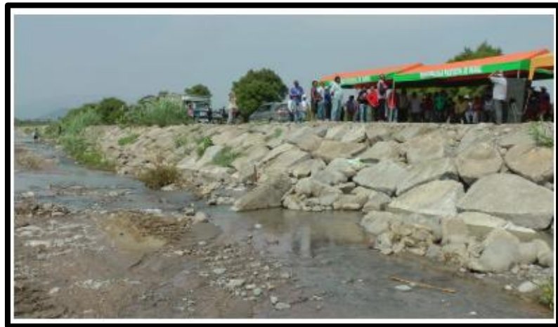
Figura N° 08: Enrocado colocado
