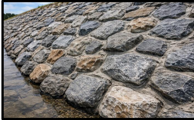
Figura N° 09. Enrocado con mortero en talud de protección hidráulica
