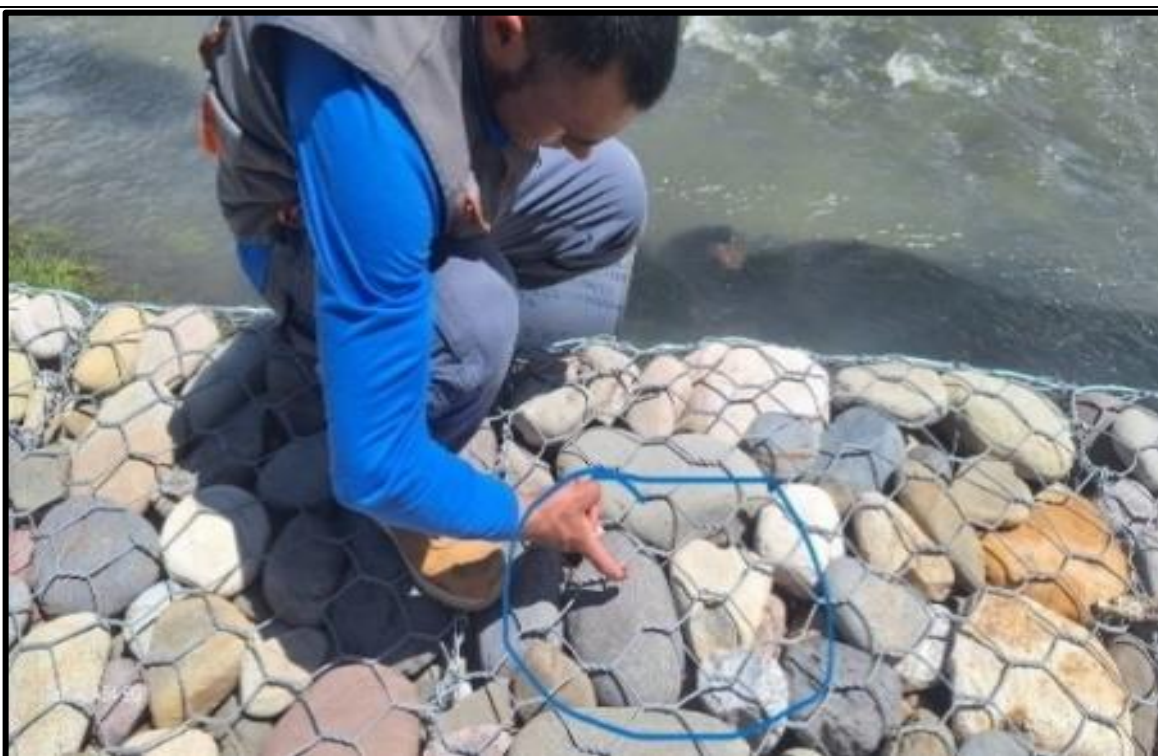
Figura A. 18: Evaluación de gaviones en margen derecho donde observa la rotura de malla. Fuente: Propia 2026
