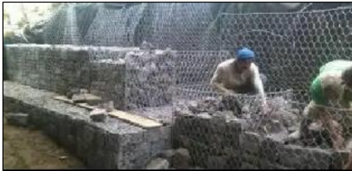
Figura 15: Materiales de relleno
