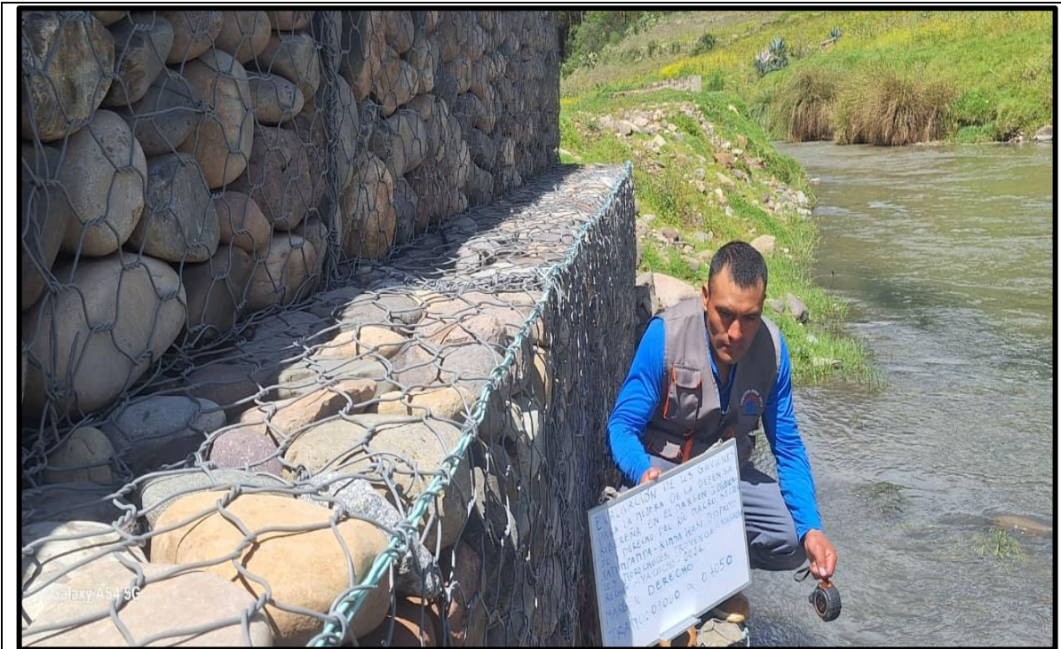
Figura A. 15: Evaluación de gaviones en margen derecho del tramo 0+000 a 0+050 Fuente: Propia 2026
