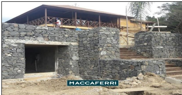
Figura 2: Estructuras de contención con gaviones
