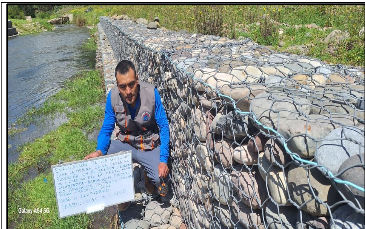
Figura A. 23: Evaluación de gaviones en margen izquierdo del tramo 0+050 a 0+100 Fuente: Propia 2026
