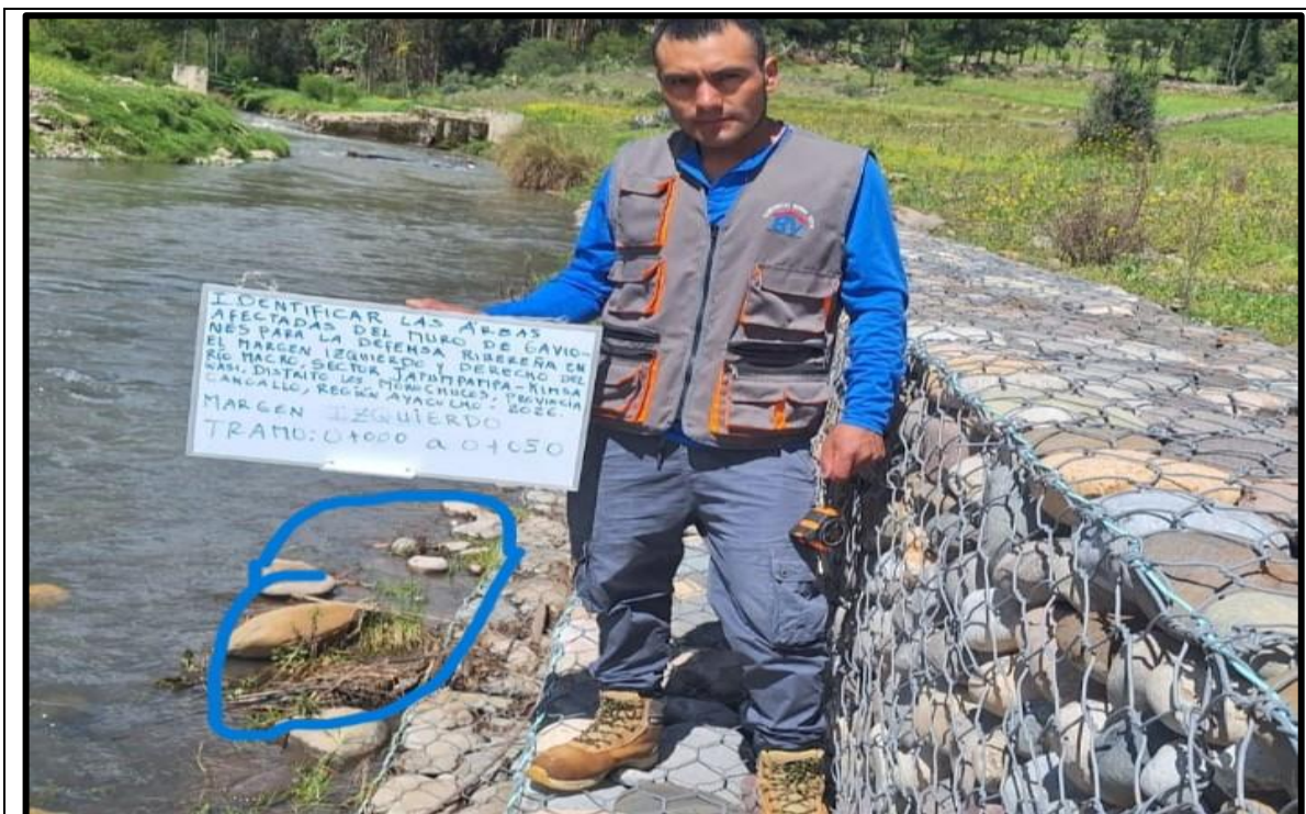
Figura A. 9: Identificación de muro de gaviones en margen izquierdo del tramo 0+000 a 0+050 Fuente: Propia 2026
