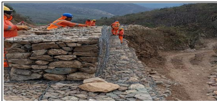
Figura 10: Gavión doble torsión
