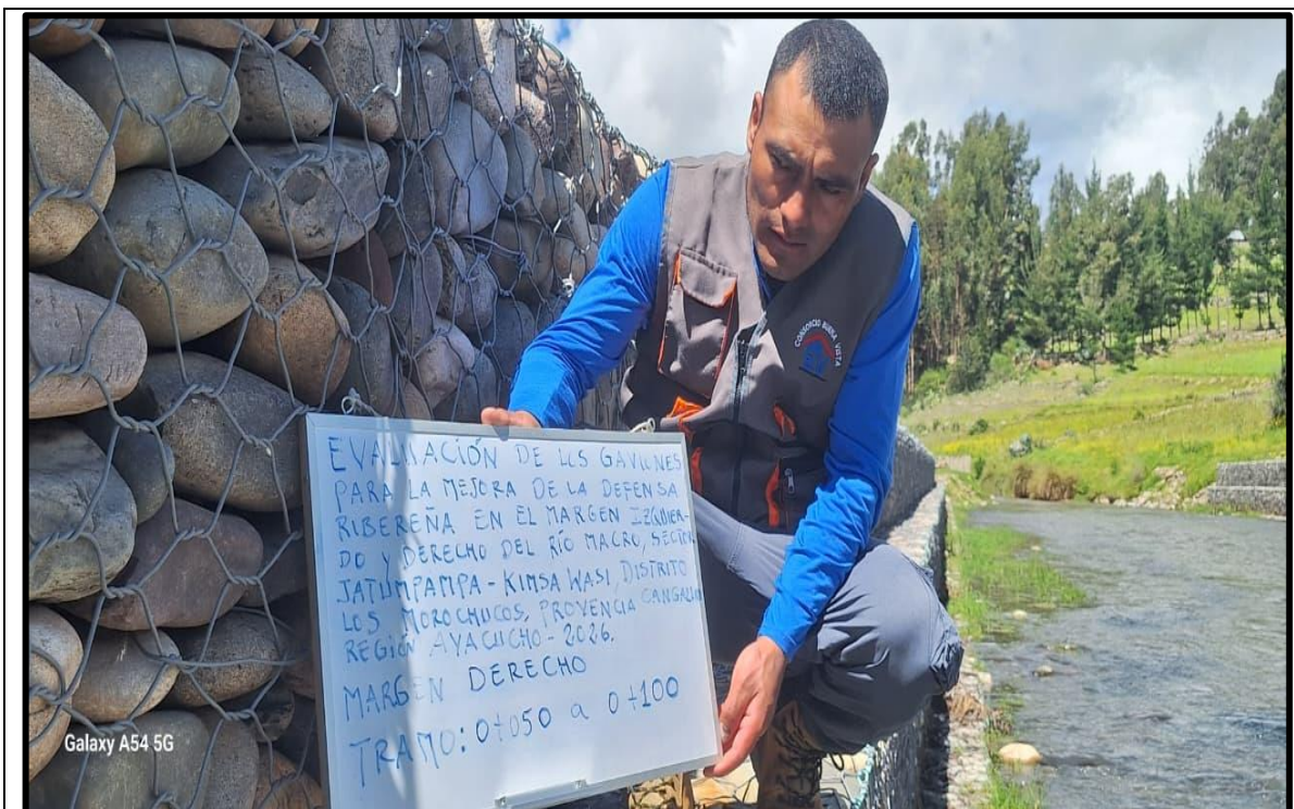
Figura A. 17: Evaluación de gaviones en margen derecho del tramo 0+050 a 0+100 Fuente: Propia 2026
