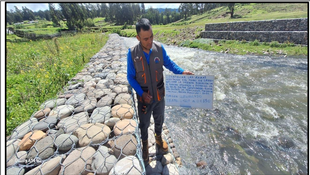
Figura A. 13: Identificación de muro de gaviones en margen izquierdo del tramo 0+100 a 0+150 Fuente: Propia 2026
