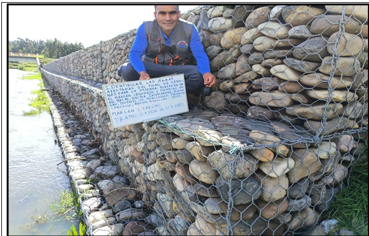
Figura A. 3: Identificación de muro de gaviones en margen derecho en el tramo 0+000 a 0+050 Fuente: Propia 2026
