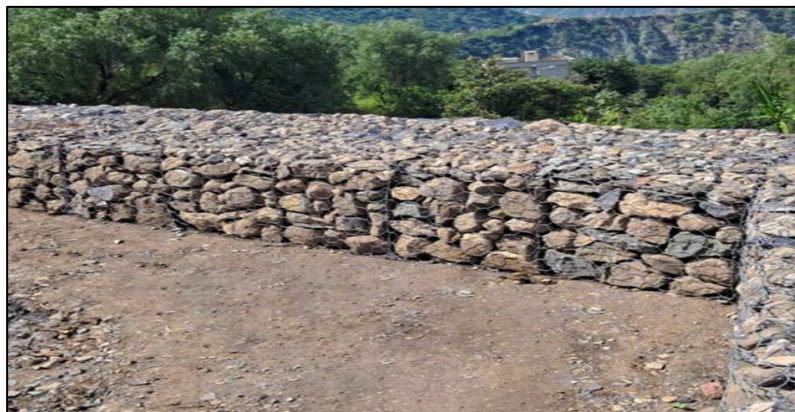
Figura 11: Gavión electrosoldado
