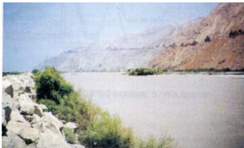
FOTO N° 2. DIQUE ENROCADO CONTINUO VALLE OCOÑA Q_{MAX} 3100 \text{ m}^3/\text{seg.}
