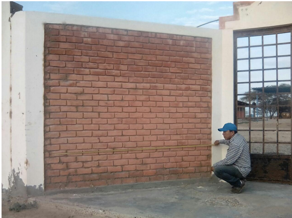
Gráfico 51: Humedad en parte superior de los muros de albañilería.
