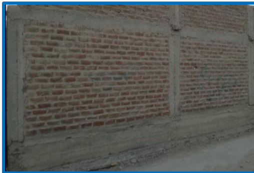
Gráfico 4: Elementos de confinamiento.
