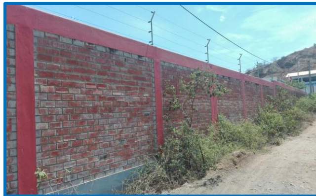
Gráfico 3: Albañilería confinada.
