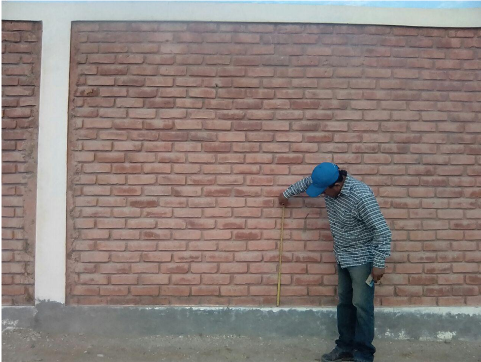
Gráfico 50: Erosión en el sobrecimiento.
