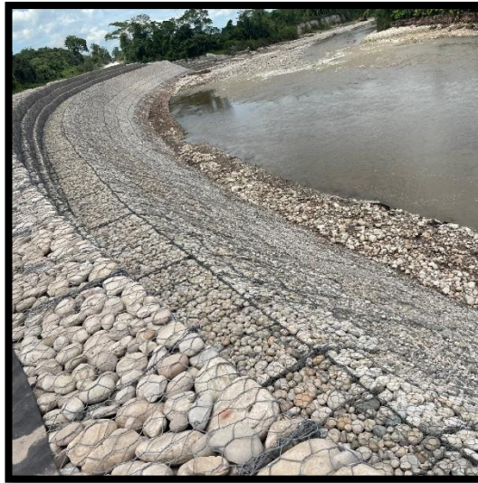
Figura 7: Muro de Gavión tipo colchón
