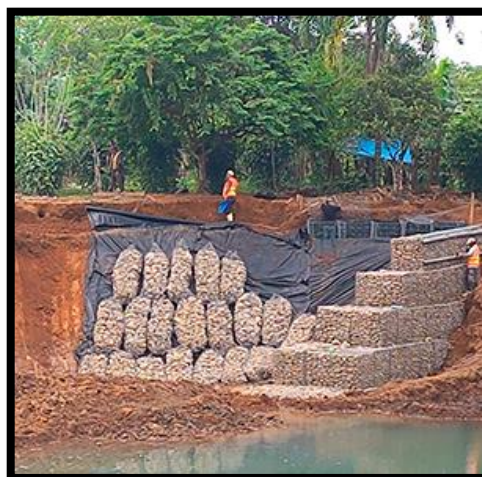
Figura 8: Muro de Gavión tipo saco
