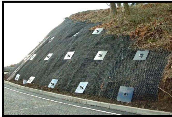
Figura 14: Estabilidad de taludes
