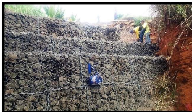
Figura 18: Mantenimiento de muro de gaviones
