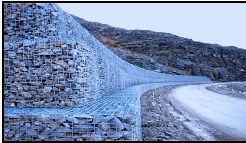
Figura 5: Muro de Gaviones
