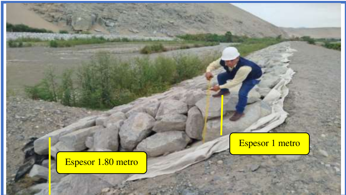
Foto N°03 En la imagen se observa el espesor del enrocado en la progresiva 0+000, registrando 1.00 metro en la sección superior y 1.80 metros en la sección inferior. Fecha: 07 de marzo
