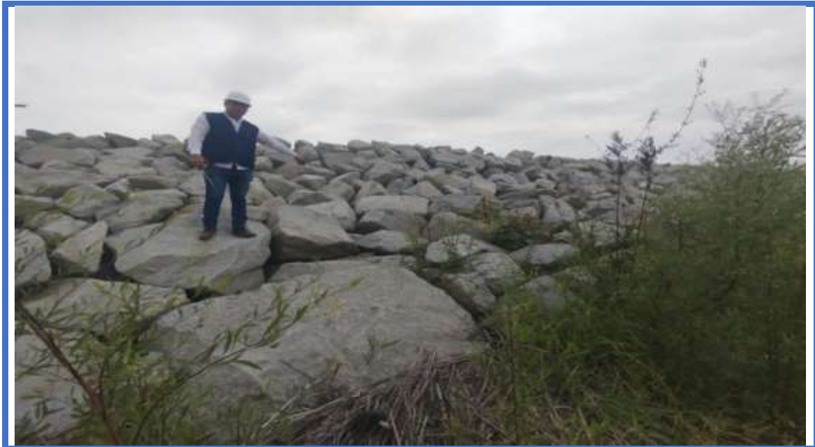
Foto N°27 En la imagen se aprecia, desde la zona baja, la configuración de la base del enrocado, donde destaca la incorporación de bloques rocosos de gran magnitud, con dimensiones de 2.10 x 1.20 metros, progresiva 0+500. Fecha: 10 de marzo
