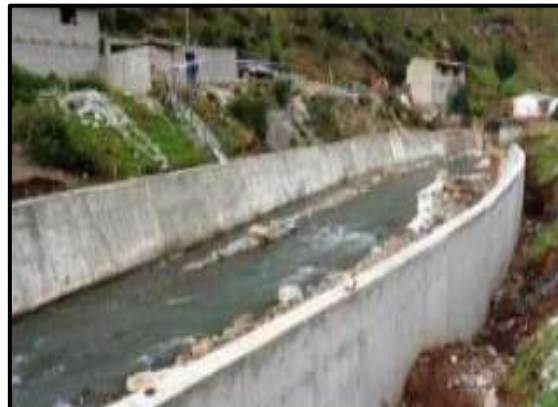
Figura 23: Muro de concreto armado
