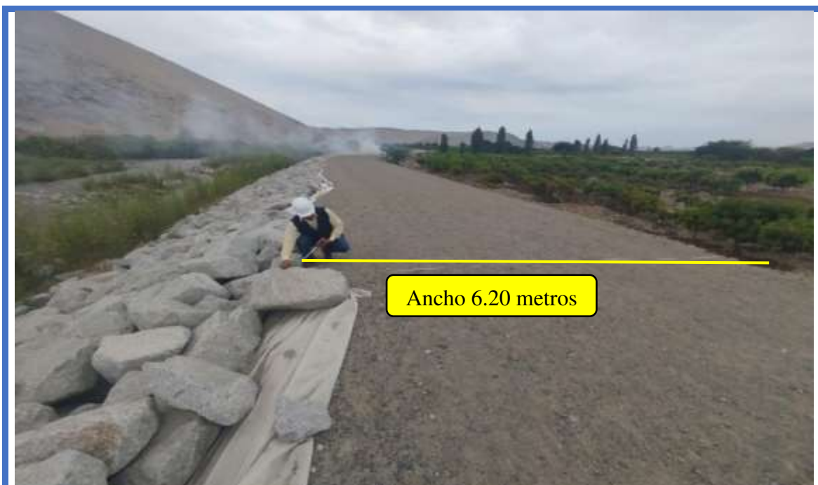
Foto N°19 En la progresiva 0+300, la imagen presenta la medición del ancho de la corona de la defensa ribereña, obteniendo un valor de 6.20 metro. Fecha: 07 de marzo
