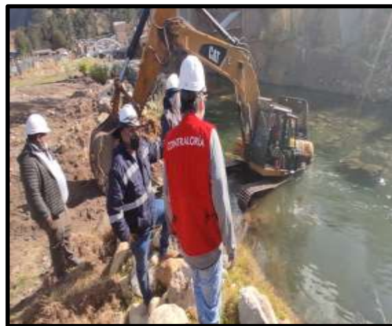
Figura 25: Mejoramiento del enrocado
