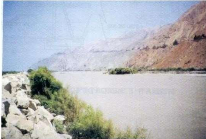
FOTO N° 2. DIQUE ENROCADO CONTINUO VALLE OCOÑA Q_{MAX} 3100 \text{ m}^3/\text{seg.}
