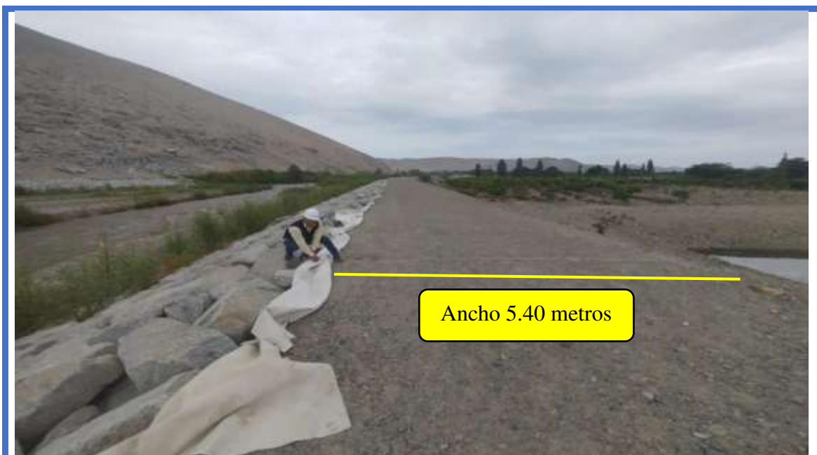
Foto N°07 La imagen muestra la corona de la defensa ribereña en la progresiva 0+100, registrando un ancho de 5.40 metros; este valor, en comparación con otros puntos del tramo, puede indicar una variación en el diseño original. Fecha: 07 de marzo
