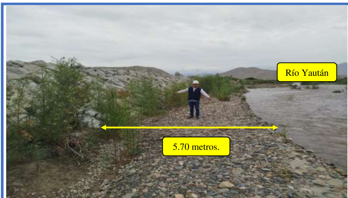
Foto N°06 En la imagen se observa la actividad constante de la corriente del río, evidenciando la socavación progresiva de la base del terreno, que actualmente presenta un ancho remanente de 5.70 metros. Fecha: 10 de marzo
