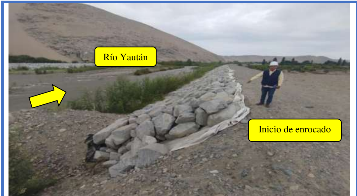
Foto N°01 En la imagen se observa el punto de inicio de la defensa ribereña en la margen derecha del río Yaután (Progresiva 0+000), en las inmediaciones del C.P. La Máquina; se aprecian los primeros elementos del enrocado y el estado inicial del talud. Fecha: 07 de marzo
