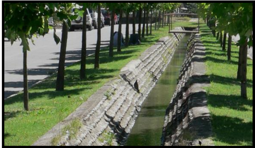
Figura N° 4: Defensa ribereña bioingeniería Fuente: Mundo de gaviones (21)
