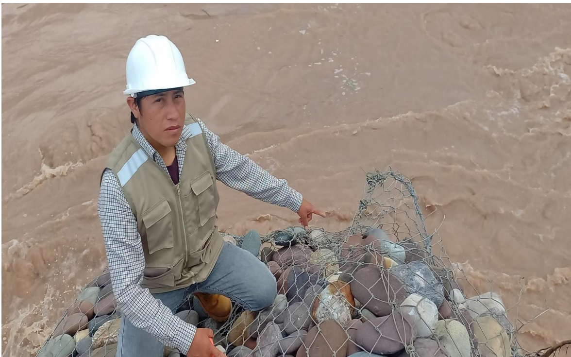
Foto 10: Se observa el daño causado por el desborde de la crecida del caudal.
