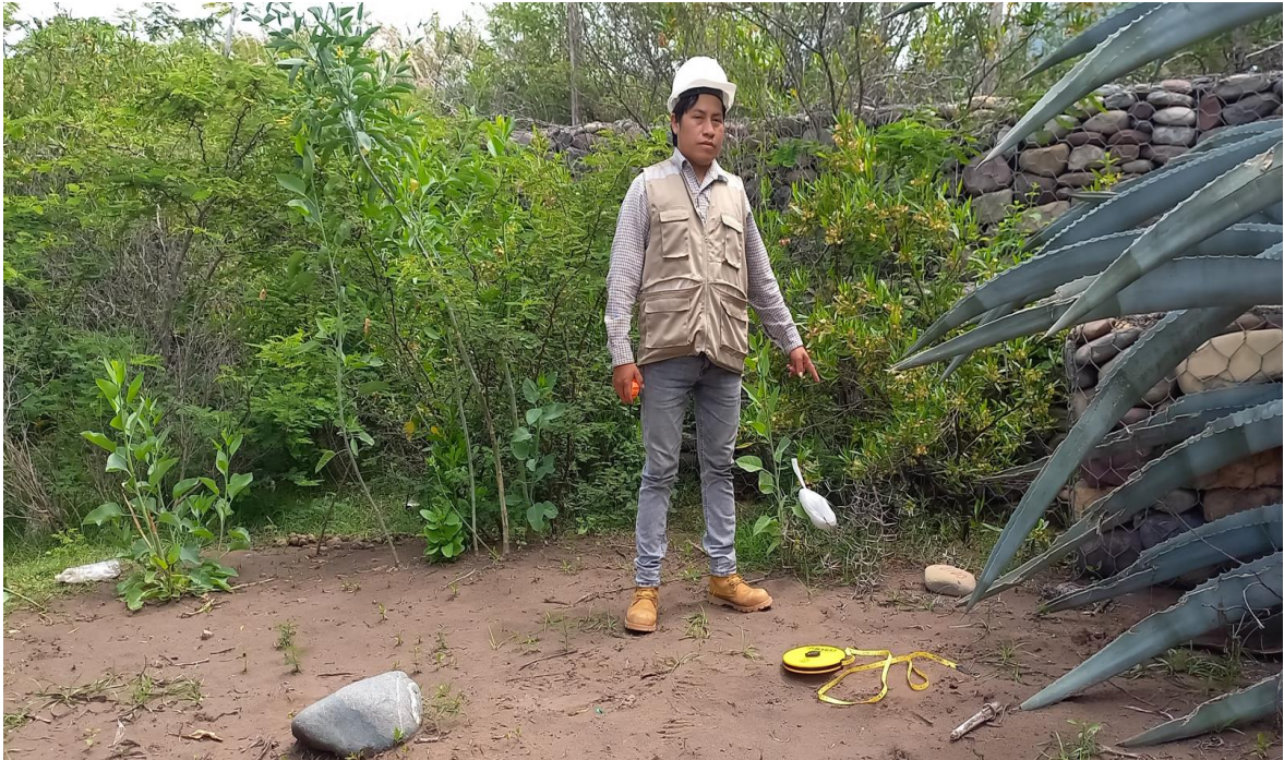
Foto 1: Se observa un muro de gaviones en zona cercana al río con presencia de vegetación.
