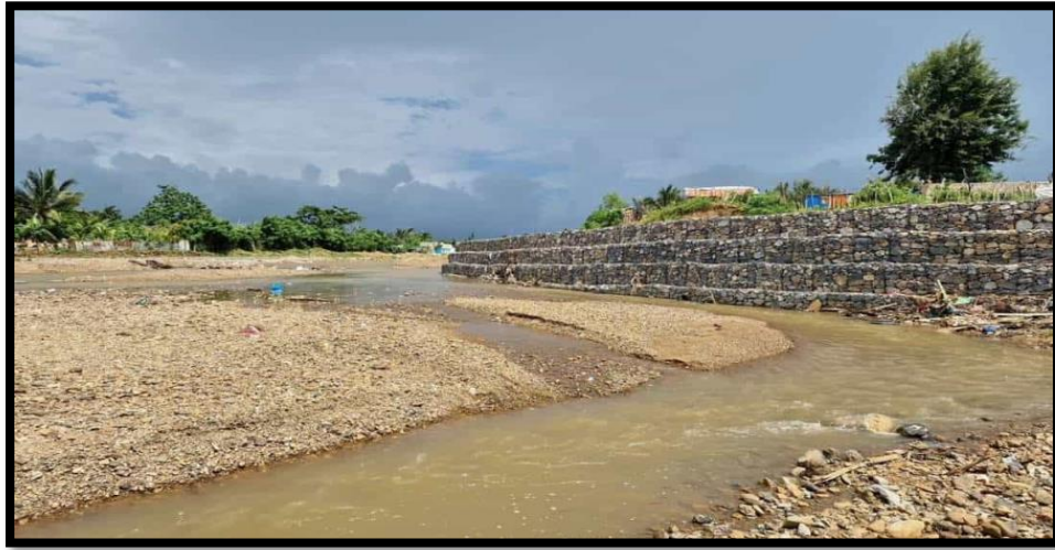
Figura N° 5: Muros de gaviones Fuente: diario libre (27)
