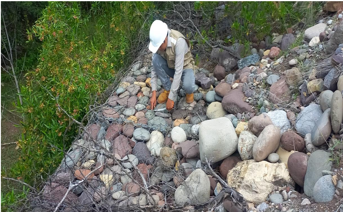
Foto 8: Se observa la medición de cómo están conformadas las mallas hexagonales.
