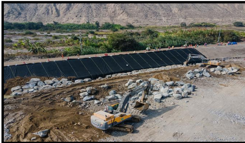
Figura N° 3: Defensa ribereña flexible Fuente: Mundo de gaviones (21)
