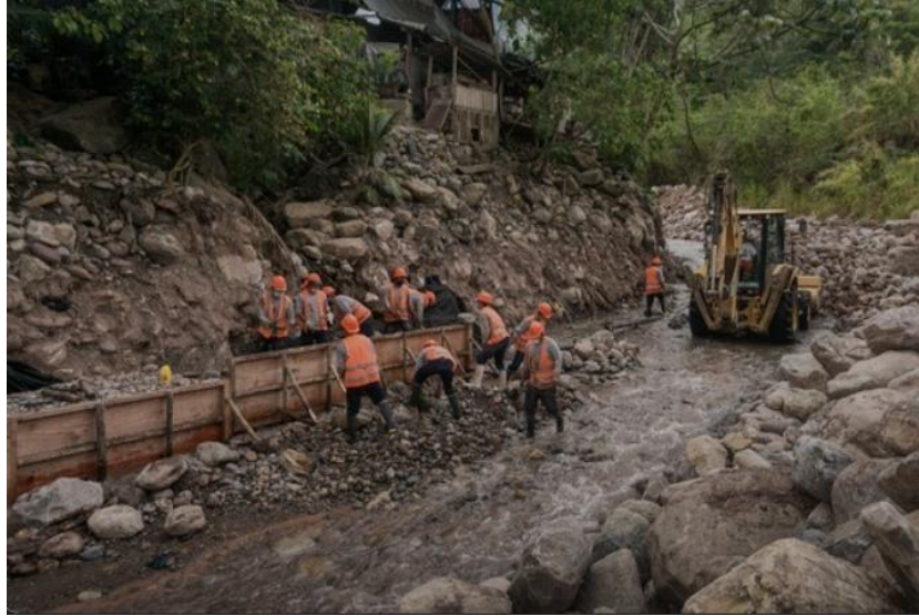
Figura 9: Mejoramiento de la defensa ribereña tipo enrocado
