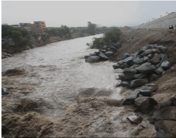
Figura 5: Estado de afectacion
