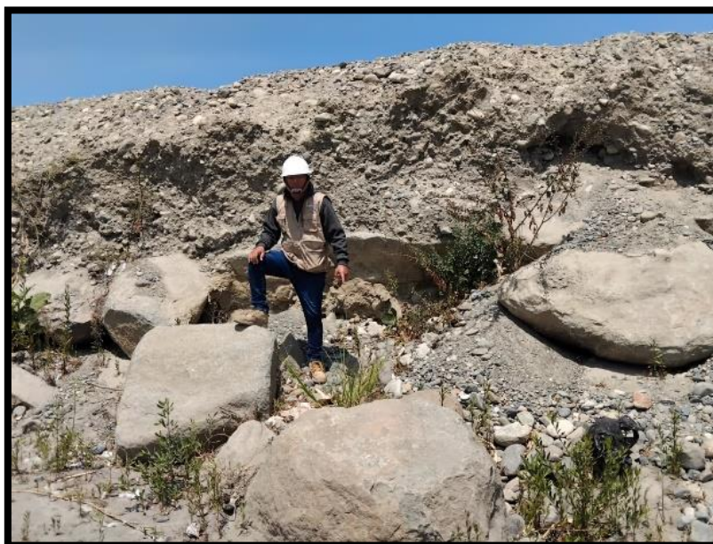
Figura 20: Se observa basura en el enrocado en la progresiva 0+050 – 0+100.
