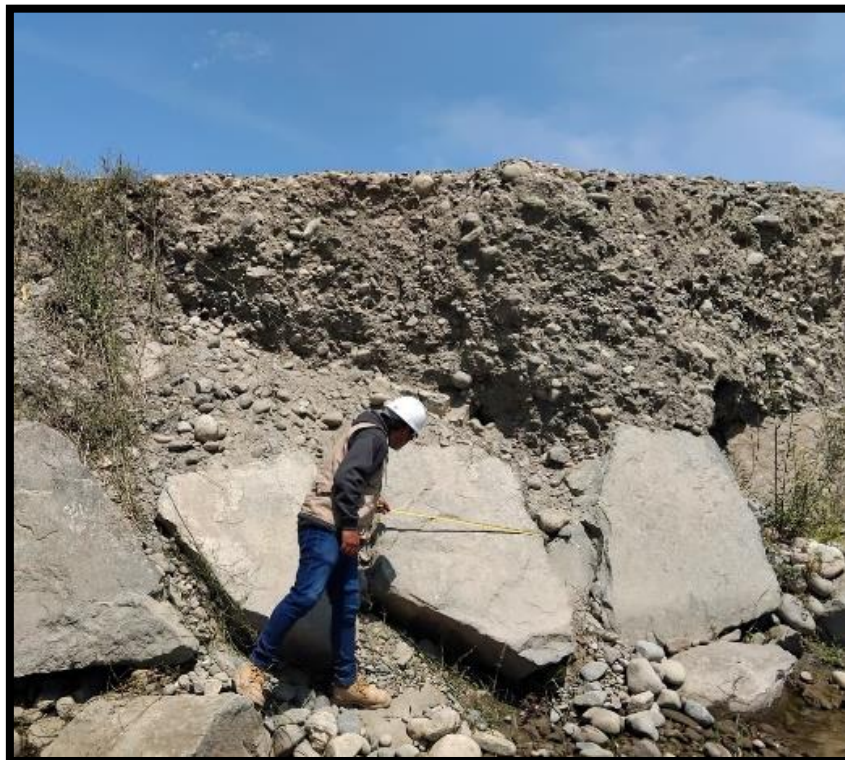
Figura 22: Medición del enrocado en la progresiva 0+050 – 0+100.
