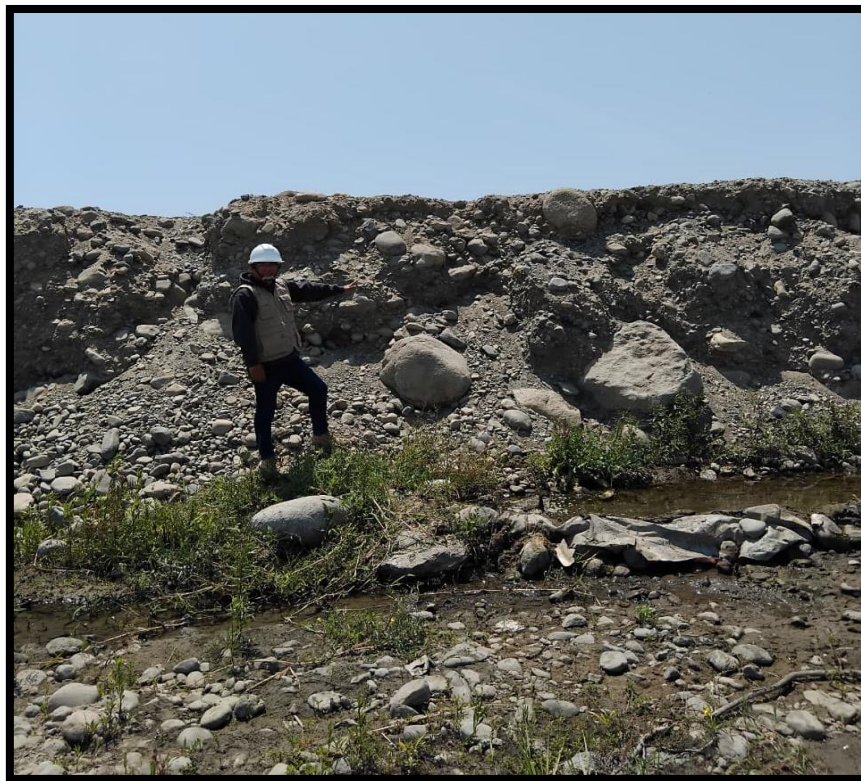
Figura 24: Se visualiza la falta de enrocado en la margen derecha del río Nepeña en la progresiva 0+150 – 0+200.
