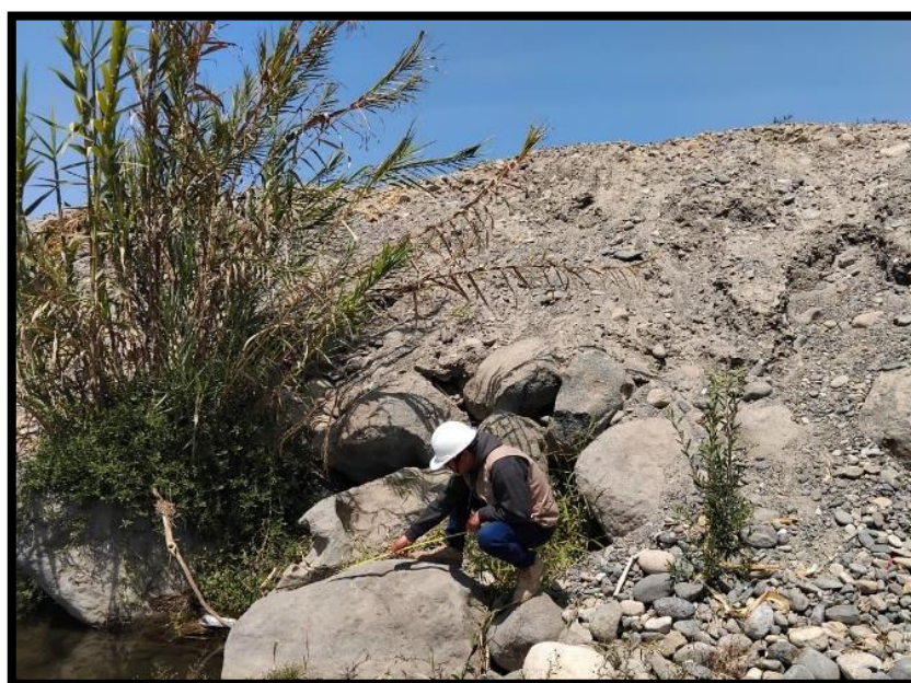
Figura 31: Medición del enrocado en la progresiva 0+450 – 0+500
