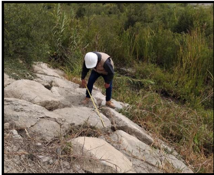
Figura 23: Medición del enrocado en la progresiva 0+300 – 0+350.
