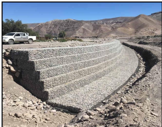
Figura 9: Muro de gavión
