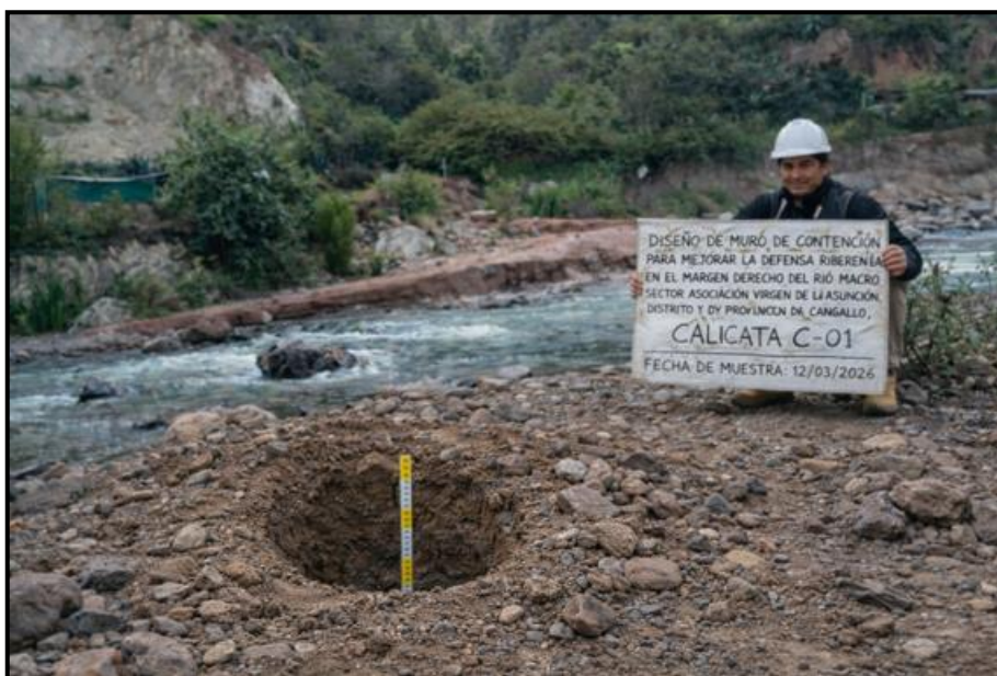
Figura 49: Se observa la realización de la calicata C-01, para la toma de muestras del suelo. Fuente: Elaboración Propia 2026
