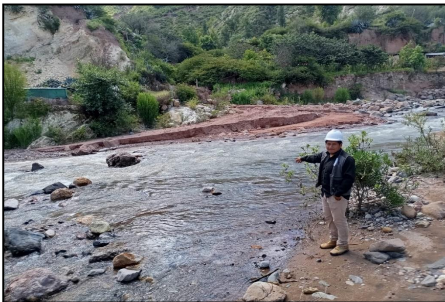
Figura 45: Se observa la evaluación de río Macro en las progresivas 0+350 al 0+400 Fuente: Elaboración Propia 2026
