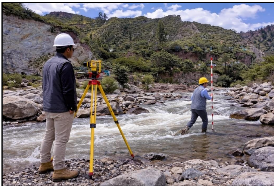
Figura 48: Se observa el levantamiento topográfico para realizar perfil longitudinal del río. Fuente: Elaboración Propia 2026
