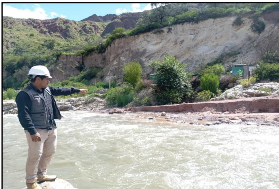
Figura 43: Se observa la evaluación de río Macro en las progresivas 0+200 al 0+250 Fuente: Elaboración Propia 2026
