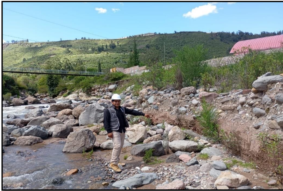
Figura 42: Se observa la evaluación de río Macro en las progresivas 0+100 al 0+150 Fuente: Elaboración Propia 2026
