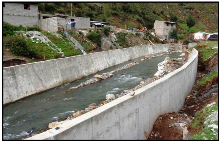
Figura 10: Muro de hormigón armado
