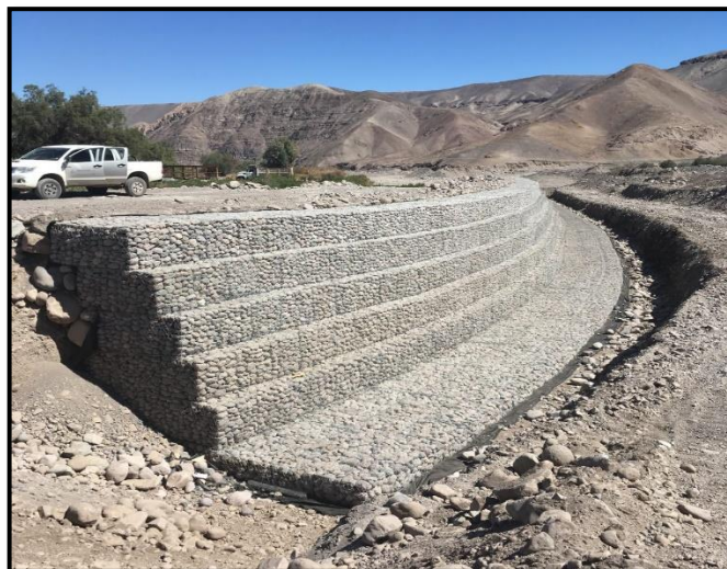
Figura 9: Muro de gavión
