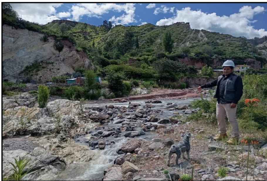
Figura 44: Se observa la evaluación de río Macro en las progresivas 0+300 al 0+350 Fuente: Elaboración Propia 2026
