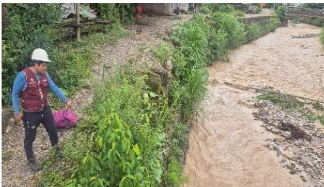
Figura 13: verificando la presencia de vegetación y escombros por el aumento del caudal del río.
