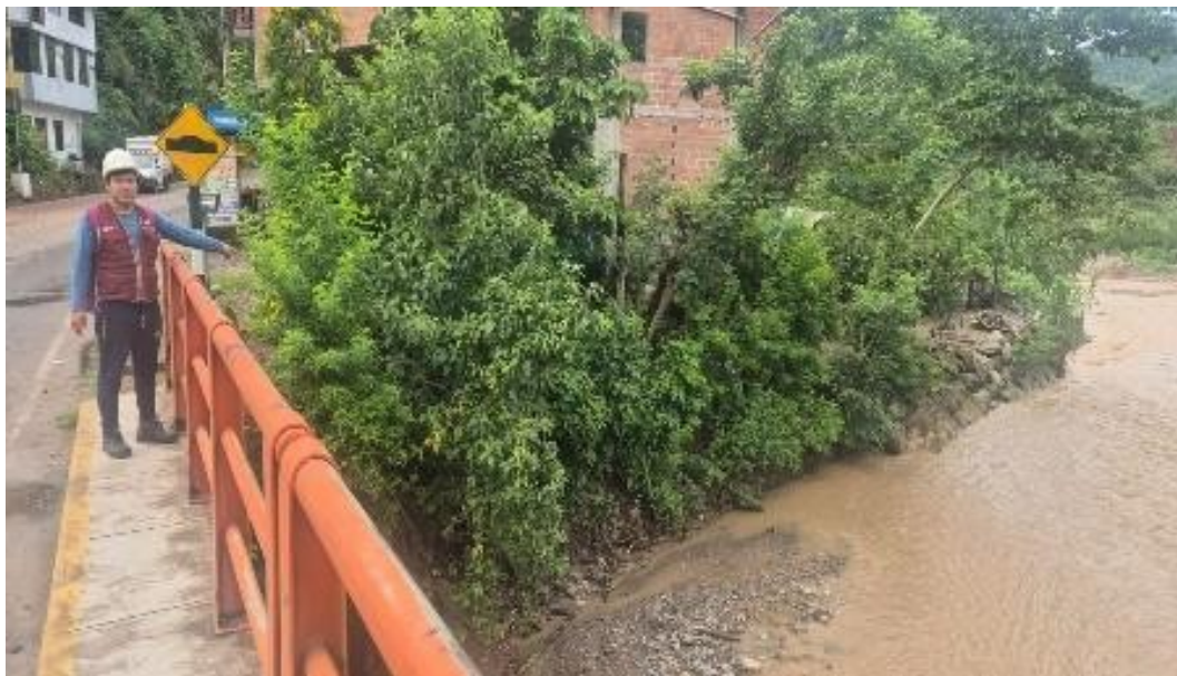
Figura 7: Verificando el inicio de la defensa ribereña.
