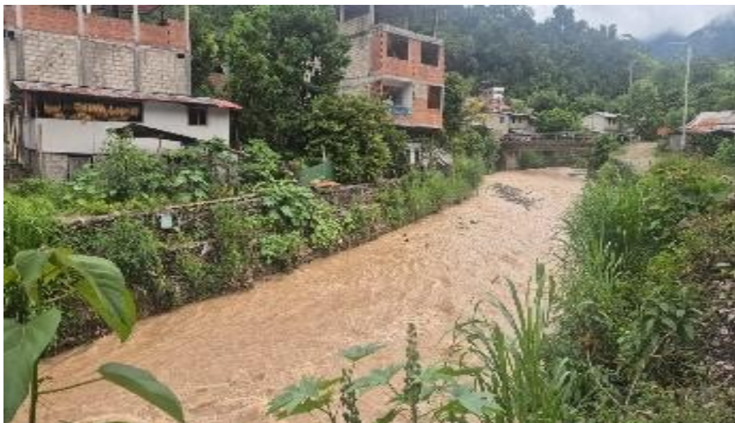
Figura 14: vista panorámica de la estructura de la defensa ribereña con muro de gaviones.
