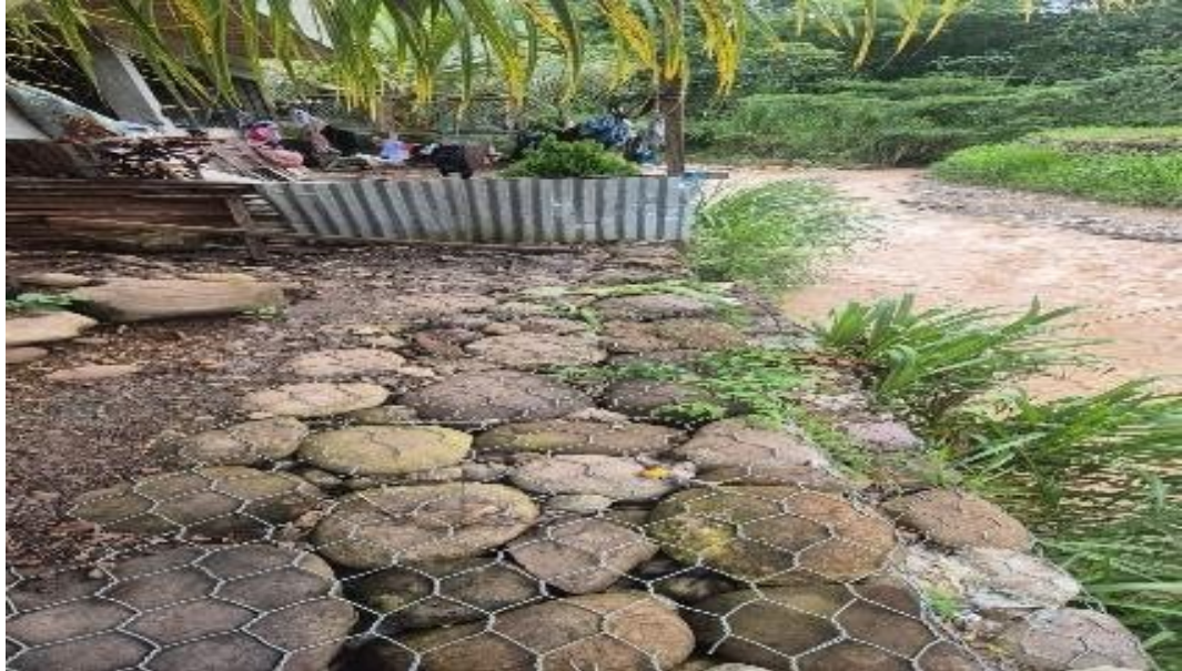
Figura 9: Verificando presencia de vegetación y cerco de una vivienda en los muros de gaviones.
