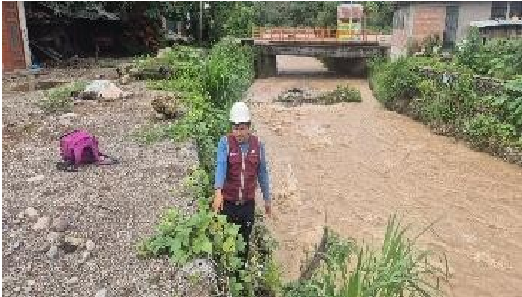
Figura 10: Verificando la presencia de vegetación en la defensa ribereña.
