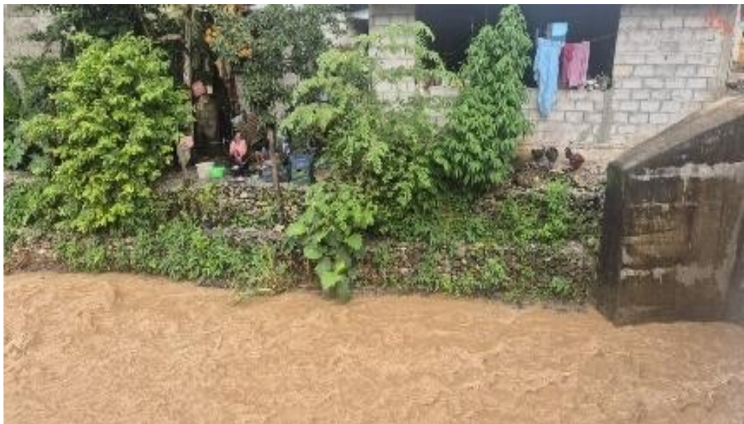
Figura 11: presencia de malezas en los gaviones de la estructura.
