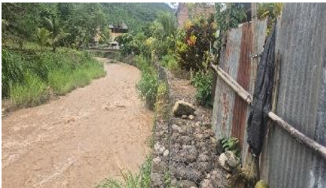
Figura 8: Verificando la presencia del cerco de una vivienda en el muro de gavión.
