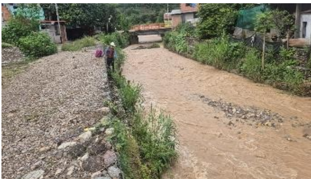
Figura 15: presencia de vegetación y aumento del caudal del río.
