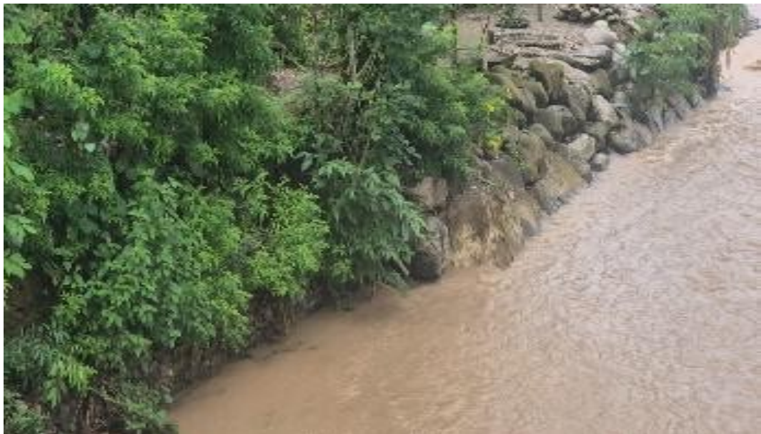
Figura 21: verificando vegetación y muro enrocado.
