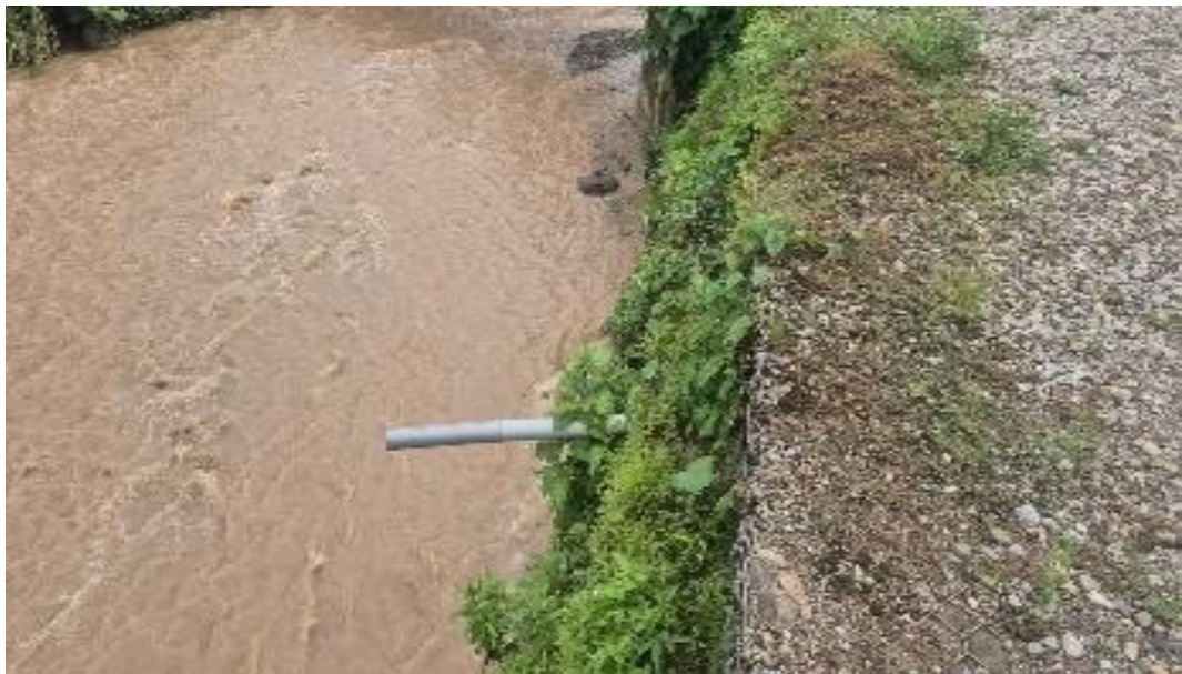
Figura 17: Verificando la presencia de vegetación y tubería de desfogue en el muro de gaviones tipo caja.
