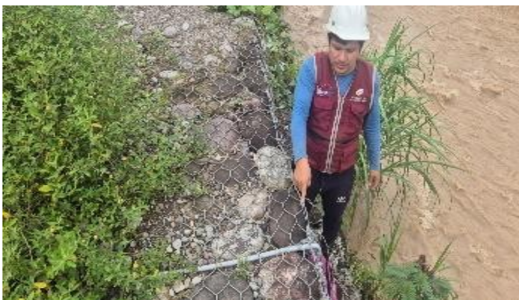
Figura 23: Verificando la presencia de tubería de agua en la estructura del muro de gavión.
