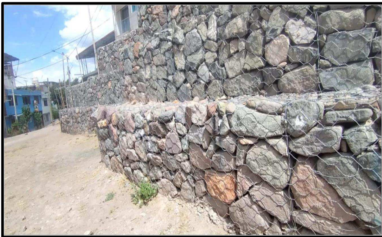
Foto 11. Visualización de estructura en el tramo 0+380
