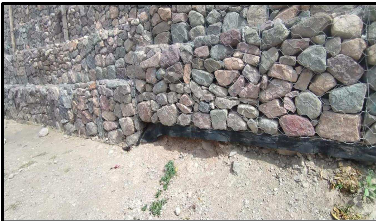
Foto 7 Visualización de estructura sin base fija
