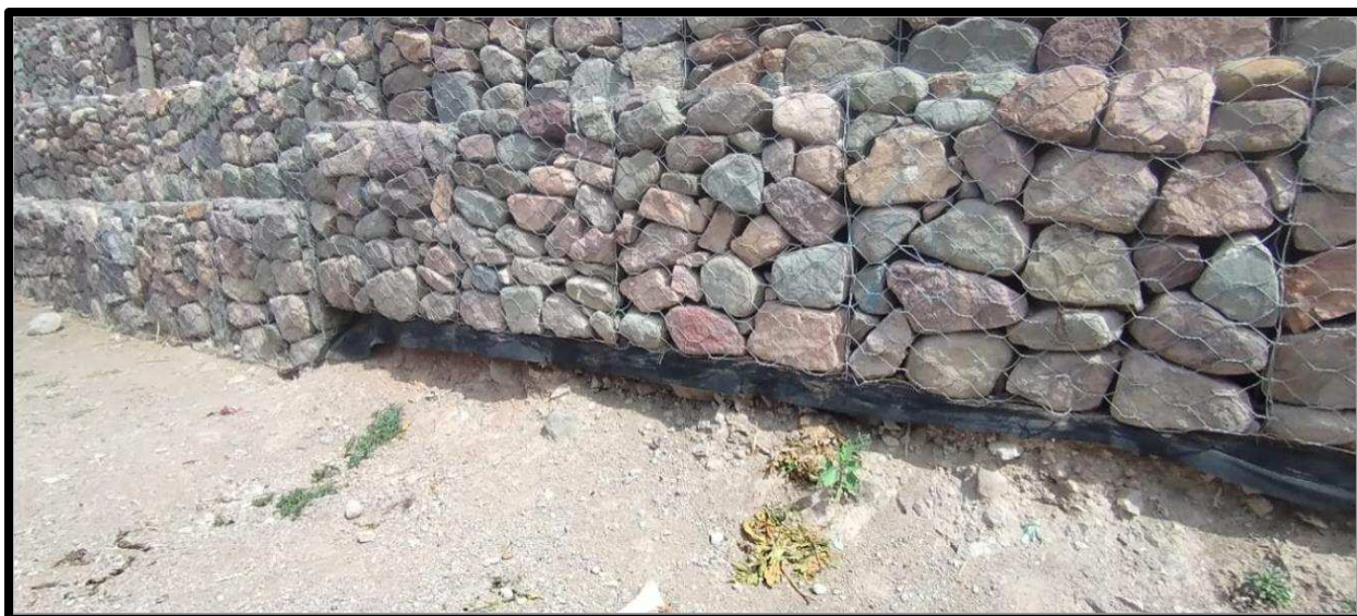
Foto 4 Visualización de la geomembrana en el tramo 0+220
