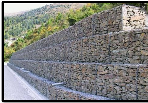
Figura 3. Construcción de muro de gavión
