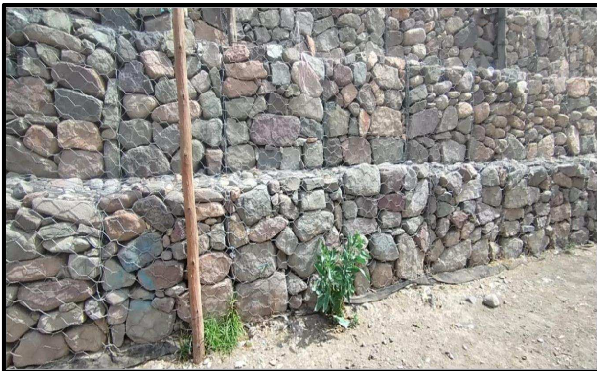
Foto 13 Visualización de la malla metálica en el tramo 0+300
