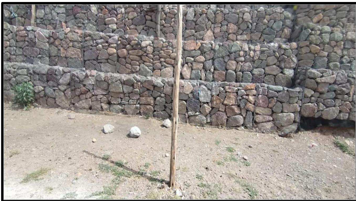
Foto 3 Visualización de estructura en el tramo 0+220
