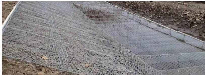
Figura 3. Colocación de gavión tipo colchón.
