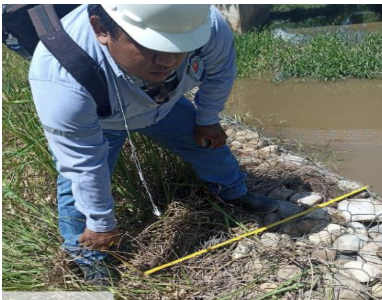
IMAGEN 01: REALIZANDO MEDICIÓN DEL ESCALON SUPERIORDE MURO DE GAVIÓN EN TRAMO 01, SECCIÓN 1- DE 01 A 40 M.
