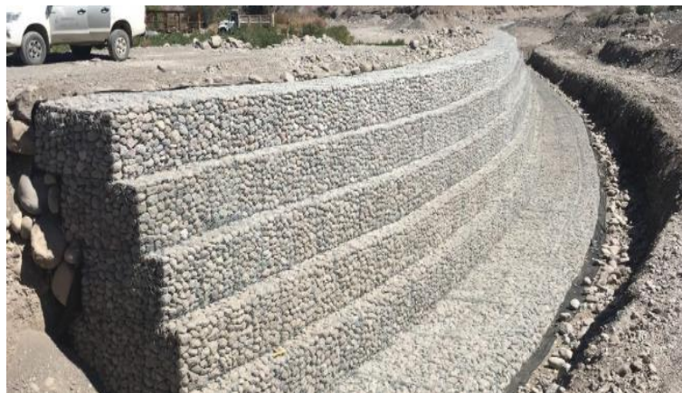
Figura 4. Dique de gavión tipo caja.
