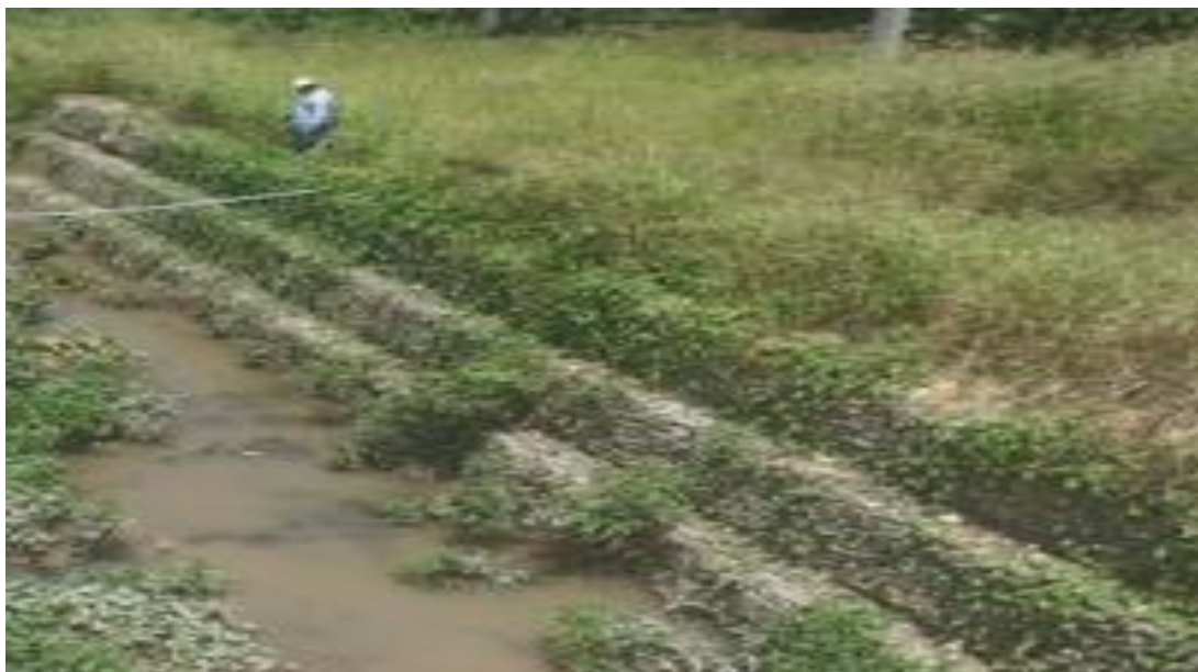
Imagen 03: Vista general en el tramo 01, sección 1- de 01 a 40 m.
