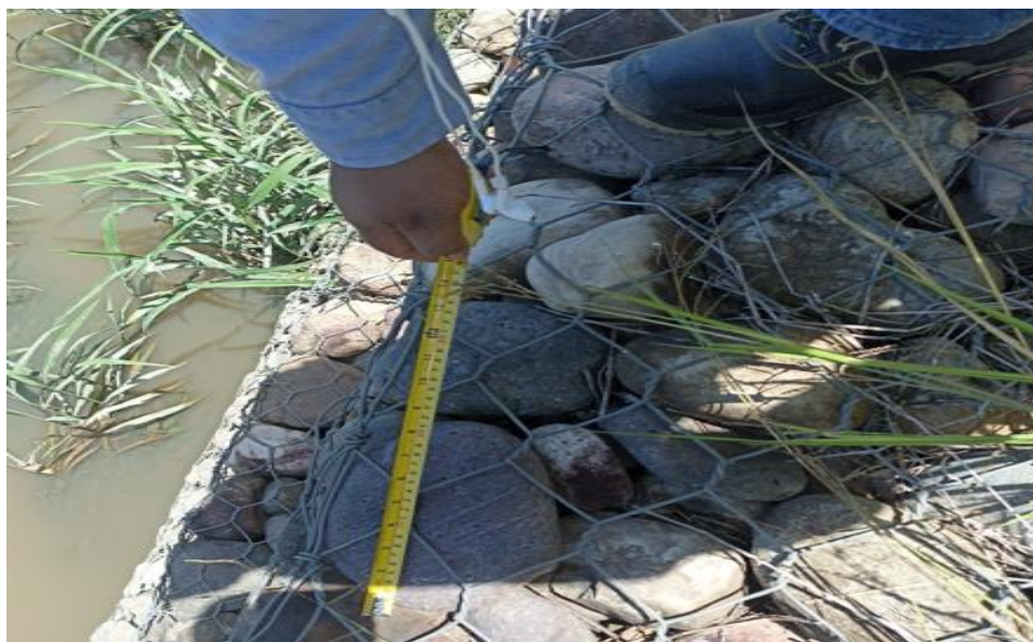
Imagen 12. Realizando medici3n de la malla met3lica en el muro gavi3n en el tramo secci3n 6- de 210 a 260.
