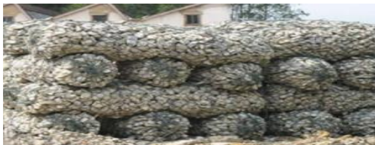
Figura 5.Muro de gavión tipo saco.
