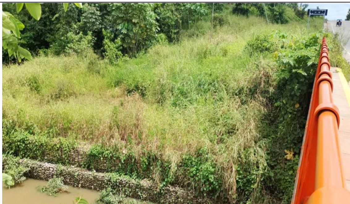
Imagen 05: Vista general del tramo 01, sección 3- de 80 a 120 metros.
