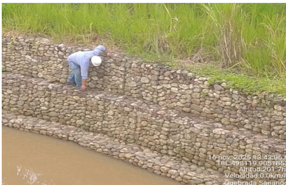
Imagen 13: Vista panorámica en el tramo 03, sección 7- de 210 a 260- 300 m.
