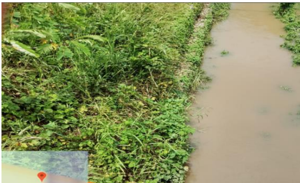
Imagen 15: Vista general del tramo 04, sección 8 - de 300 a 340 m .
