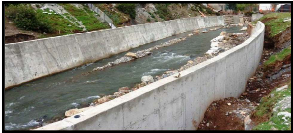
Figura 6: Muro de Concreto
