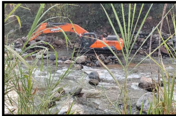
Figura 17: Mantenimiento del enrocado
