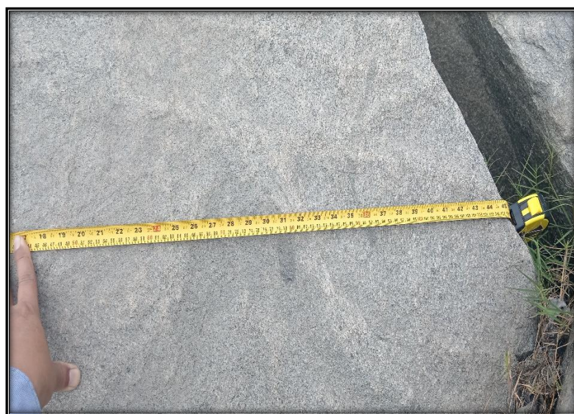
FOTO 06: En el proceso de obtener datos, se toma la medida de una de las rocas colocadas en el talud.
