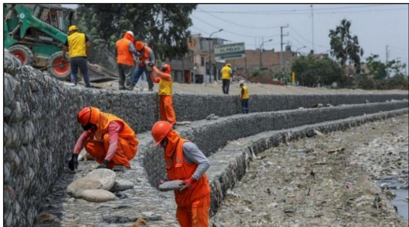
Figura 12: Construcción de Defensa Ribereña
