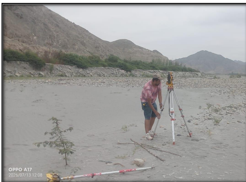
FOTO 02: Con fecha 13/07/2026, se observa el inicio de la defensa ribereña en el km 0+000.
