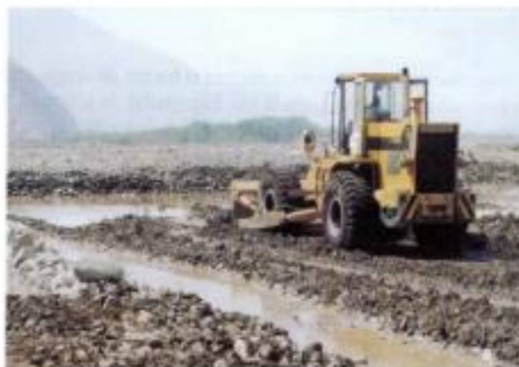
Foto N°3- Preparación de vía de acceso
