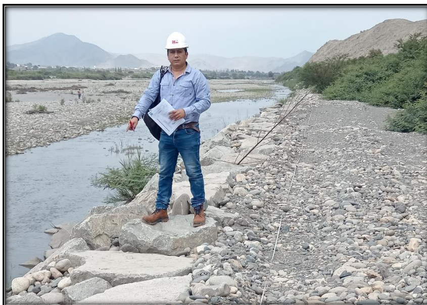
FOTO 07: Desplazándome sobre la corona del dique enrocado, tomando las medidas longitudinales. Se observa la vegetación que se expande de manera invasiva
