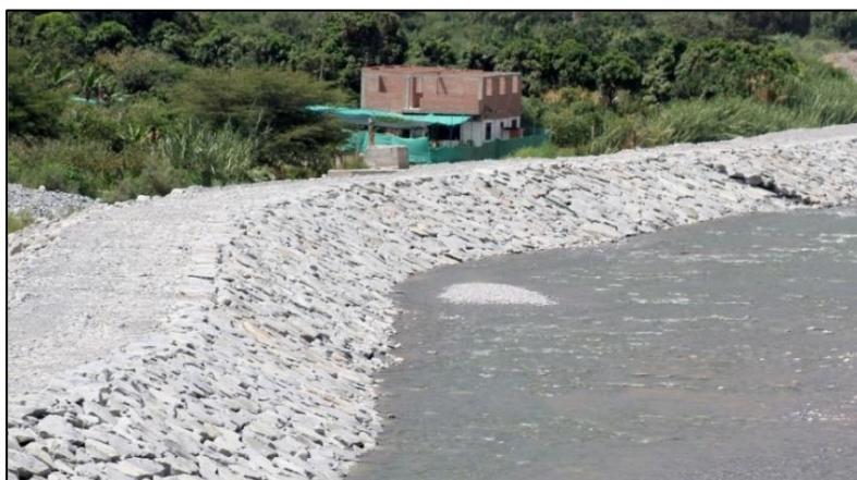
Figura 17: Defensa ribereña con enrocado – río Cañete
