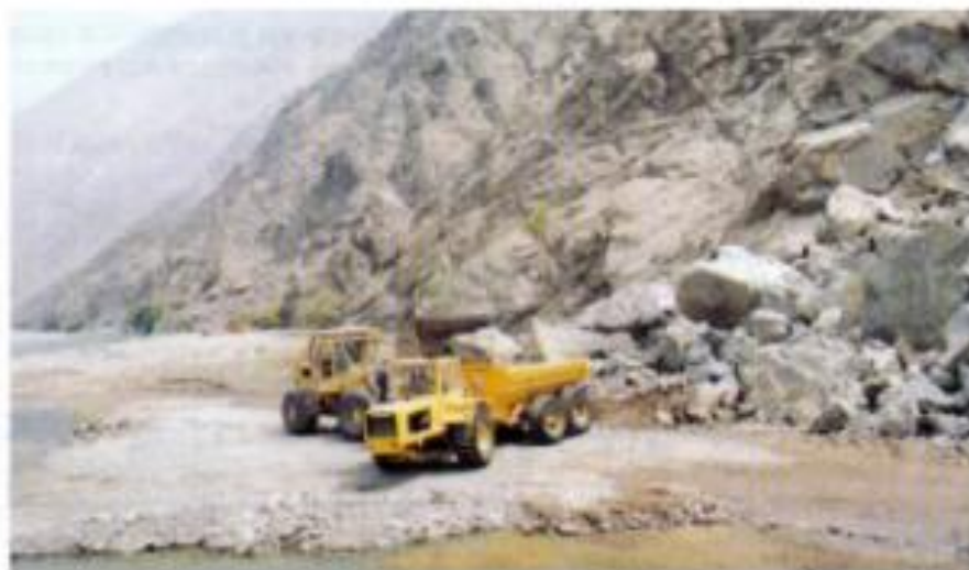
Foto N°6-Carguío de roca con equipo
