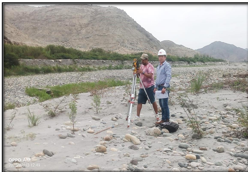
FOTO 01: Con fecha 13/07/2026, se realizó la toma de datos de campo y a la vez se realizó el levantamiento topográfico de la zona de estudio.
