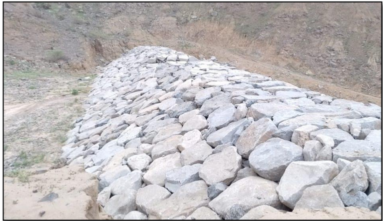
Figura 1: Dique enrocado excelente
