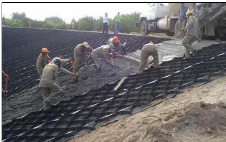
Figura 25: Geoceldas colocación en obra
