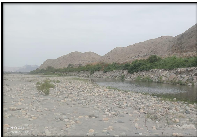
FOTO 03: Se observa el tramo final km 0+500 de la defensa ribereña del margen derecho.
