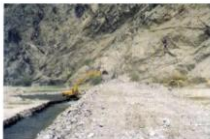
Foto N°4. Tractor iniciando armado de terraplén
