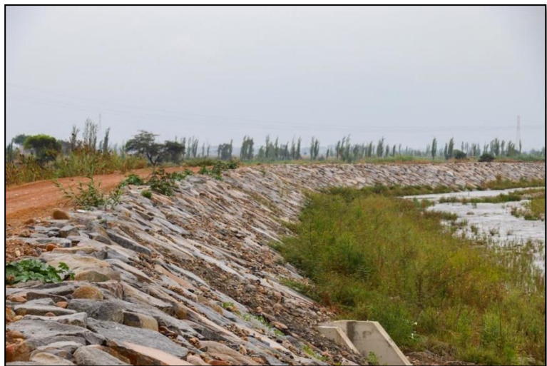
Figura 2: Dique enrocado buen estado
