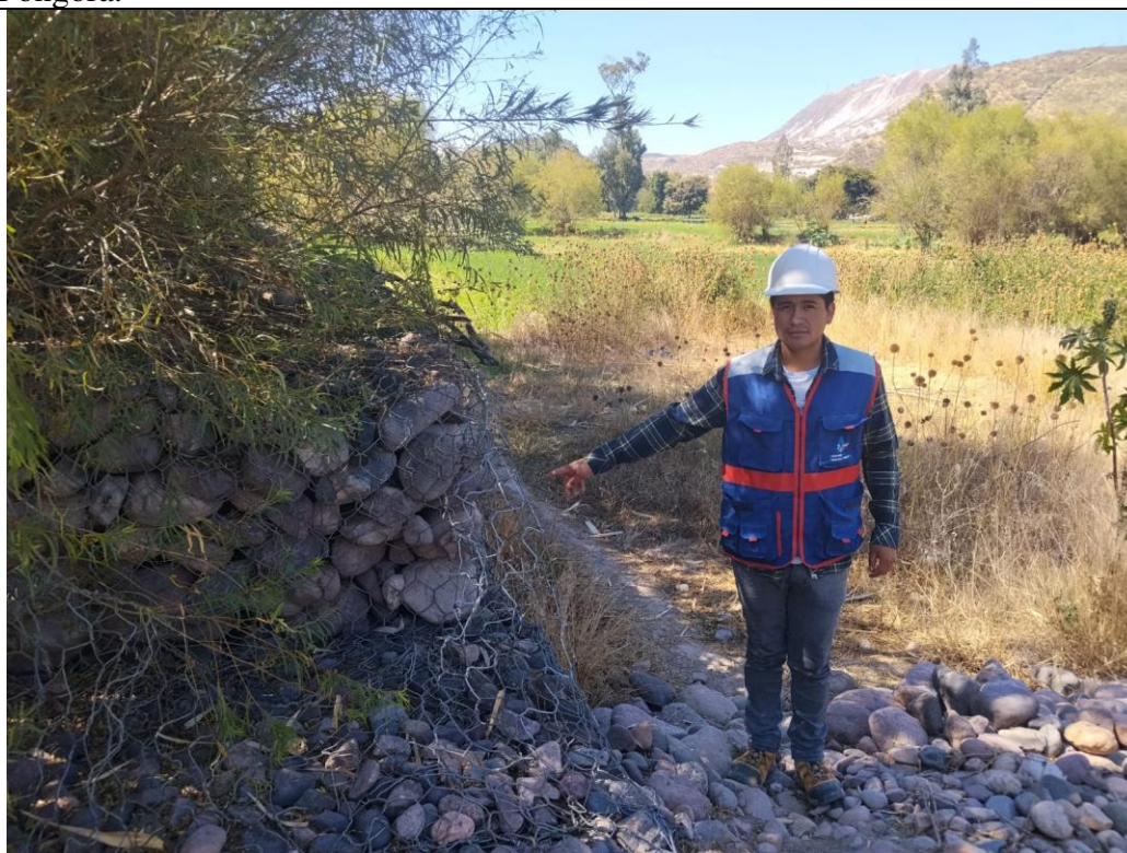
Fotografía 02: Evaluación del estado de conservación de la malla y el relleno del gavión.
