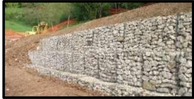
Figura 7: Gaviones tipo muro de contención
