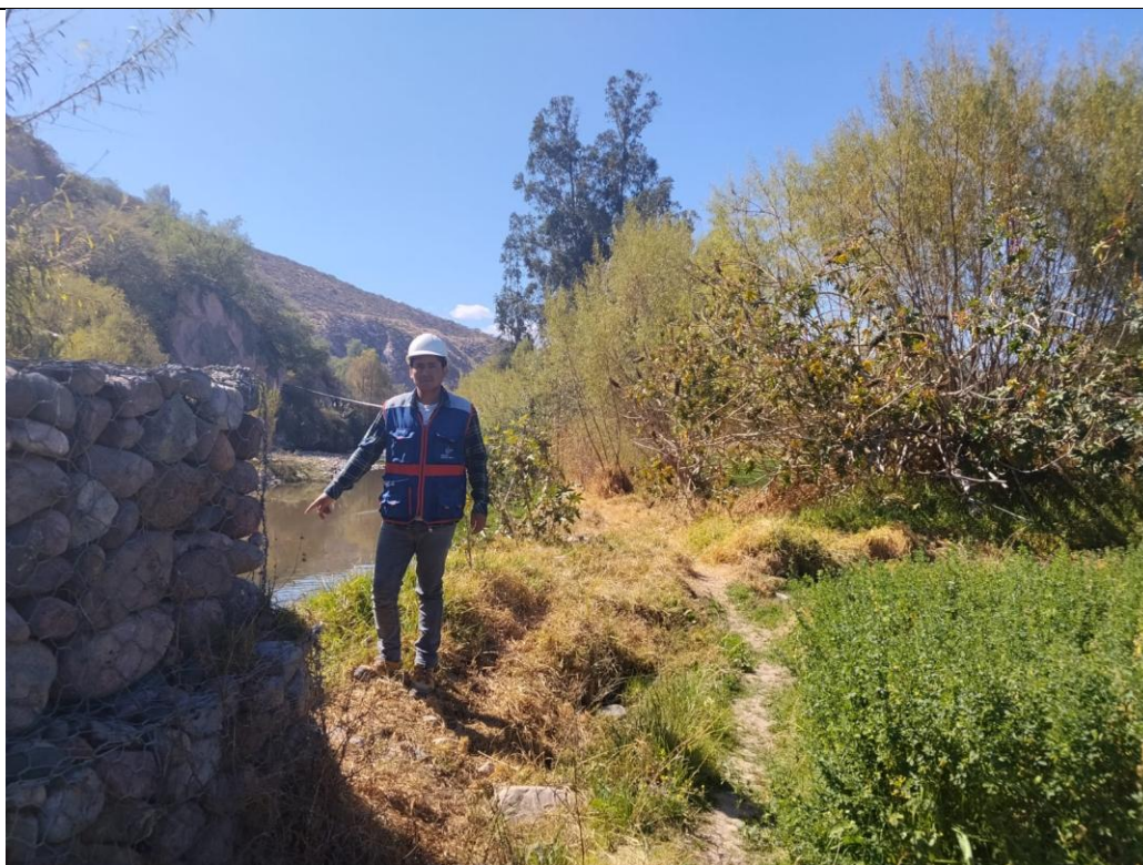
Fotografía 01: Reconocimiento de campo e inspección visual en la margen derecha del río Pongora.
