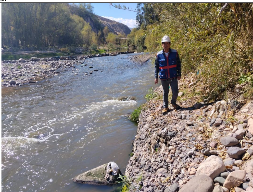
Fotografía 10: Reducción del borde libre y exposición de la corona del muro basal.
