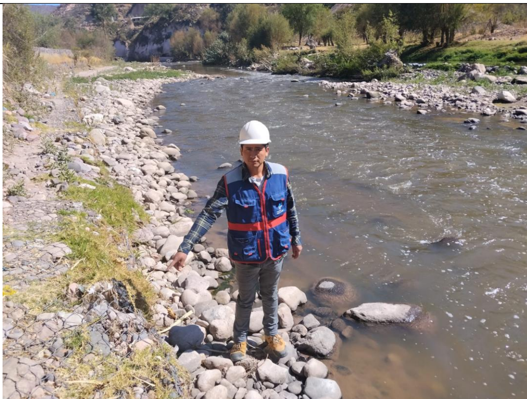
Fotografía 08: Evidencia de procesos de erosión fluvial dinámica en el tramo crítico evaluado.
