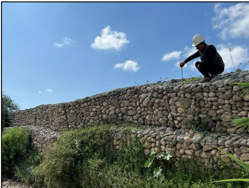
Descripcion: Medicion de altura de gavion según tramo
