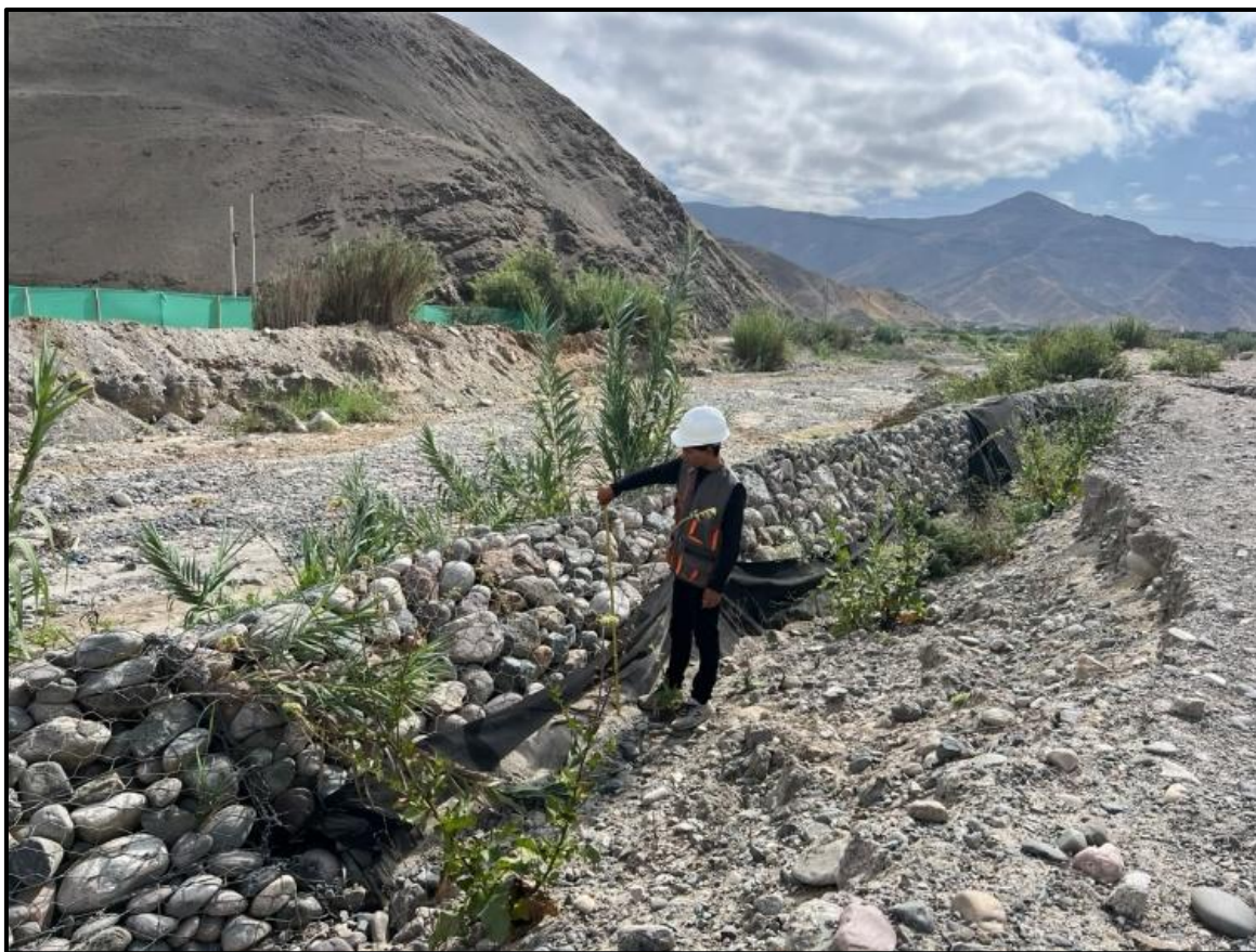
Figura 12: Evidencia de campo tramo 03
