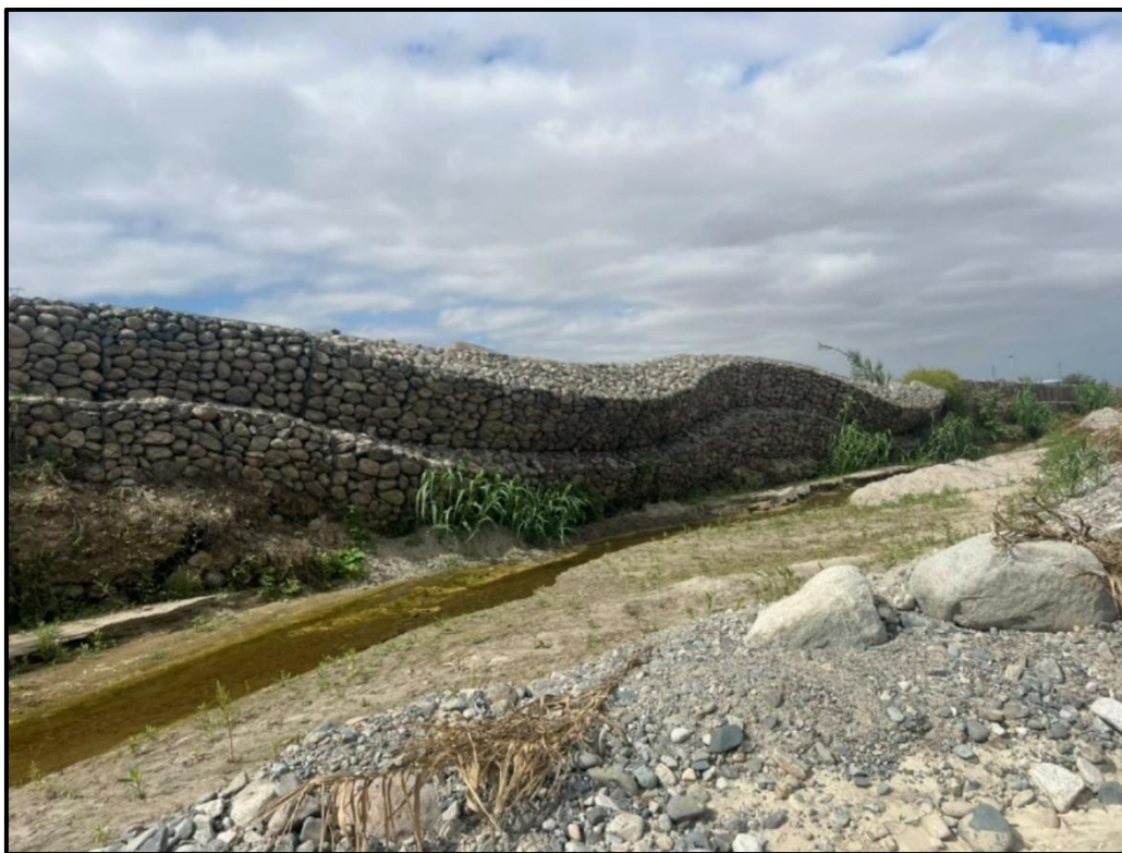
Figura 14: Evidencia de campo tramo 05
