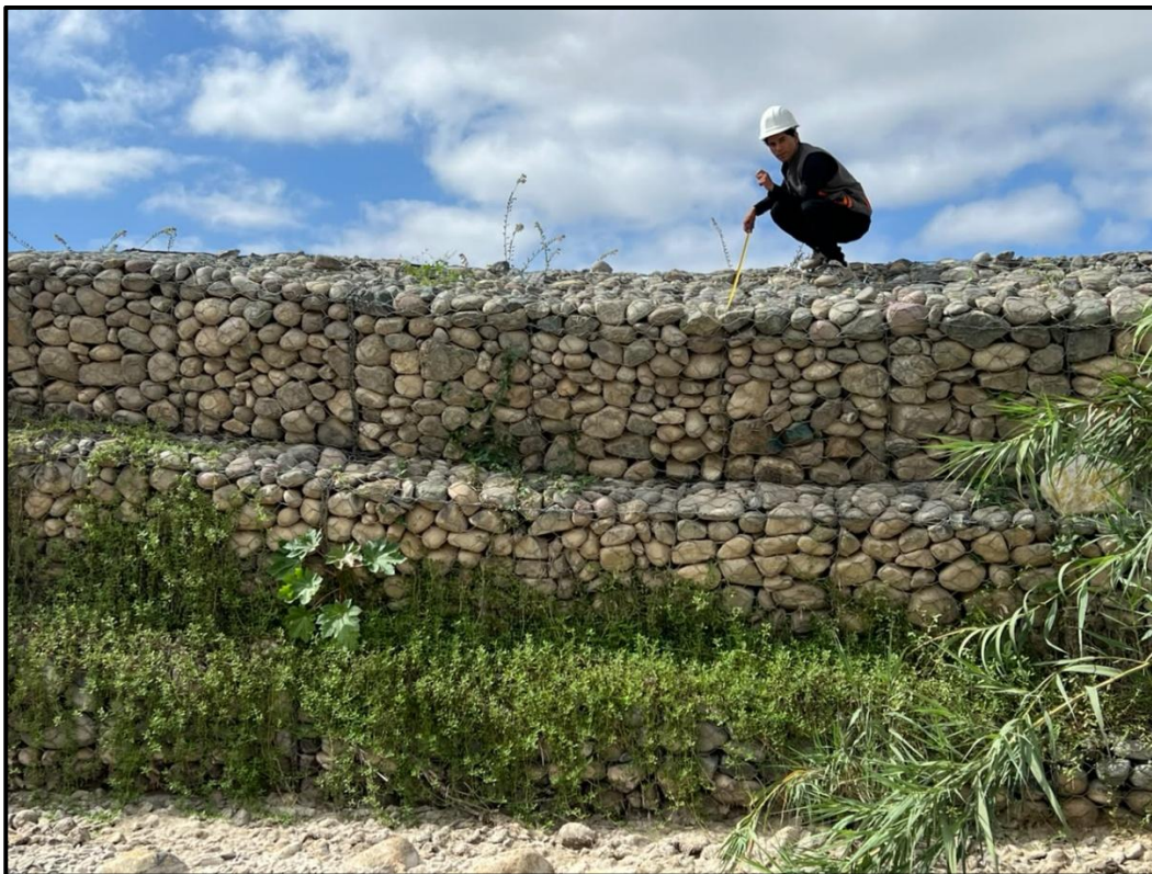
Descripcion: Medicion de ancho de muro de gaviones en siguiente tramo
