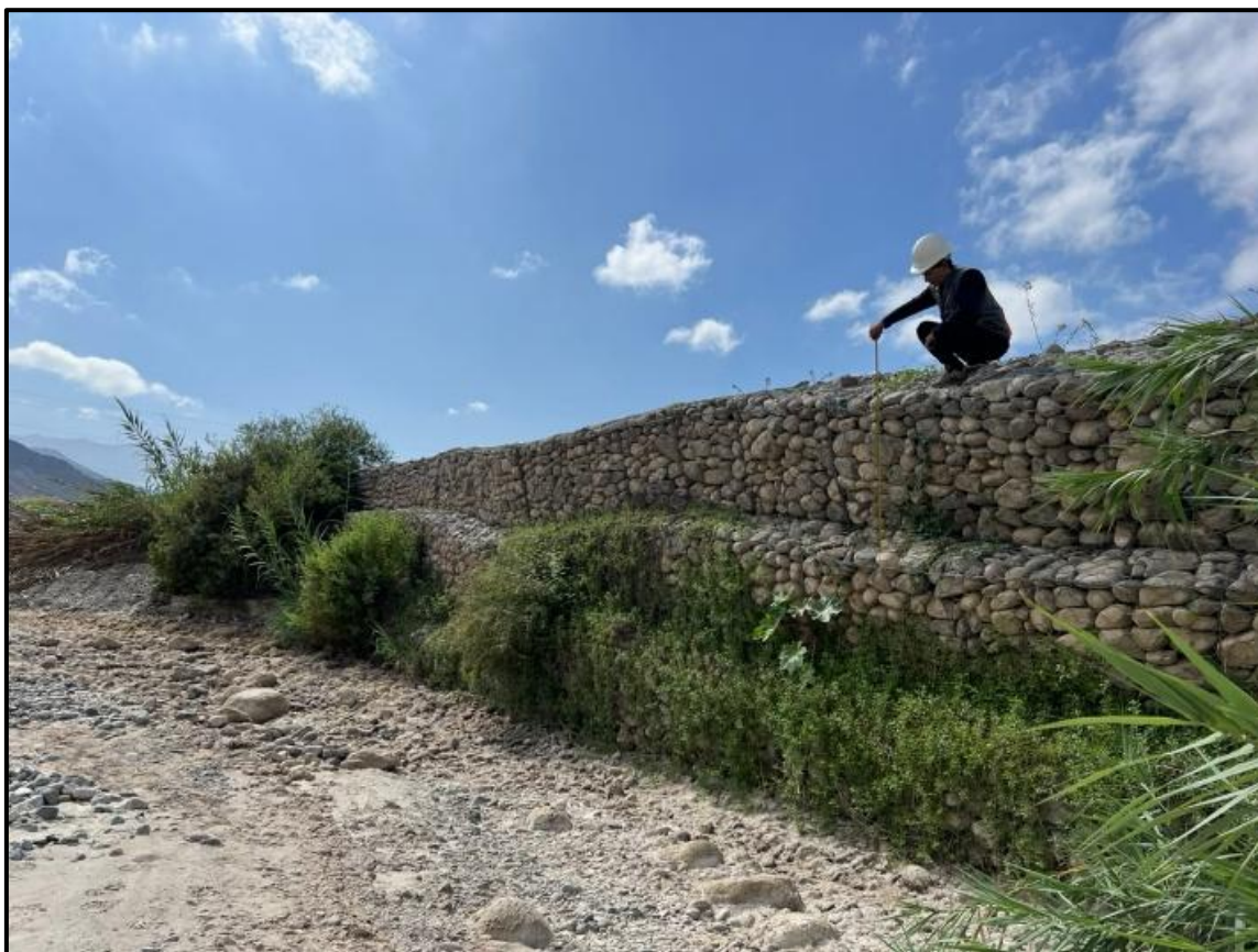
Figura 11: Evidencia de campo tramo 02
