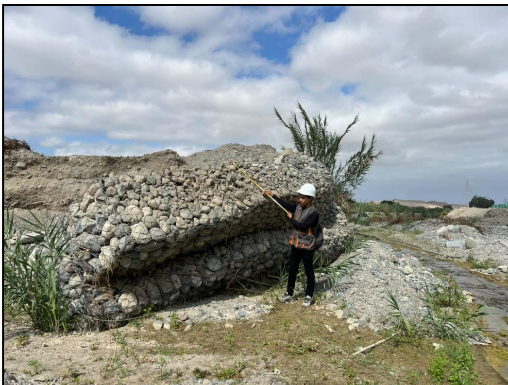
Descripcion: Medicion de ancho de muro de gaviones, segundo nivel
