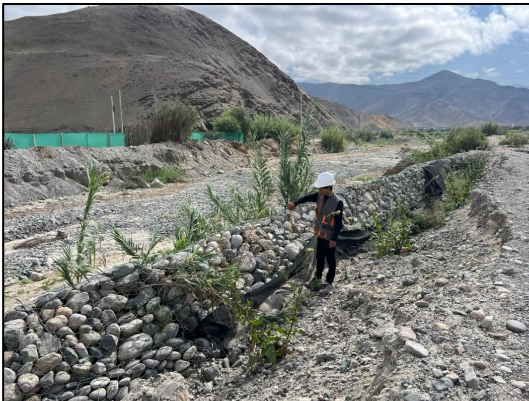
Descripcion: Medicion de altura de volteamiento de defensa ribereña
