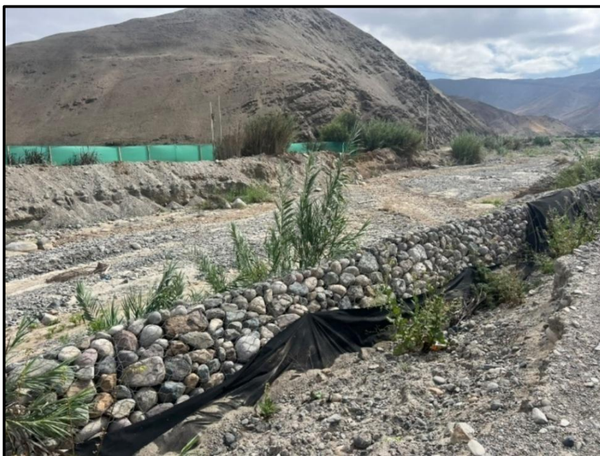
Figura 13: Evidencia de campo tramo 04
