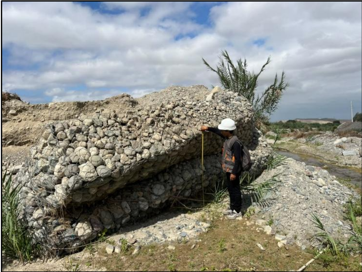
Figura 10: Evidencia de campo tramo 01 Fuente: Evidencia de campo 2026
