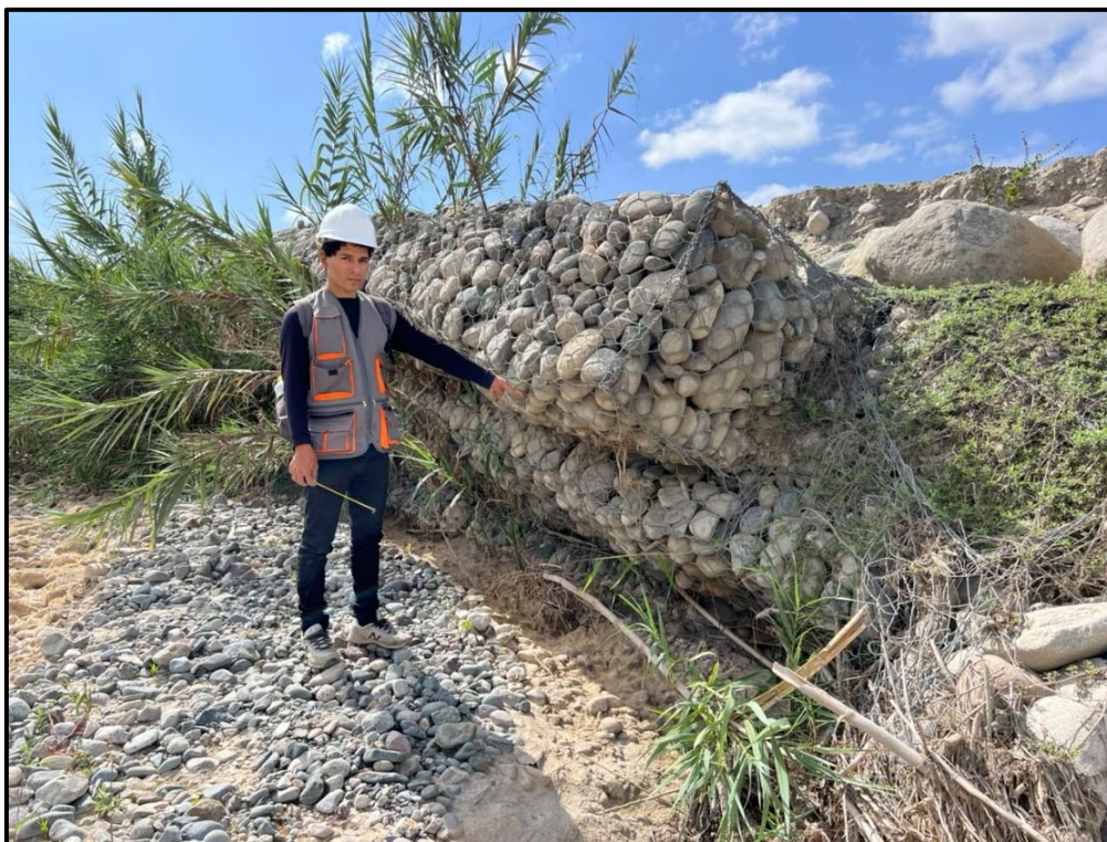
Figura 15: Evidencia de campo tramo 06
