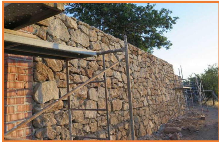
Figura 07: Muros de mampostería
