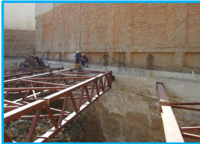
Figura 08: Muros de pantalla
