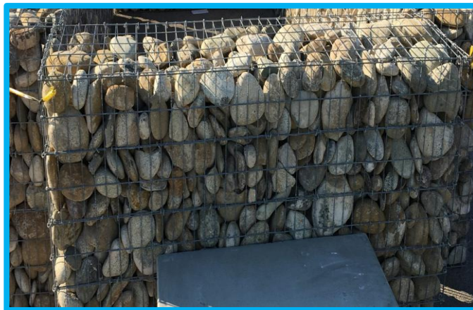
Figura 11: Muro de Gaviones
