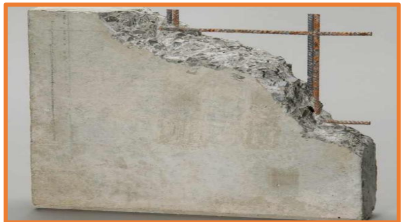
Figura 06: Muro de Hormigón armado
