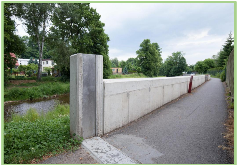
Figura 32: Defensa ribereña de concreto armado
