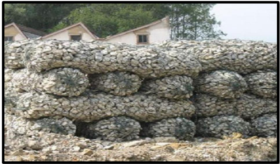
Figura: N° 3: Gavión tipo saco
