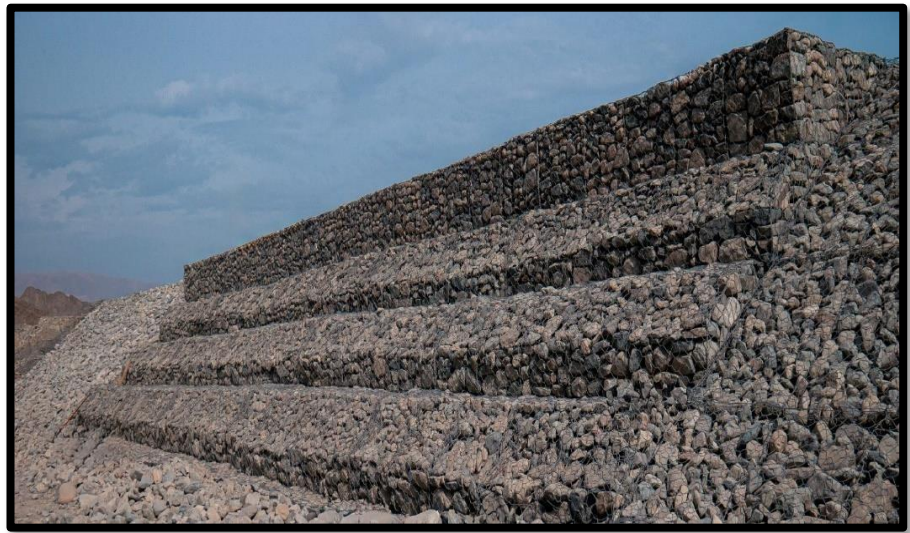
Figura 2: Gavión tipo caja
