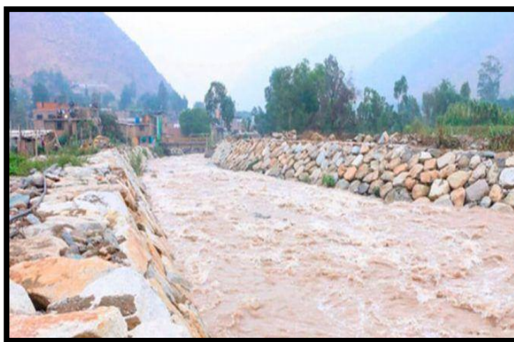
Figura 1. Estructura de defensa ribereña para la protección marginal de un cauce.
