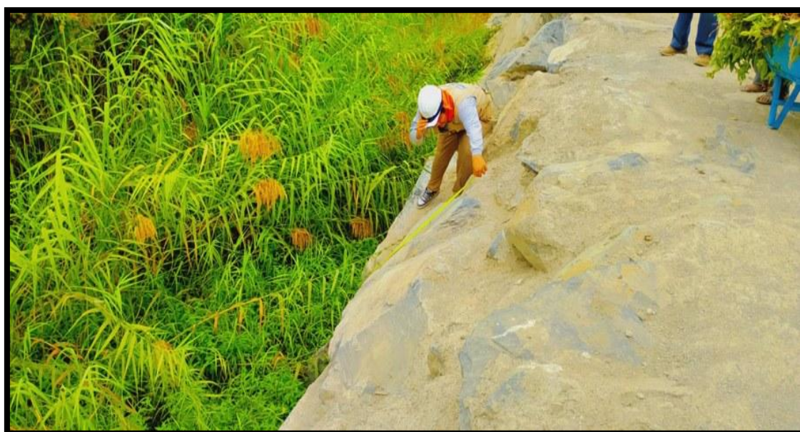
Figura 14. Medición del talud del enrocado
