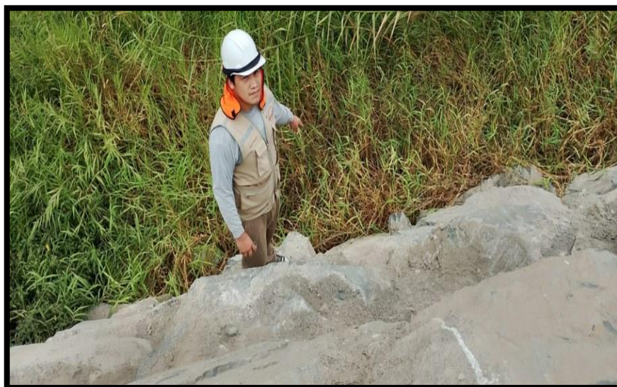
Figura 20. Vegetación en la uña del enrocado
