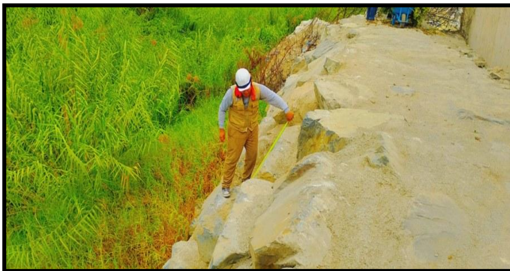
Figura 25. Enrocado colindante a muro de concreto
