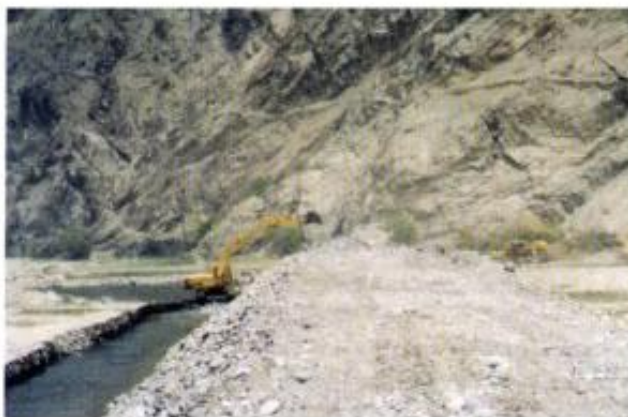
Foto N°4. Tractor iniciando armado de terraplén
