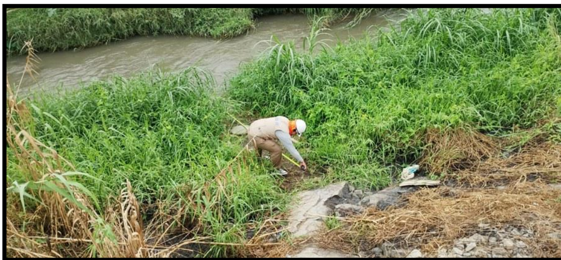
Figura 22. Pie del enrocado colindante al cauce
