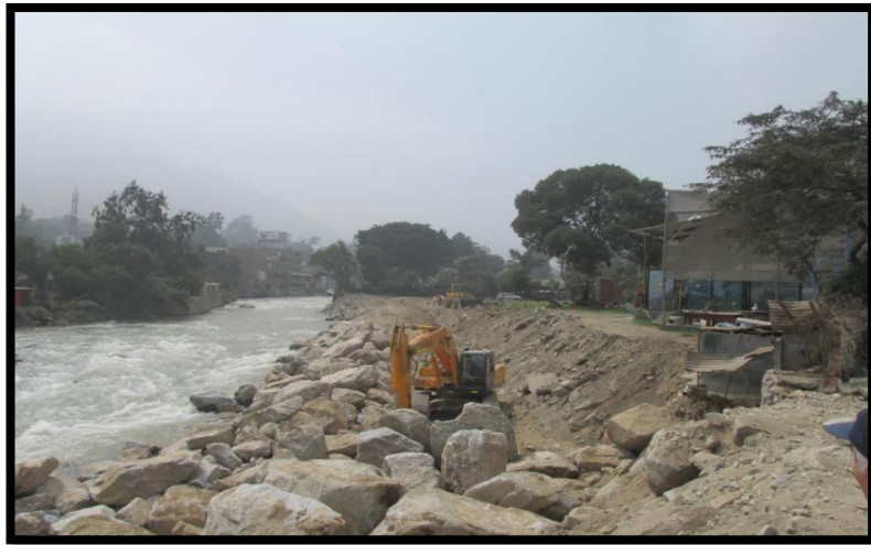
Figura 6. Proceso constructivo y colocación de unidades de roca.
