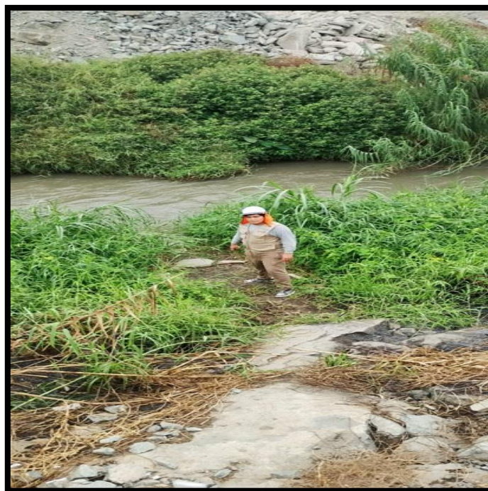
Figura 21. Vista desde la uña del enrocado
