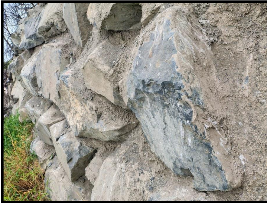
Figura 15. Fotografía del talud del enrocado
