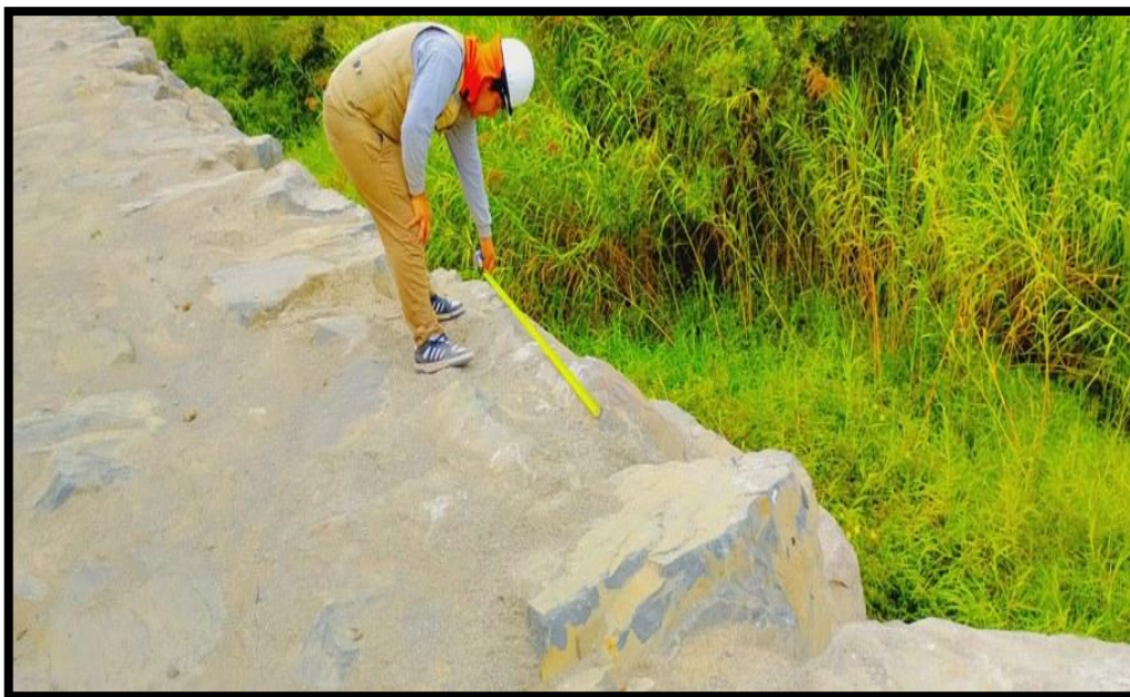
Figura 13. Fotografía en el enrocado, inicio del tramo progresiva 0+500
