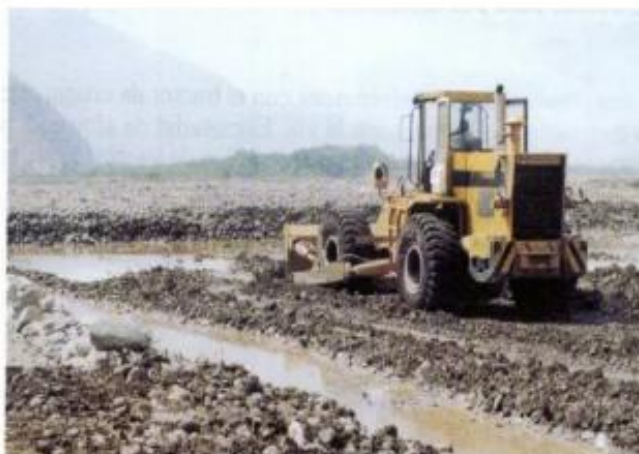
Foto N°3- Preparación de vía de acceso
