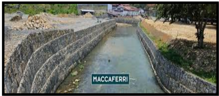
Figura 3: Muro de gaviones
