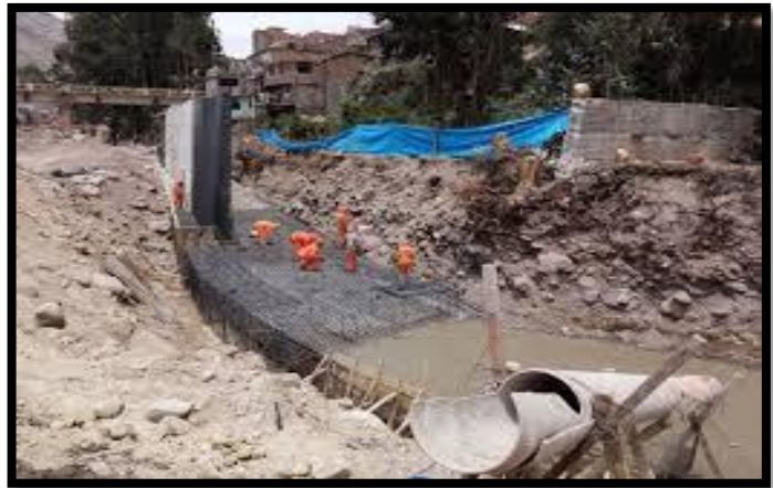
Figura 8: Cimentación de una defensa ribereña
