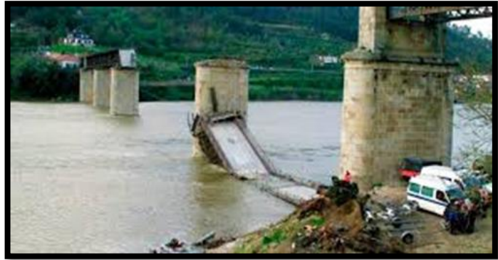
Figura 15: Socavación
