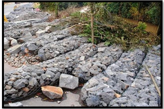
Figura 14: Gavión tipo saco
