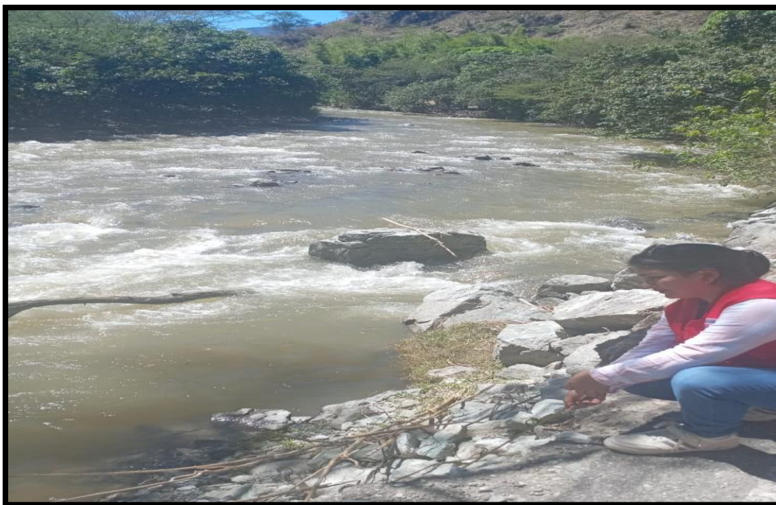
Figura 42: Medición de las condiciones del margen izquierdo del río Quiroz durante la inspección de campo en el tramo 0+200 – 0+250.
