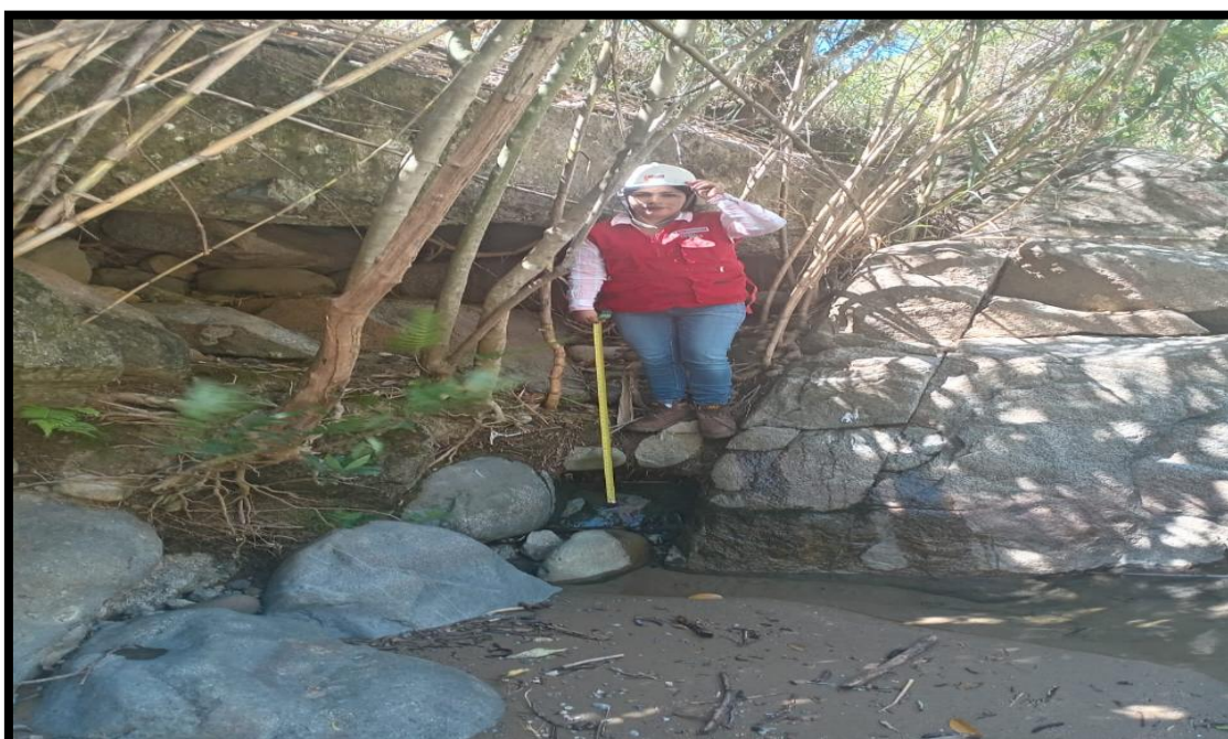
Figura 63: Medición directa del nivel de socavación y descalce en la base del margen del río Quiroz.
