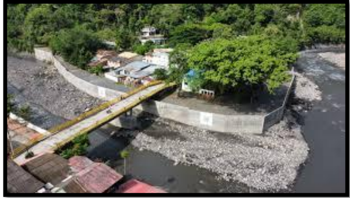
Figura 6: Muros de contención
