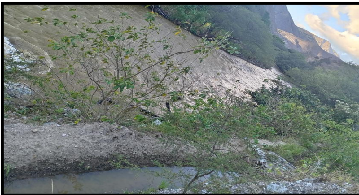
Figura 36: Vista general del tramo 0+150–0+200 del margen izquierdo del río Quiroz
