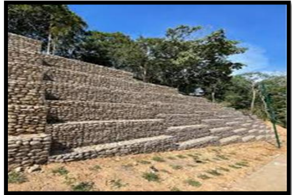
Figura 12: Muro de gavión tipo caja
