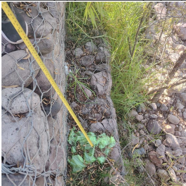
Foto 08: Toma de medidas de gavi3n en r3o Huatatas, tramo 0+605 – 0+705 C.P. Glorieta, distrito Andr3s Avelino C3ceres Dorregaray, provincia de Huamanga, regi3n Ayacucho.
