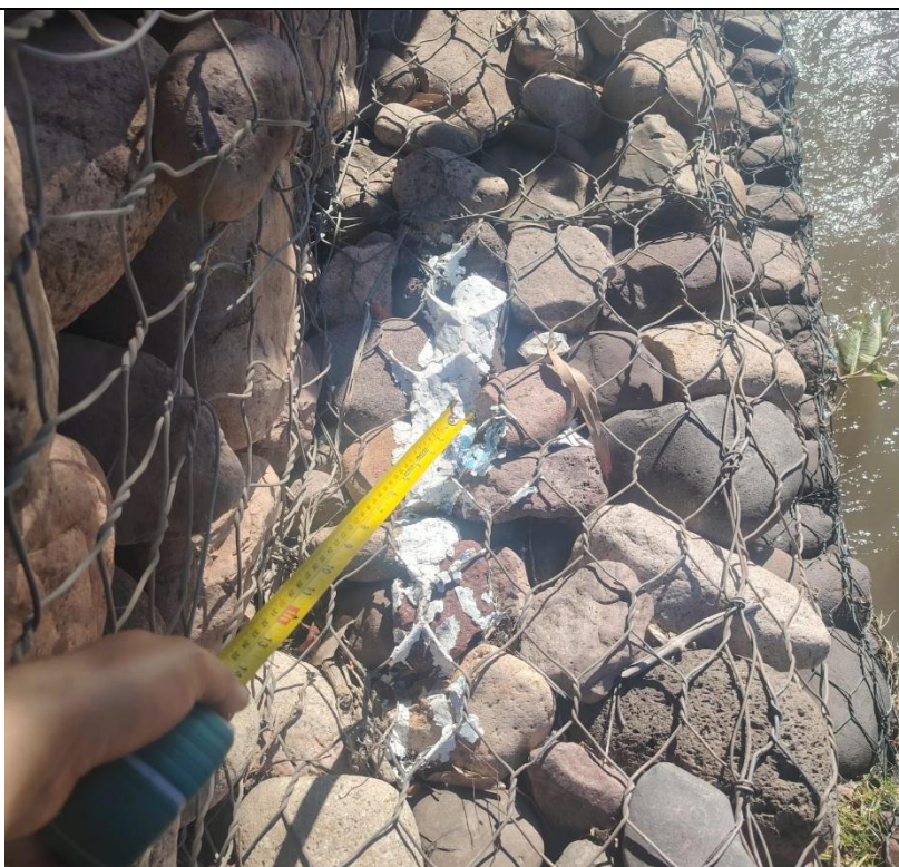
Foto 09: Presencia de deformación de muro de gavión en río Huatatas, tramo 0+605 – 0+705 C.P. Glorieta, distrito Andrés Avelino Cáceres Dorregaray, provincia de Huamanga, región Ayacucho.
