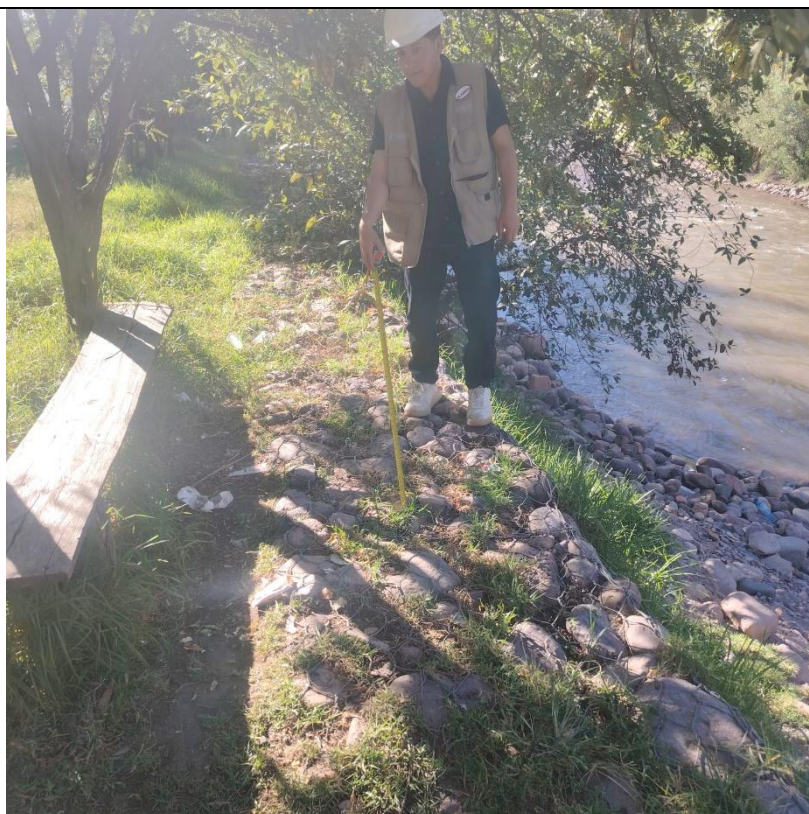
Foto 05: Evaluación de estado del río Huatatas, tramo 0+555 - 0+605 C.P. Glorieta, distrito Andrés Avelino Cáceres Dorregaray, provincia de Huamanga, región Ayacucho.
