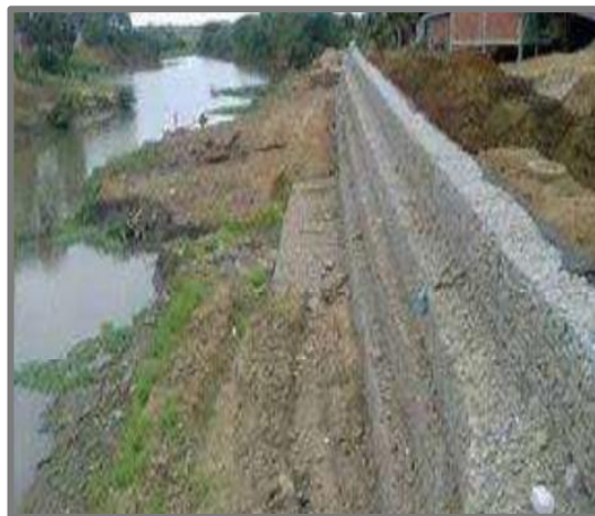
Figura 25: Muro de gaviones
