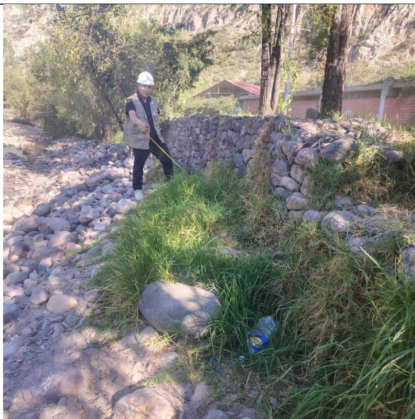
Foto 09: Presencia de deformación de muro de gavión en río Huatatas, tramo 0+605 – 0+705 C.P. Glorieta, distrito Andrés Avelino Cáceres Dorregaray, provincia de Huamanga, región Ayacucho.
