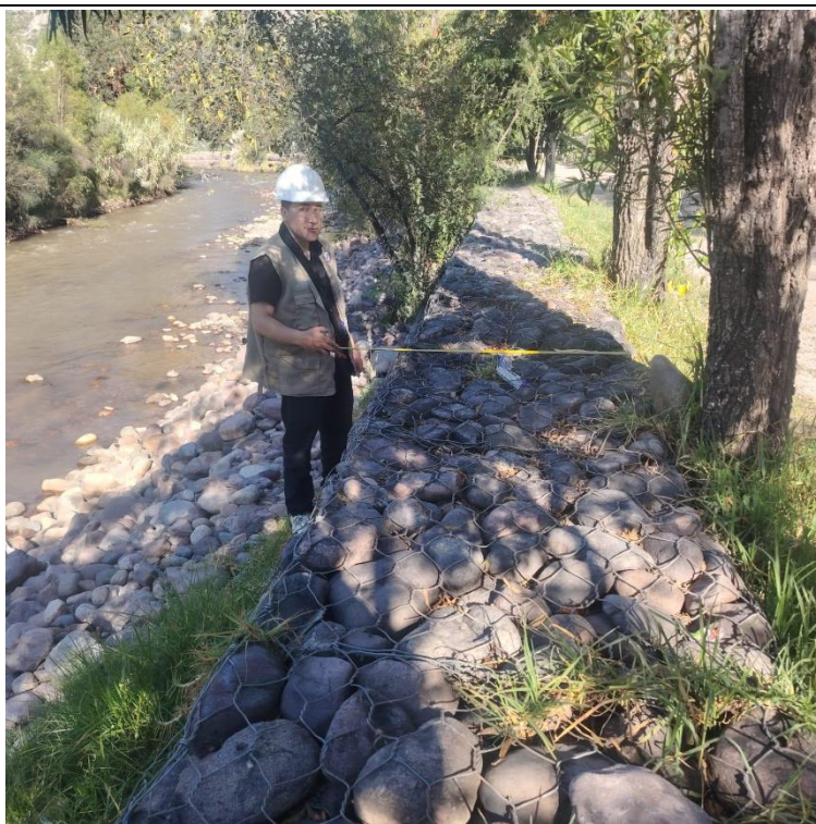
Foto 02: Toma de medida de taba del muro de gavión del río Huatatas, tramo 0+505 - 0+555 C.P. Glorieta, distrito Andrés Avelino Cáceres Dorregaray, provincia de Huamanga, región Ayacucho.
