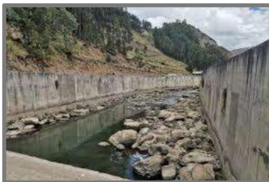
Figura 24: Muros de concreto armado
