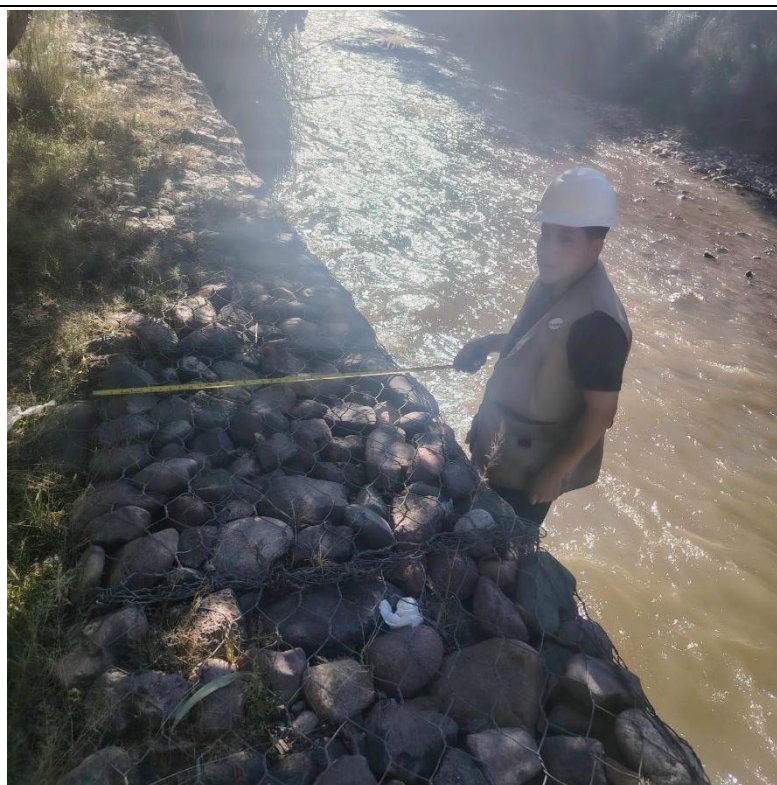
Foto 13: Toma de medida de muro de gaviones en río Huatatas, tramo 0+755 - 0+760 C.P. Glorieta, distrito Andrés Avelino Cáceres Dorregaray, provincia de Huamanga, región Ayacucho.
