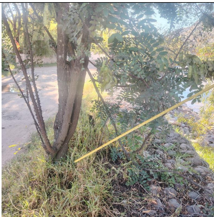
Foto 11: Zona con presencia de vegetación abundante en el río Huatatas, tramo 0+705 – 0+755 C.P. Glorieta, distrito Andrés Avelino Cáceres Dorregaray, provincia de Huamanga, región Ayacucho.
