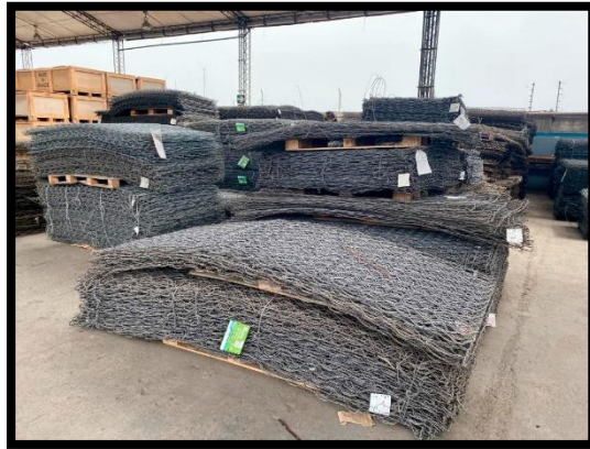
Figura 03: Gavión tipo saco
