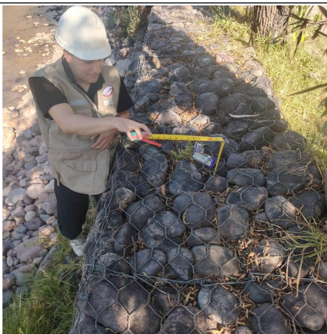
Foto 12: Toma de medidas en el muro de gabión, en el río Huatatas, tramo 0+705 – 0+755 C.P. Glorieta, distrito Andrés Avelino Cáceres Dorregaray, provincia de Huamanga, región Ayacucho.
