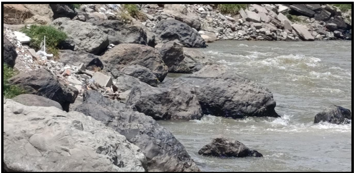
Figura 08. Material petreo en el lado derecho del río santa (Aguas arriba, contiguo a la confluencia del río seco, 0+000.00)
