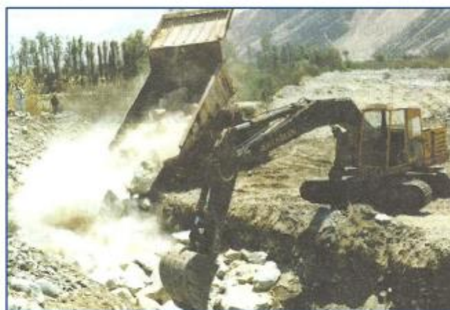
Figura 22. Excavadora colocando roca en la uña
