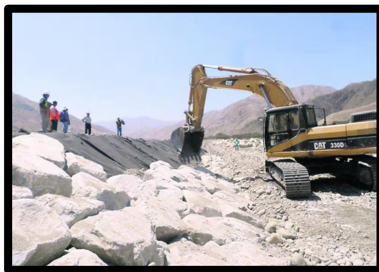
Figura 07: el enrocado en Río El Ingenio
