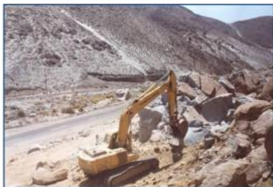
Figura 11. Extracción de roca sin explosivo
