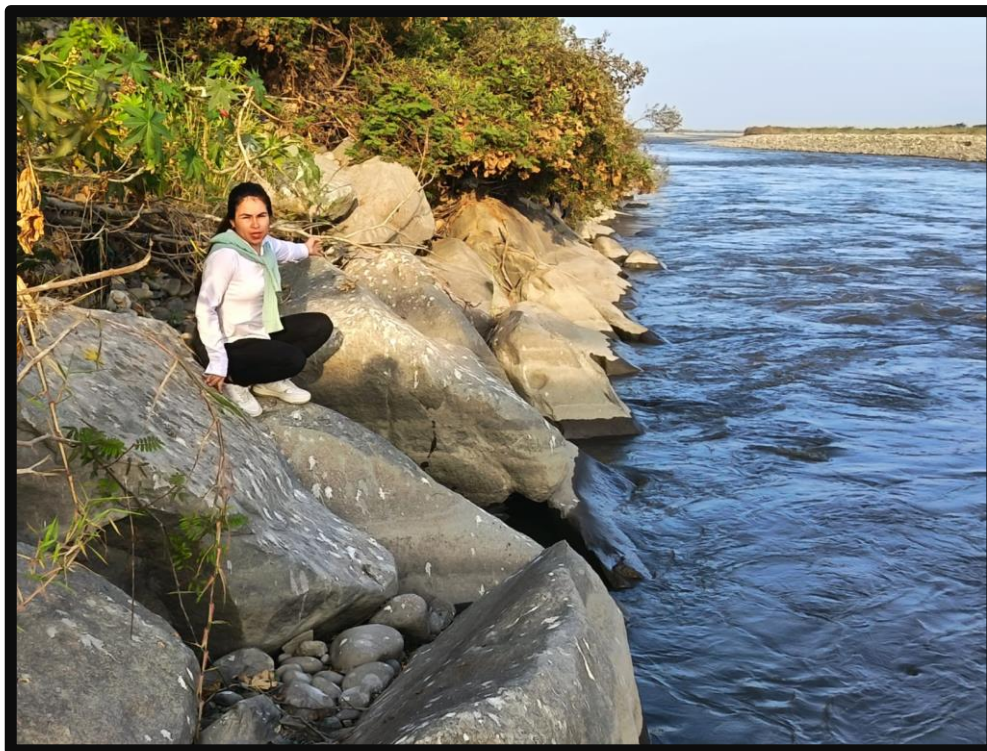
Fotografía 06: Evaluación del tramo 6 del enrocado.
