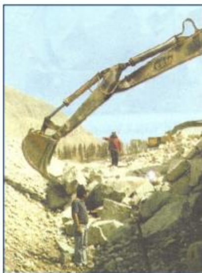
Figura 20. Colocado de roca
