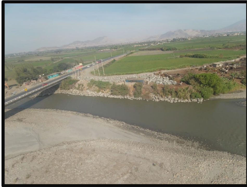
Fotografía 03: Imagen del tramo 2+800 -3+100 del rio Santa.
