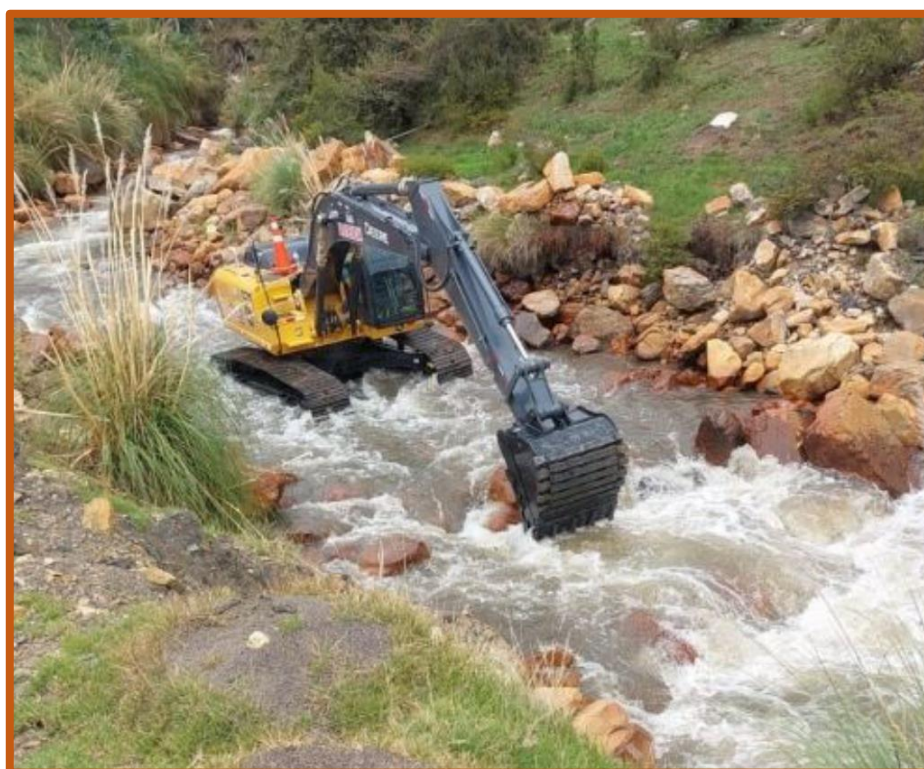
Figura 03: Maquinaria pesada Descolmatando el rio
