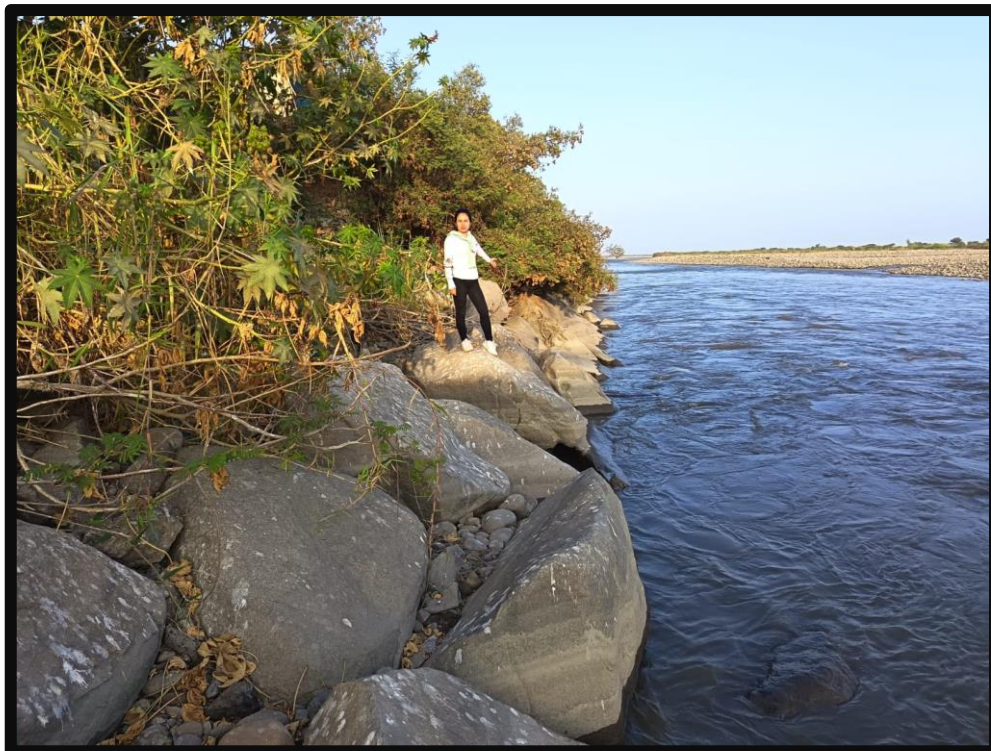
Fotografía 04: Evaluación del tramo 5 del enrocado.
