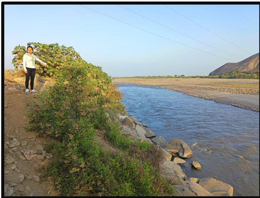
Fotografía 05: Evaluación del tramo 3 del enrocado.
