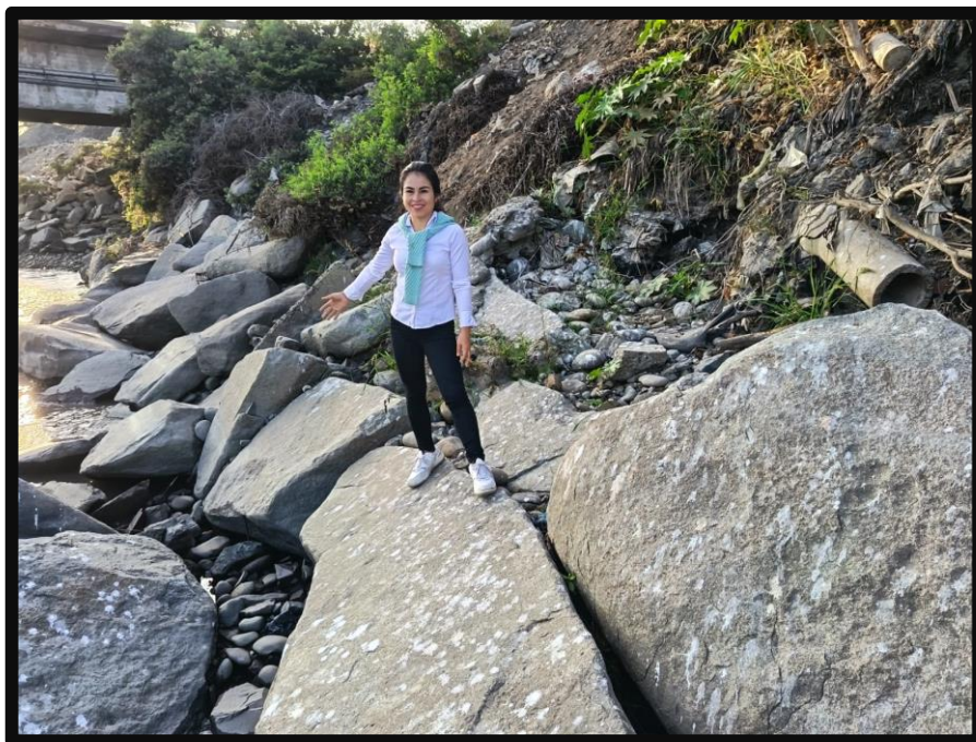
Fotografía 07: Evaluación del tramo 4 del enrocado
