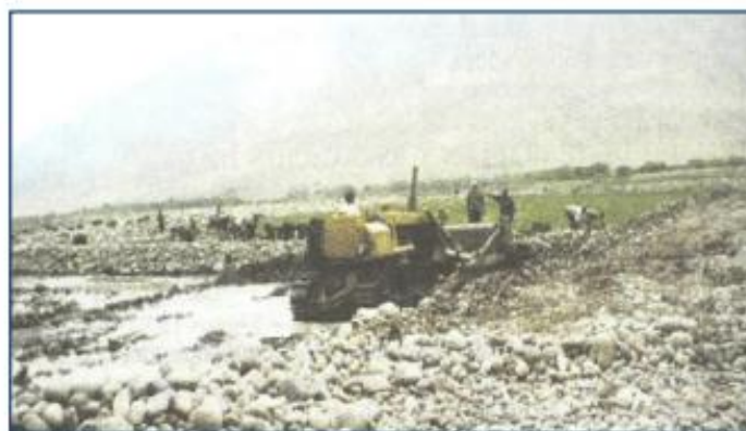
Figura 16. Tractor iniciando armado de terraplen
