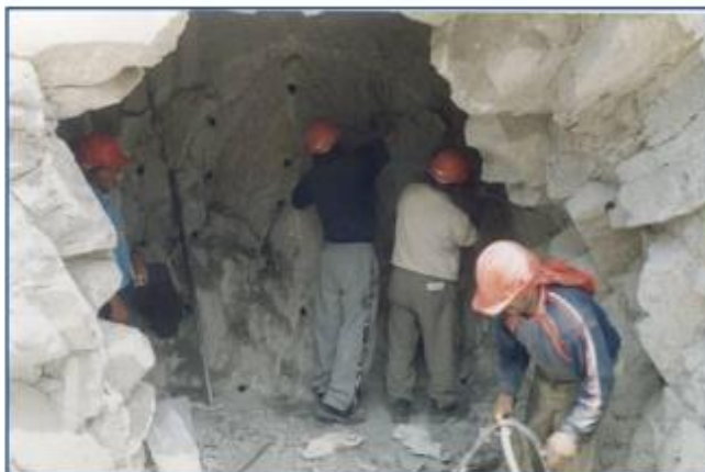
Figura 12. Extracción de roca con explosivos.
