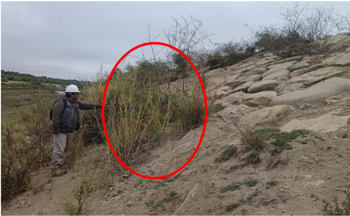
Fotografía 09: Crecimiento de Vegetación entre separación de rocas Prog 0+550 Fuente: Propia
