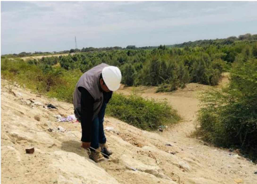
Fotografía 03: Realizando la evaluación del primer tramo, progresiva 0+350 del enrocado Fuente: Propia
