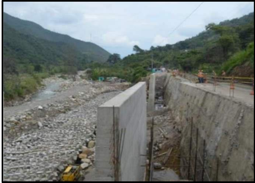
Figura 13: Muros de Concreto Armado
