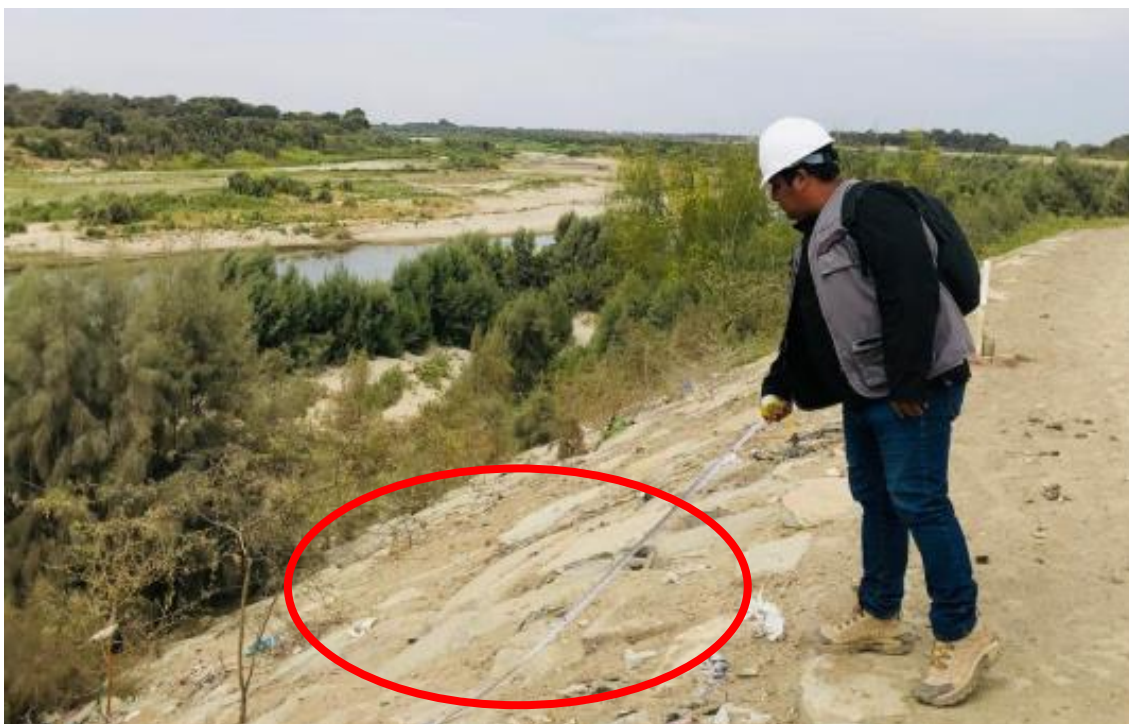
Fotografía 01: Realizando la evaluación del primer tramo del enrocado Fuente: Propia
