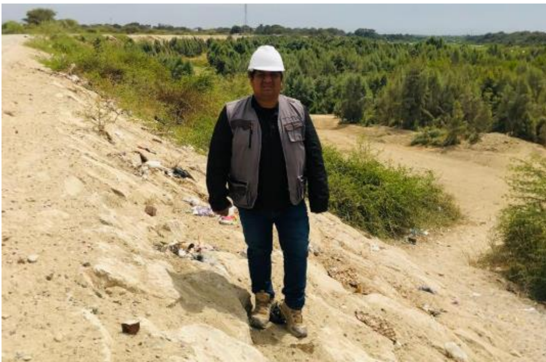
Fotografía 04: Realizando la evaluación del primer tramo, progresiva 0+350 del enrocado Fuente: Propia
