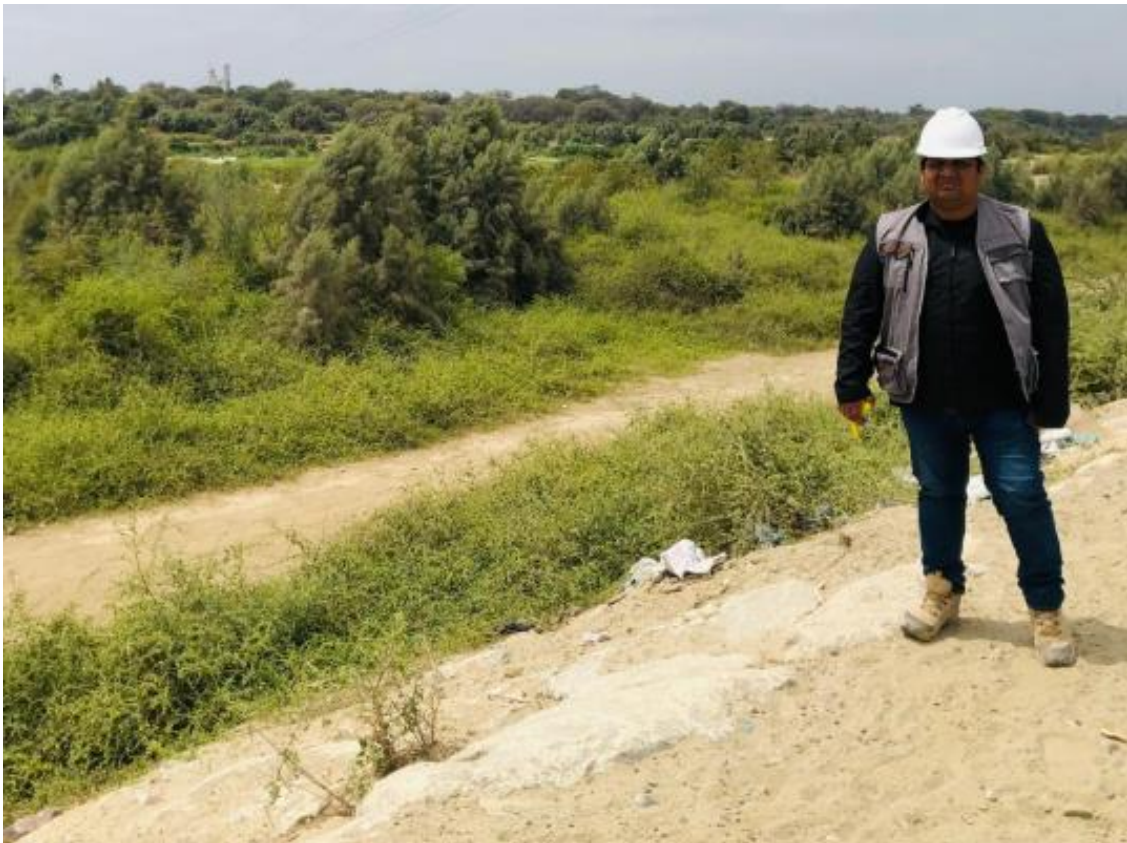
Fotografía 05: Realizando la evaluación del primer tramo, progresiva 0+400 del enrocado Fuente: Propia
