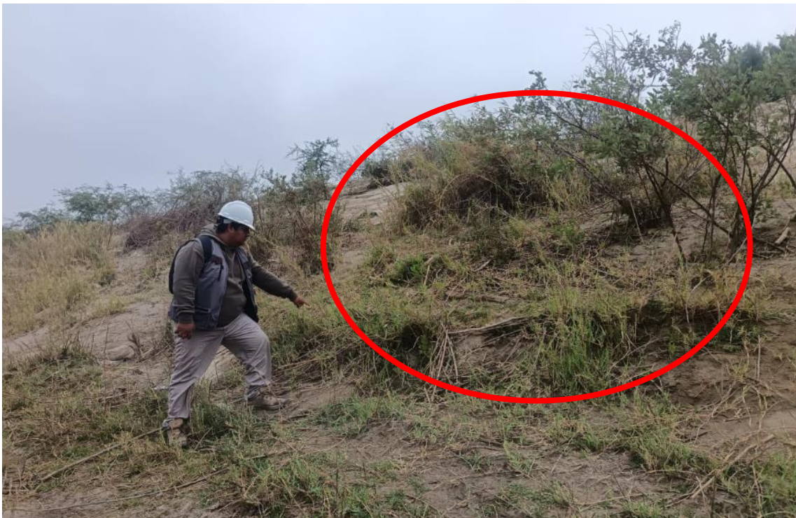
Fotografía 10: Crecimiento de Vegetación entre separación de rocas Prog. 0+400 Fuente: Propia
