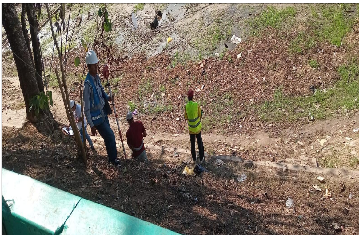
Figura 23: Vista previa al lugar de excavación C-01 y toma de puntos topograficos.
