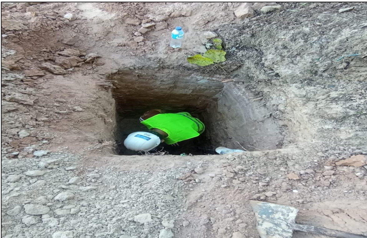
Figura 19: Zona de excavación calicata C-01.
