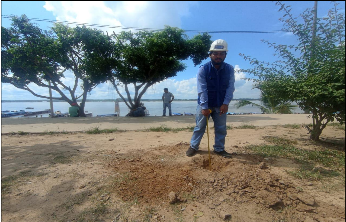
Figura 20: Zona de excavación calicata C-03 con la herramienta manual posteadora.
