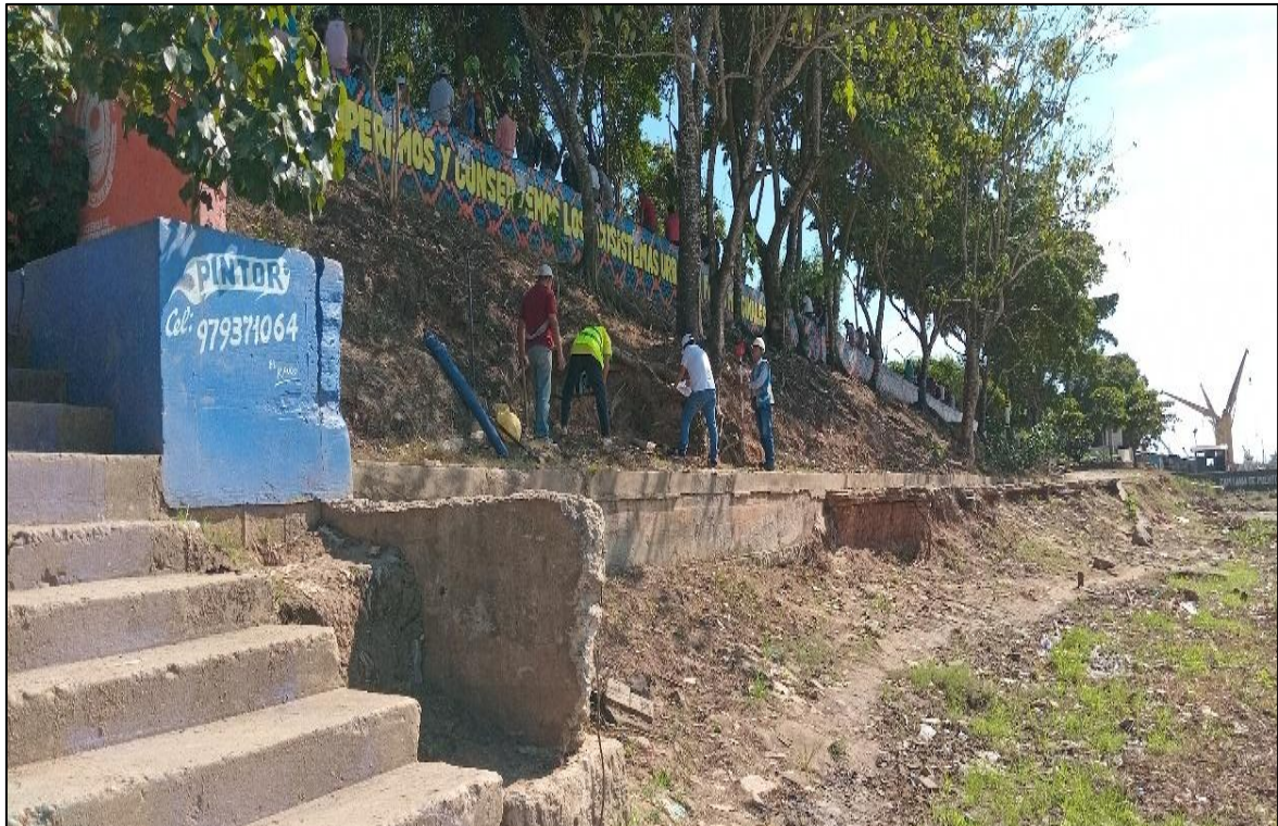
Figura 26: Tramo km 2+500 a km 2+600.
