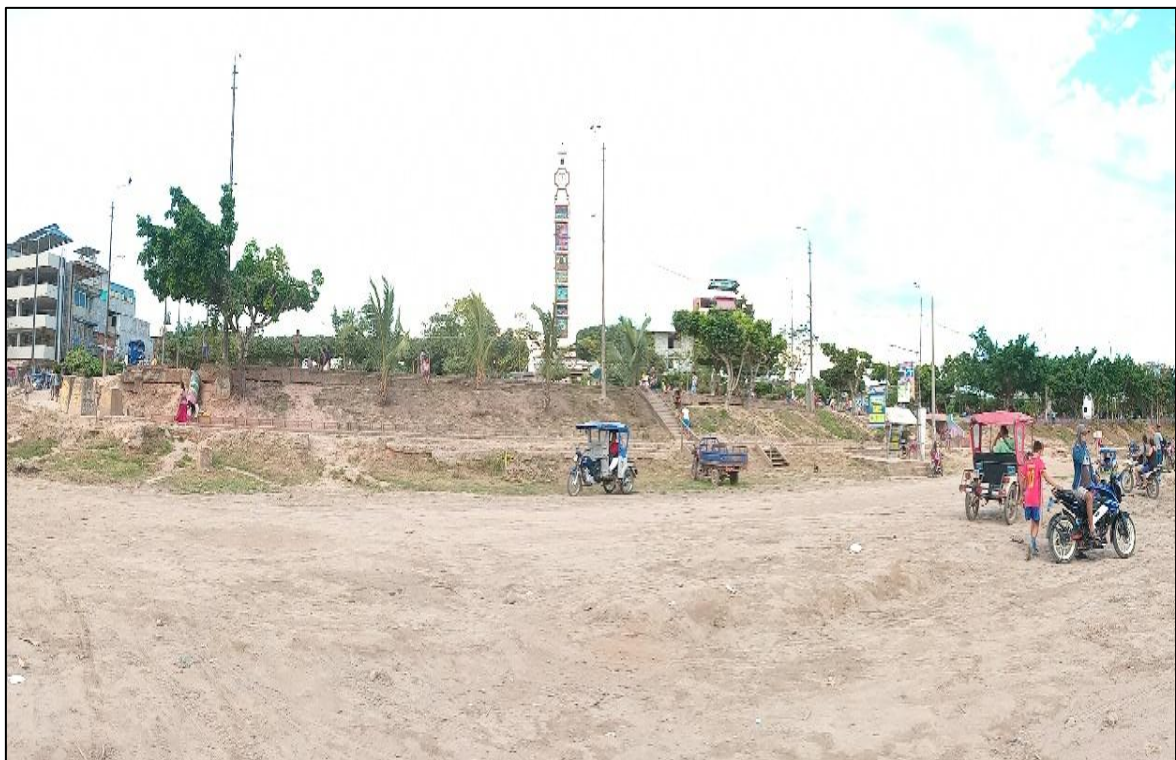
Figura 27: Tramo km 2+700 a km 2+800.
