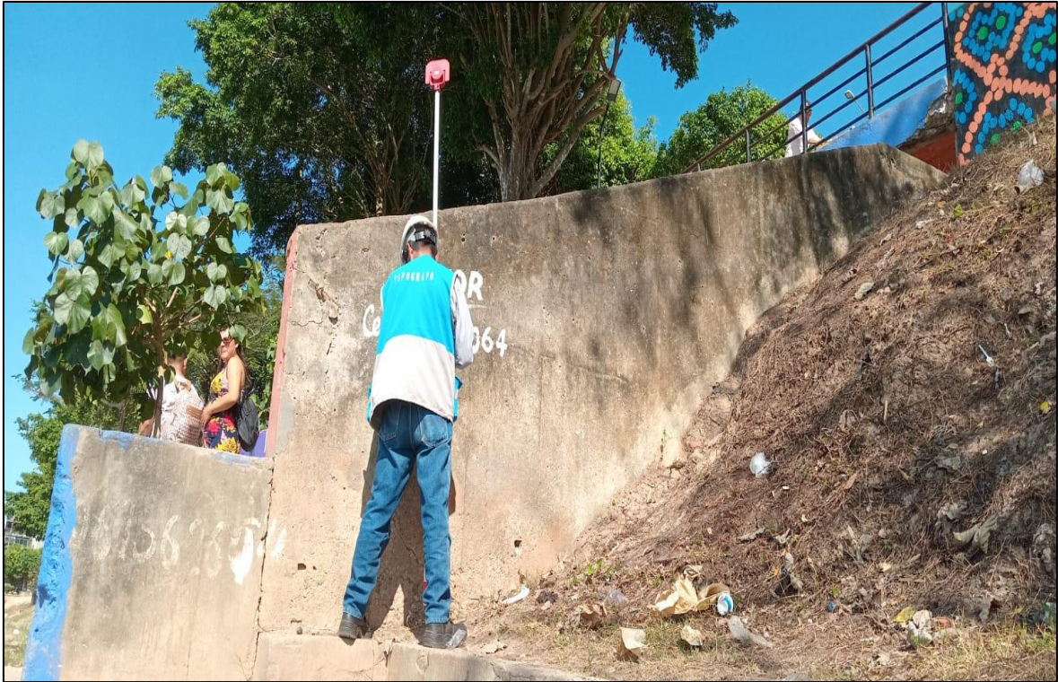
Figura 24: Toma de puntos topográficos.
