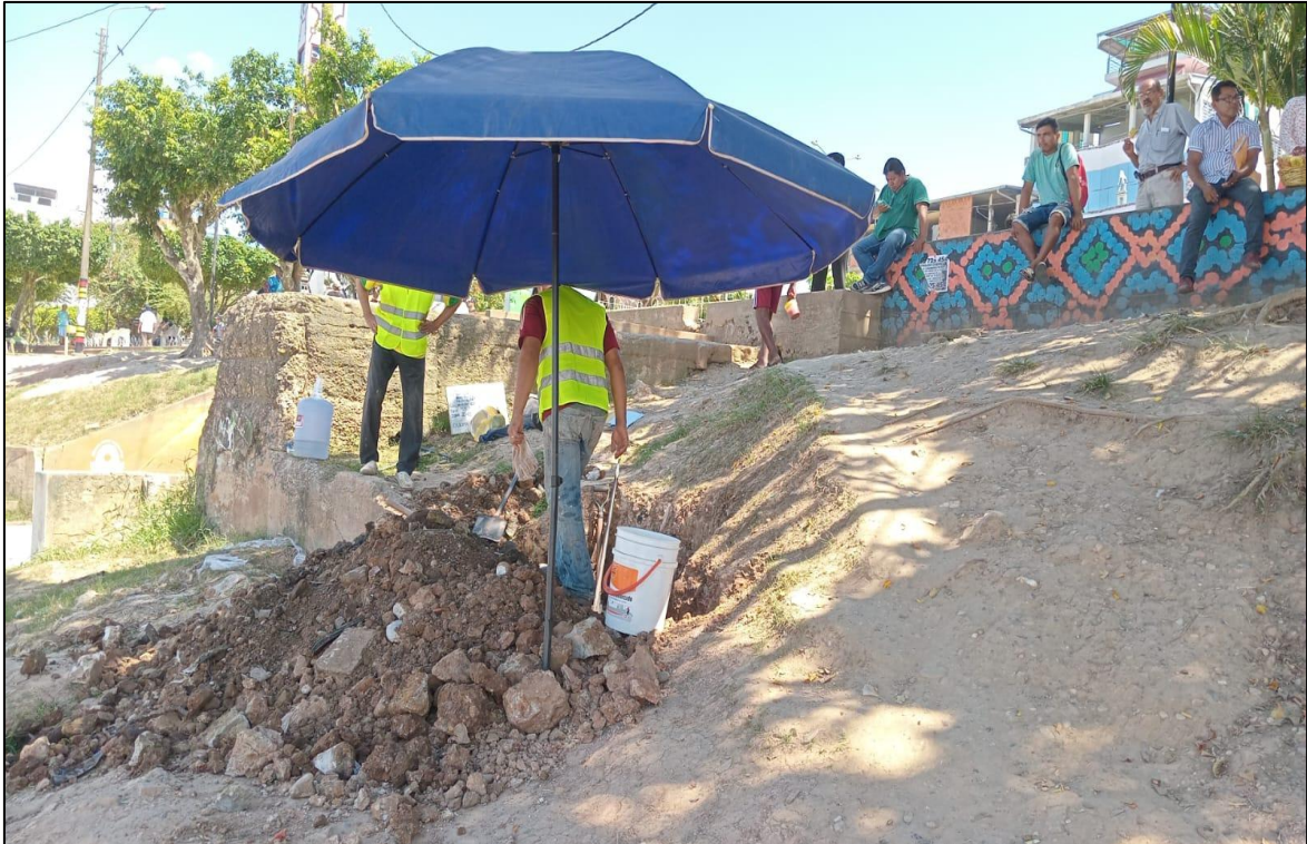
Figura 18: Zona de excavación calicata C-02.
