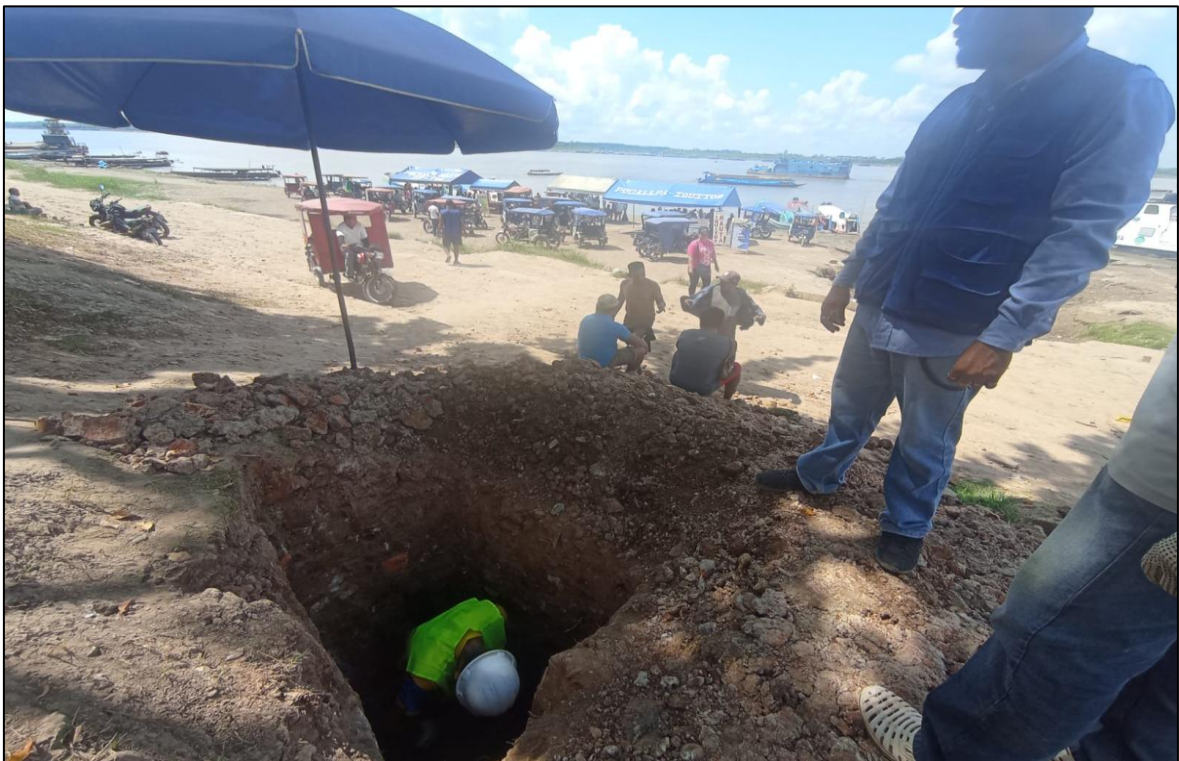
Figura 21: Zona de excavación calicata C-02.
