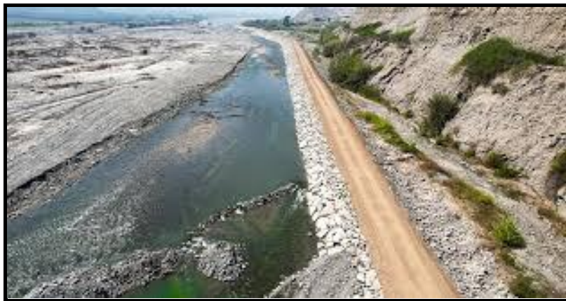
Figura 01:Obras de defensa ribereña en el río Pisco
