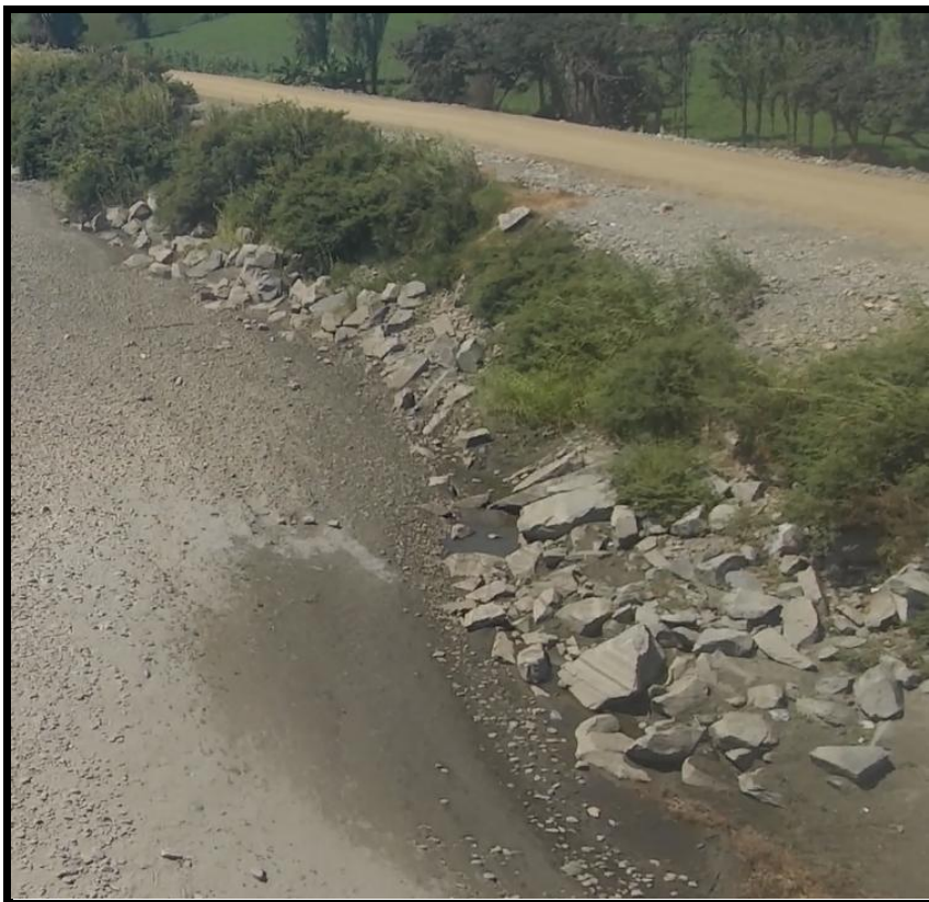
Fotografía 09: evaluación del enrocado tramo 07
