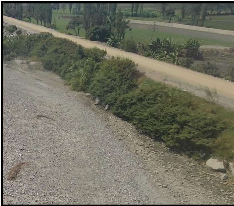
Fotografía 07: evaluación del enrocado tramo 05
