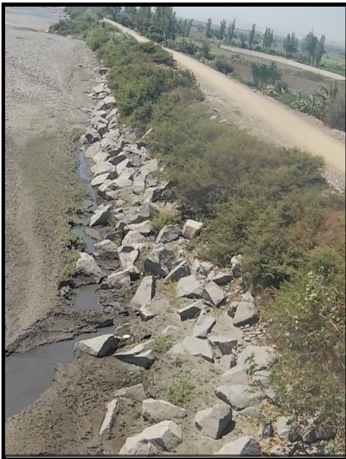
Fotografía 05: evaluación del enrocado tramo 03
