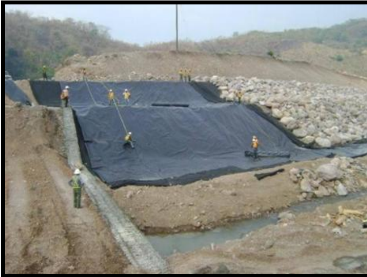
Figura 05: Geotextil protección para enrocado
