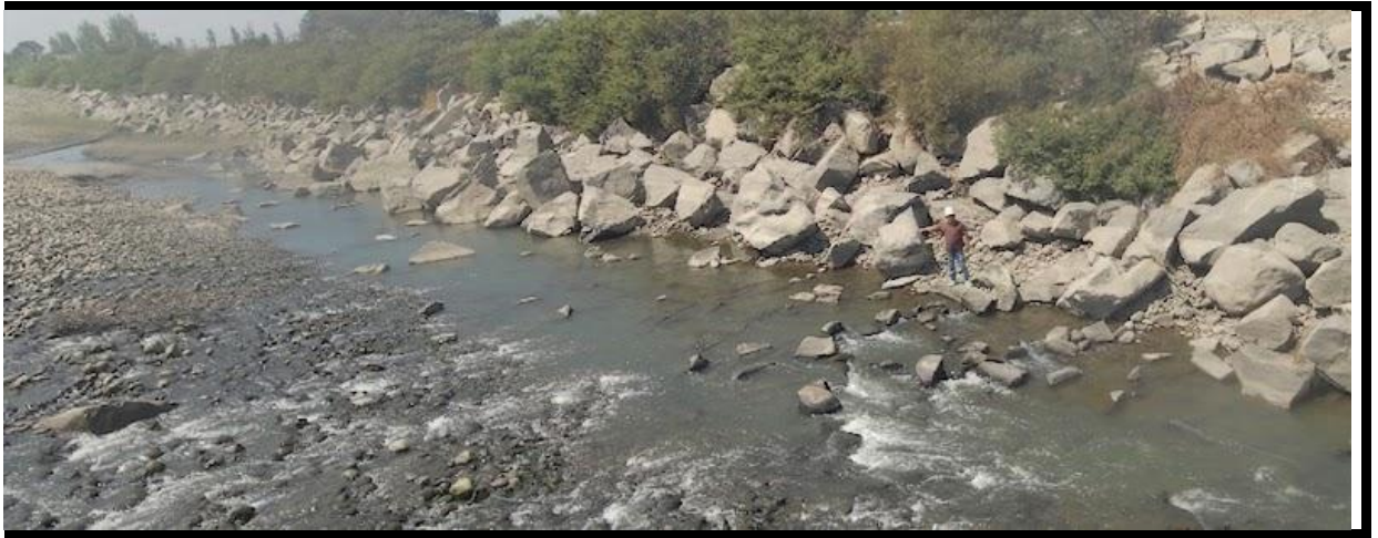
Fotografía 03: evaluación del enrocado
