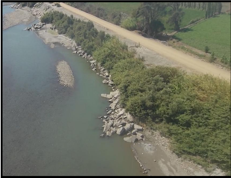
Fotografía 07: evaluación del enrocado
