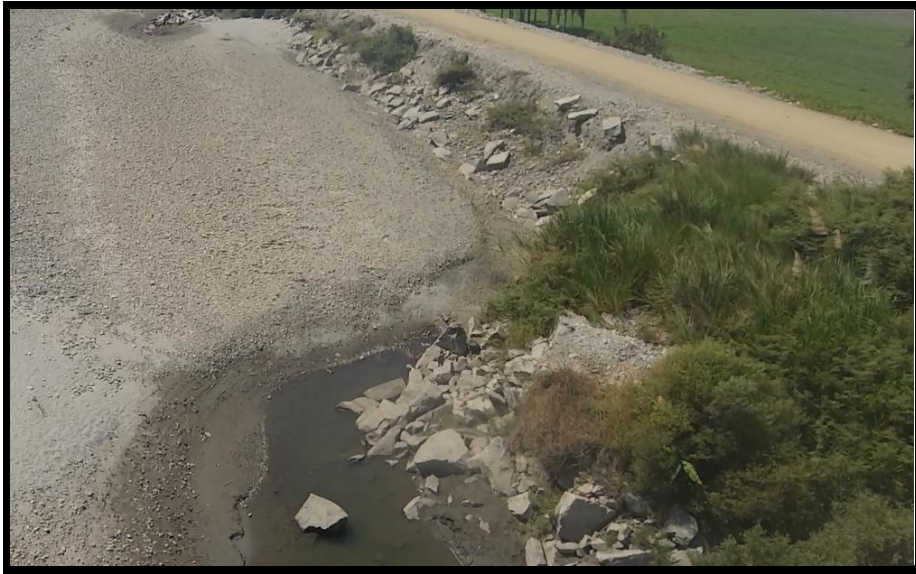
Fotografía 08: evaluación del enrocado tramo 06
