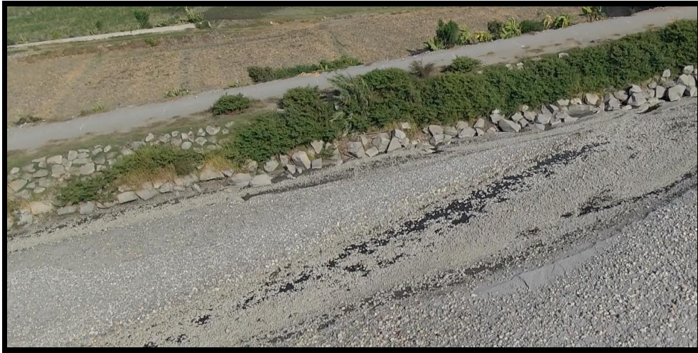
Fotografía 06: evaluación del enrocado tramo 04
