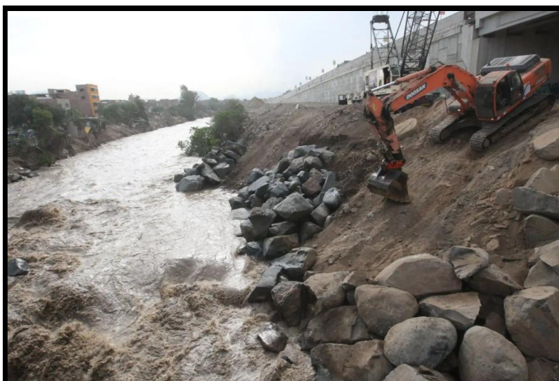
Figura 06: trabajos de enrocado en ribera del río Rímac
