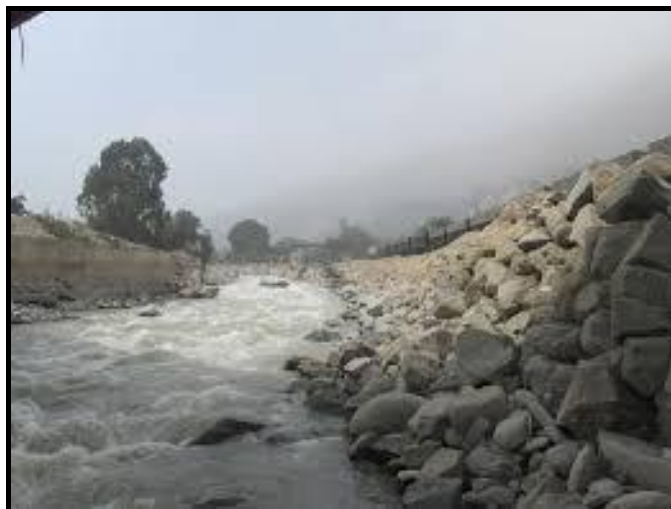
Figura 02: Defensa de margen del rio Rímac con enrocado
