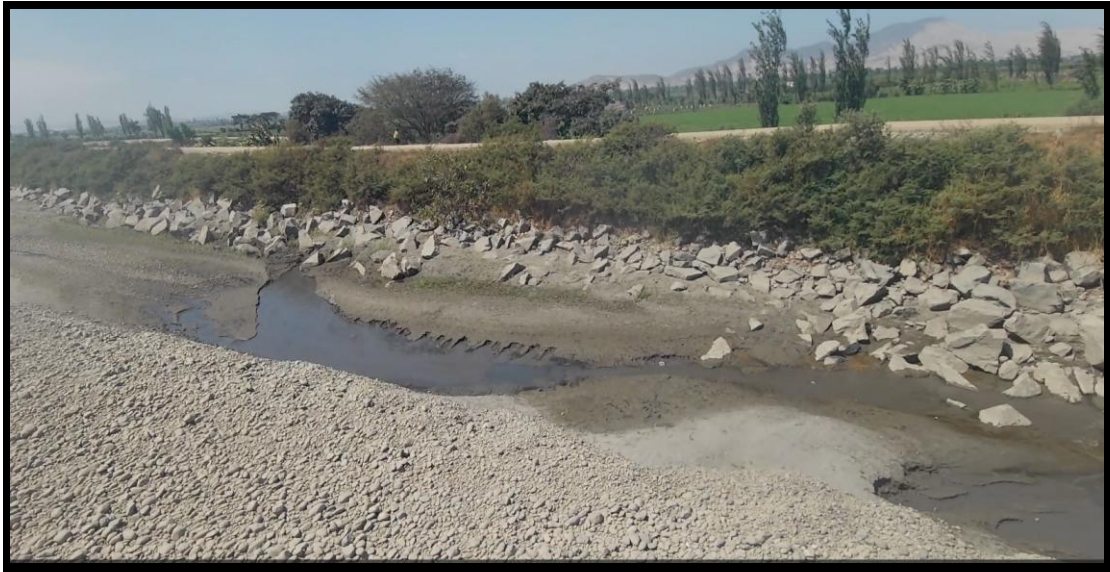
Fotografía 05: evaluación del enrocado tramo 02
