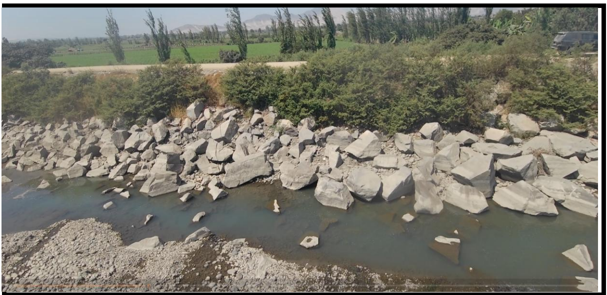
Fotografía 04: evaluación del enrocado tramo 01
