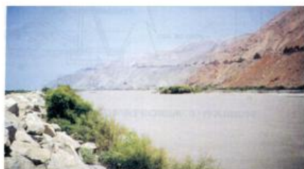
FOTO N° 2. DIQUE ENROCADO CONTINUO VALLE OCOÑA Q_{MAX} 3100 m 3 /seg.
