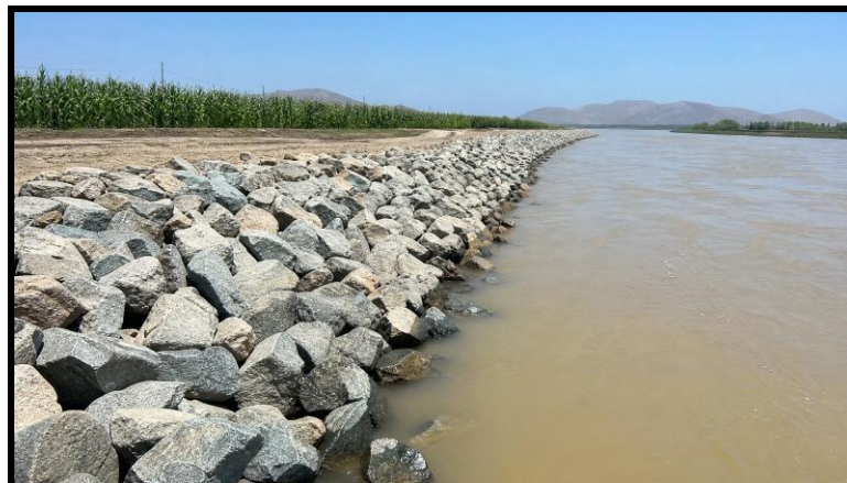
Figura 08: Representación Realista de una Defensa Ribereña con Enrocado en un entorno similar al Río Santa.
