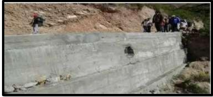
Figura 6: Muro de contención, Chosica Fuente: Scribd (34)
