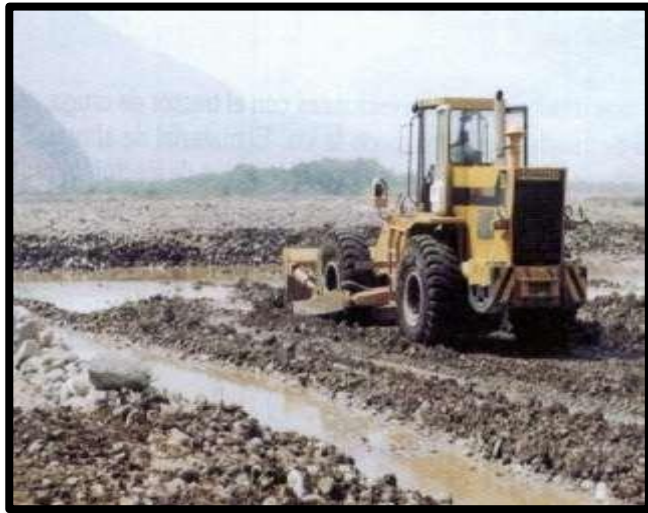
Figura 9: Preparación de vía de acceso
