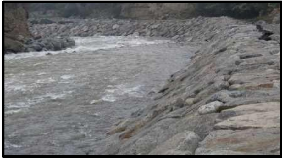
Figura 1: Enrocado río Rímac
