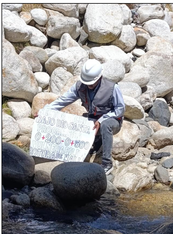
Foto 04: Registro de vulnerabilidad por desplazamiento de roca en la base del enrocado.
