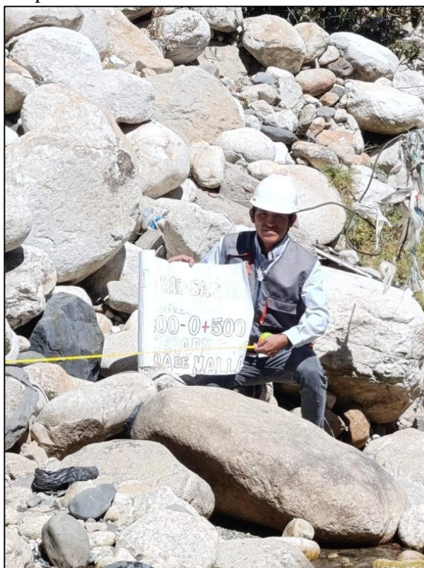
Foto 12: Medición del diámetro equivalente y dimensionamiento de los bloques del enrocado.
