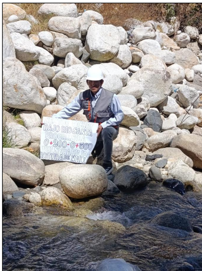
Foto 09: Inspección de la zona de contacto directo entre el flujo del río y el enrocado.
