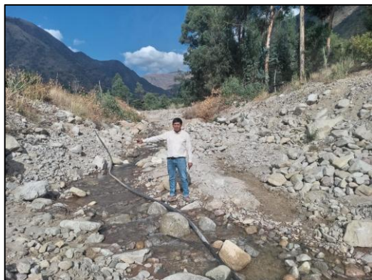
(a) Vista general del cauce y la margen izquierda.
