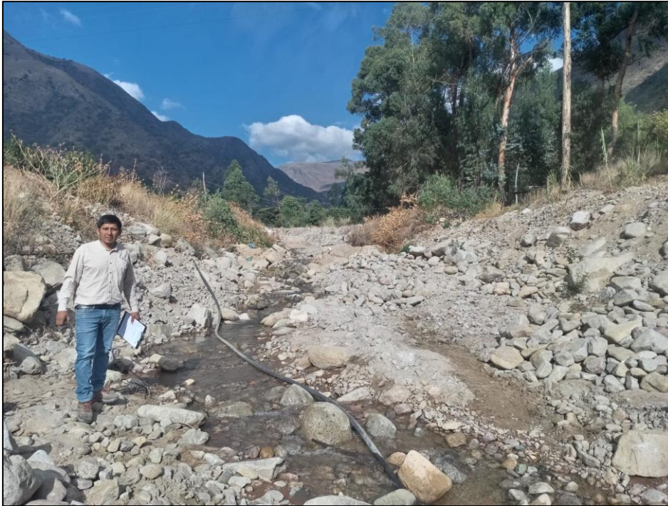
Figura 17. Inspección de campo y reconocimiento de las condiciones del cauce del río Huarmamayo.
