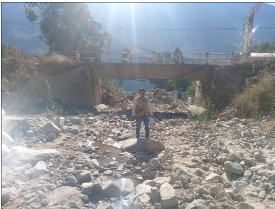
Figura 20. Inspección del cauce en el sector del puente Huarmamayo.
