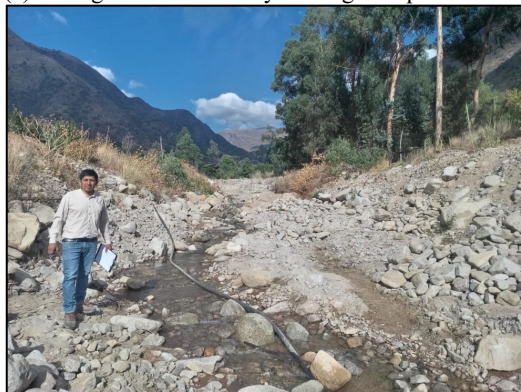
(b) Evidencia representativa de erosión y condición del talud.
