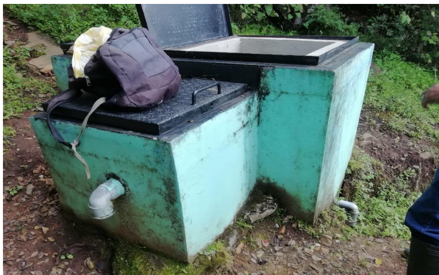
Ilustración 2: Vista de Cámara de Rompe Presión VI
