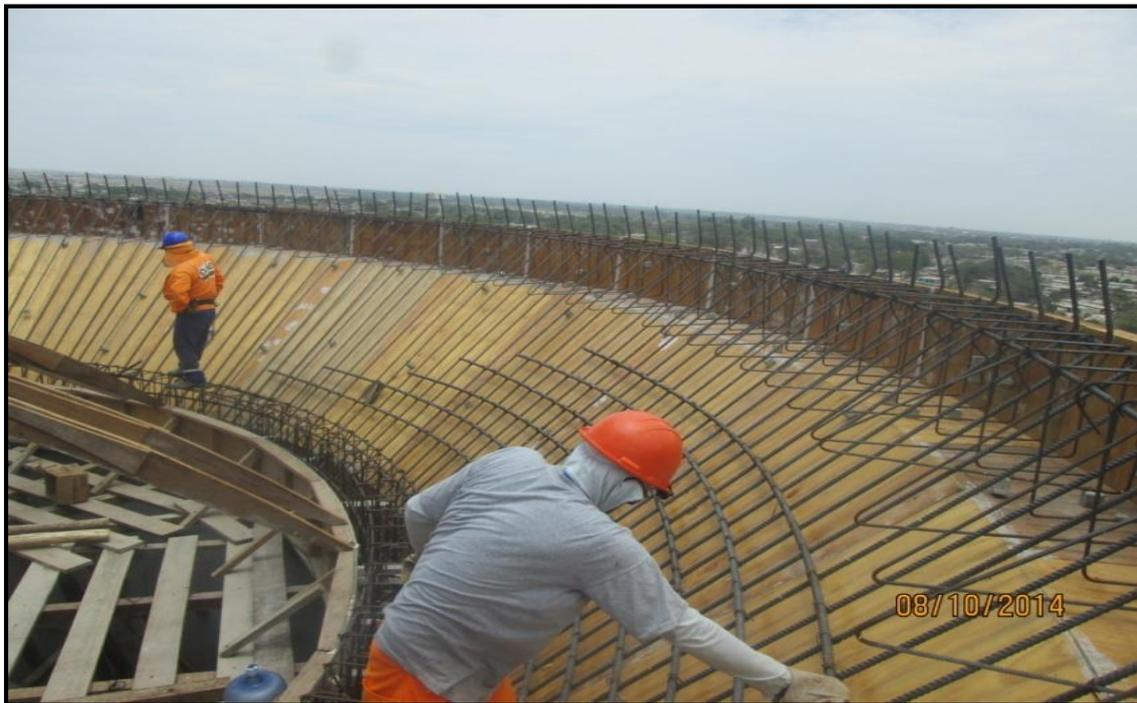
**Figura N°36:** Colocación de acero en la cuba - vista interna
