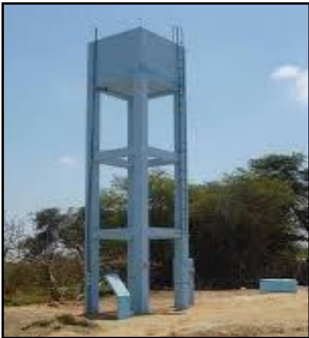
**Figura N°17:** Ejemplo de Reservorio tipo cuadrado - Perú
