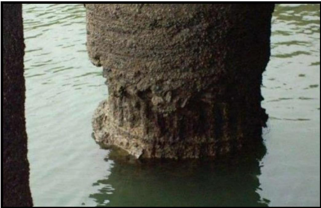
**Figura N°23:** Ejemplo de corrosión en pilares de muelles
