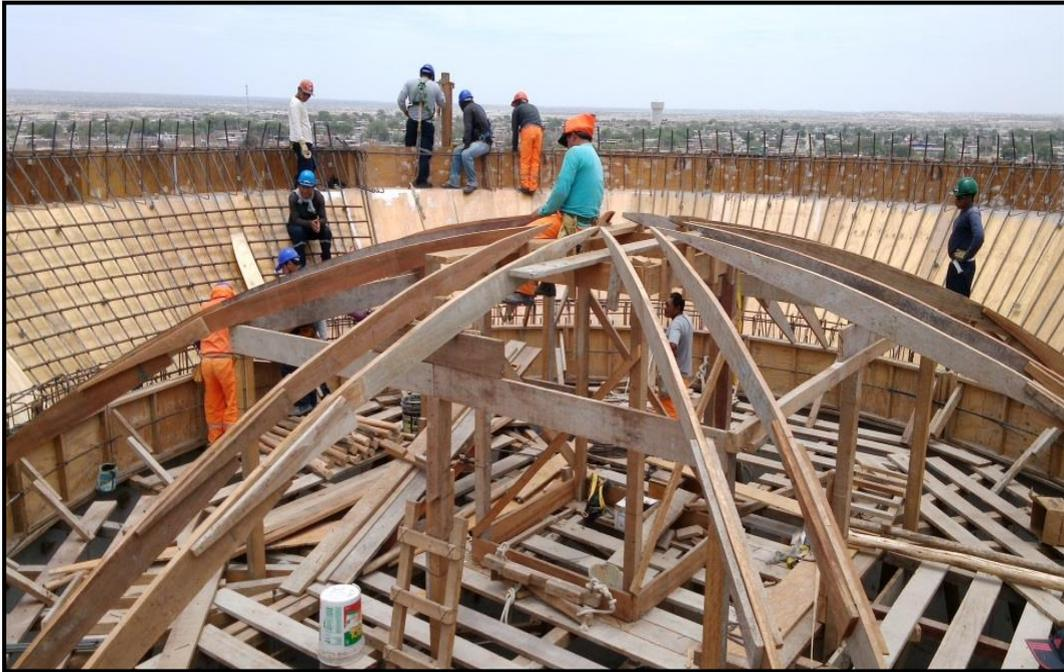
**Figura N°35:** Encofrado de la parte inferior de la cuba - vista interna
