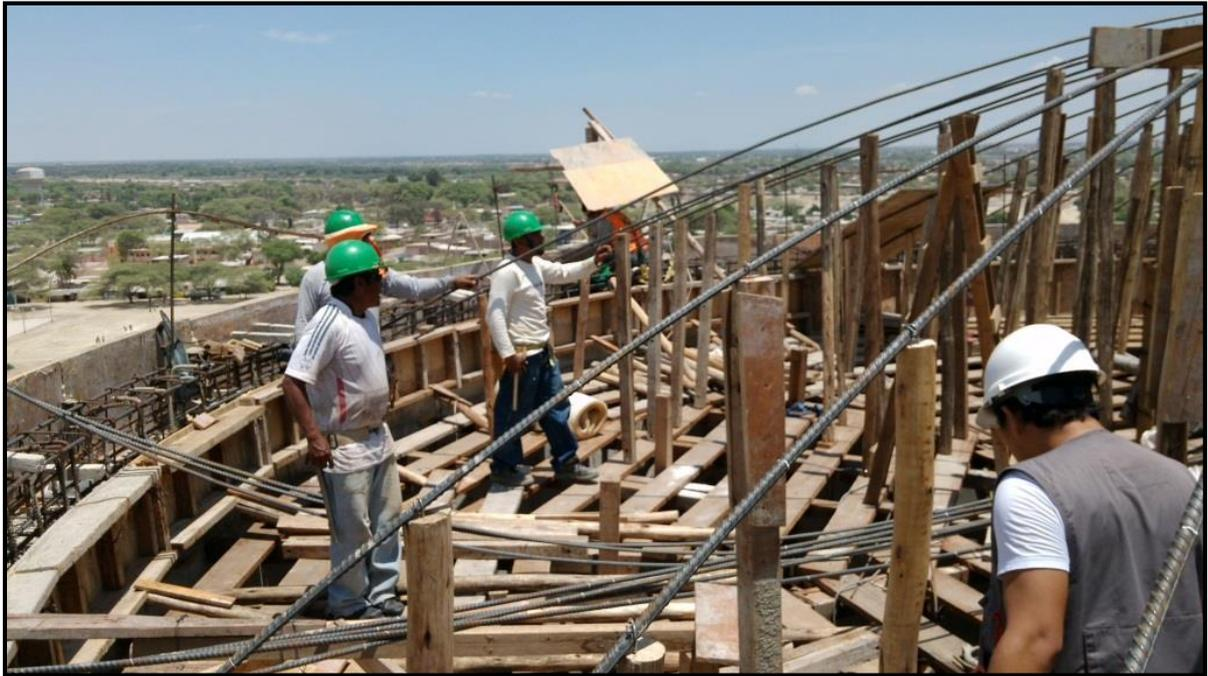
**Figura N°38:** Encofrado del techo de la cuba del reservorio - vista interna
