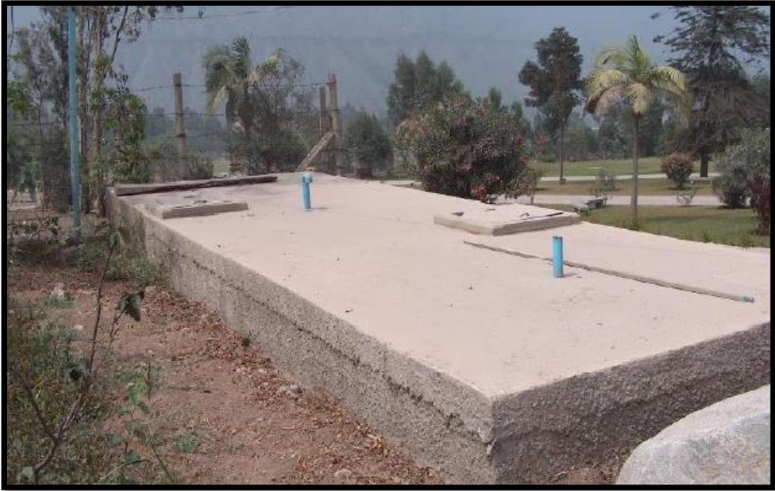
**Figura N°10:** Ejemplo de reservorio enterrado de concreto armado
