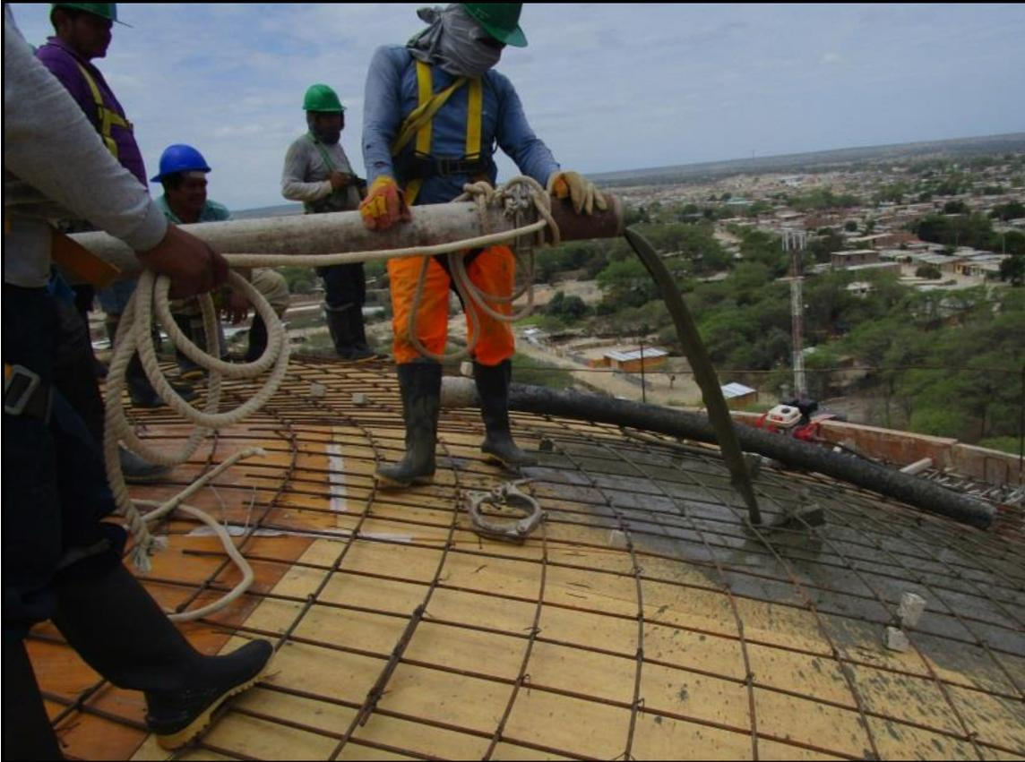
**Figura N°39:** Vaciado del techo de la cuba del reservorio
