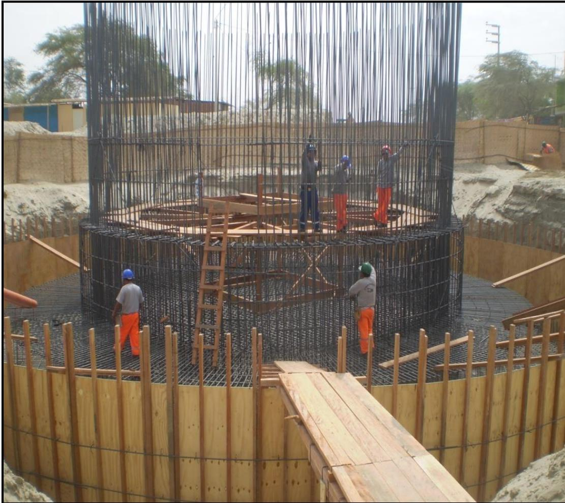
**Figura N°33:** Colocación de acero en viga de cimentación del reservorio, con empalmes para el fuste respectivo
