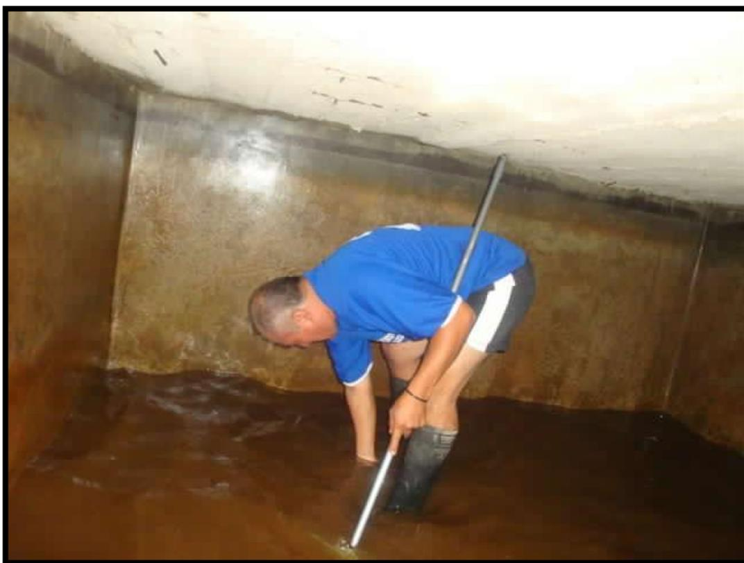
**Figura N°24:** Ejemplo de limpieza de reservorio apoyado
