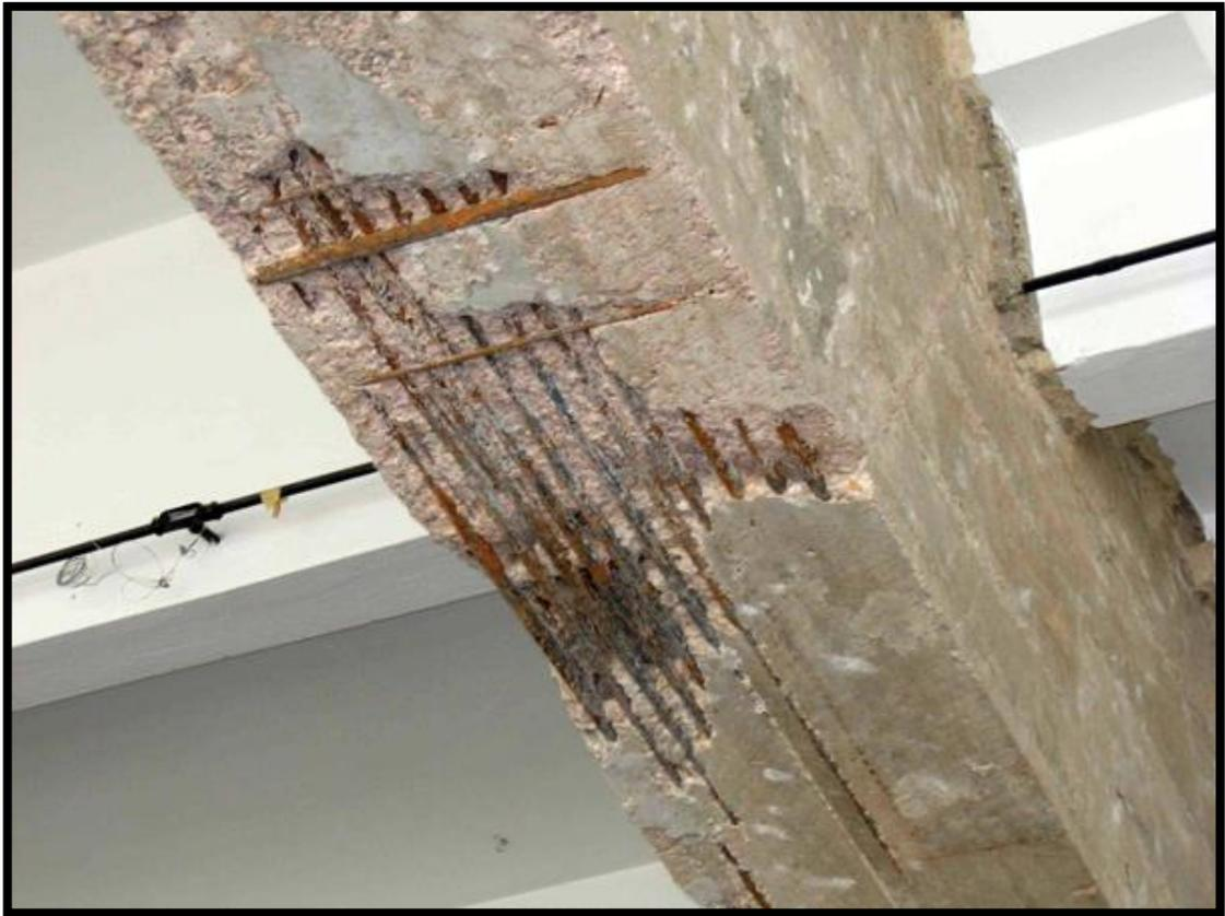
**Figura N°22:** Ejemplo de corrosión del acero de refuerzo en viga.
