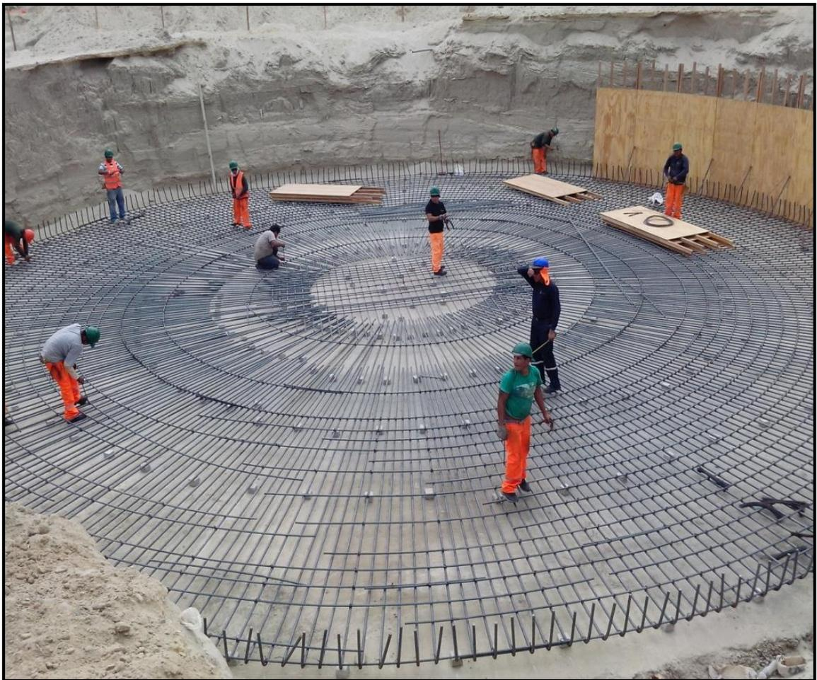
**Figura N°32:** Colocación de acero central de la zapata cuyo Diámetro=20m
