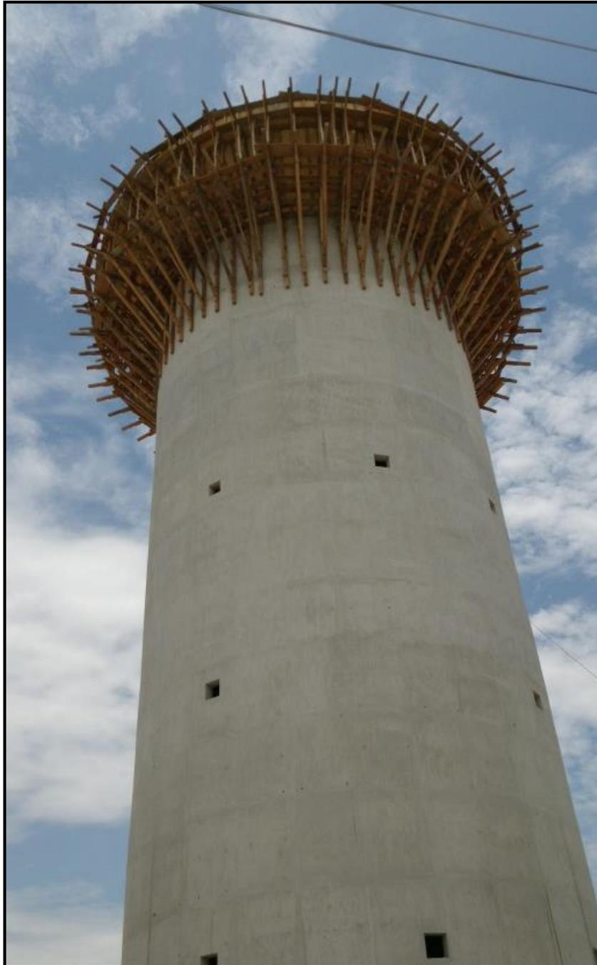
**Figura N°34:** Encofrado de la cuba desde vista inferior
