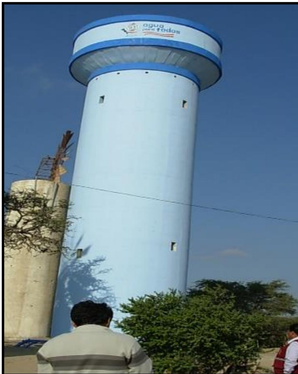
**Figura N°19:** Ejemplo de Reservorio tipo fuste (fuste ancho) – Lima - Perú
