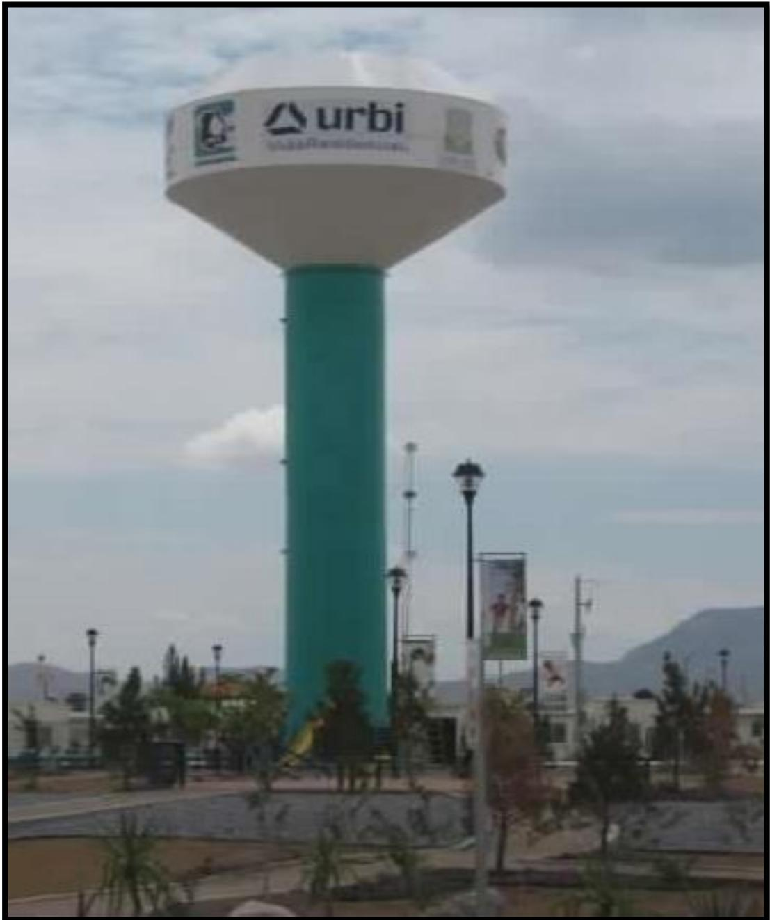
**Figura N°18:** Ejemplo de Reservoirio tipo fuste (fuste delgado) – Lima - Perú
