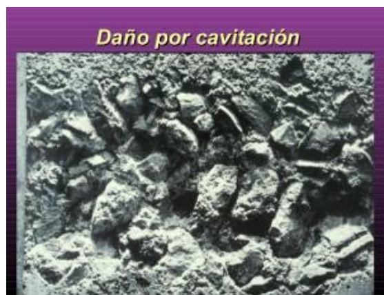
Gráfico N°07: Daño por cavitación
