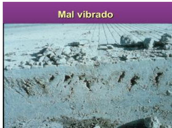
Gráfico N°26: Mal vibrado.
