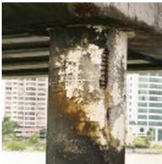
Gráfico N°13: Corrosión biológica del concreto.
