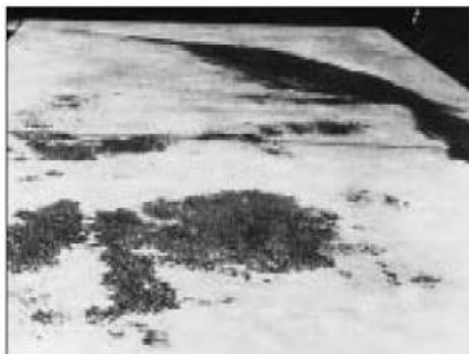
Gráfico N°05: Cambios de color en el concreto
