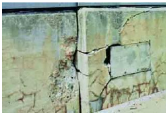
Gráfico N°17: Reacción Álcali-Agregados carbonatados.
