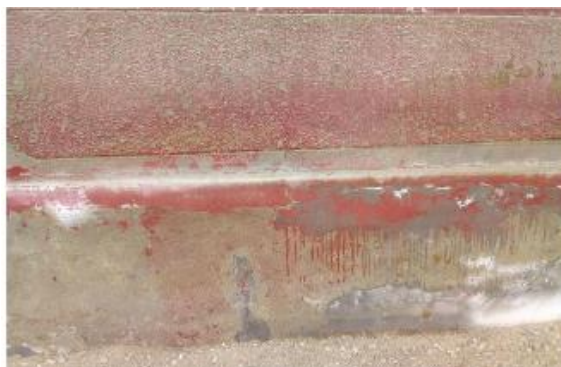
Gráfico N°23: Humedad en el concreto.
