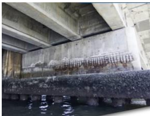
Gráfico N°15: Ataques por sulfatos.
