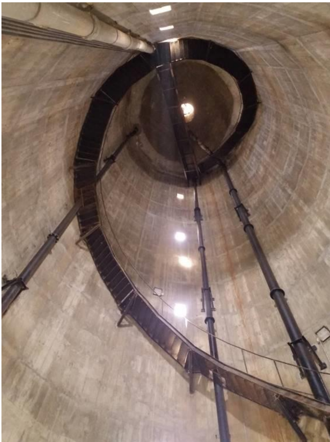
ANEXO N°05: Fotografía de la parte interna del reservorio elevado R-11 Miraflores.
