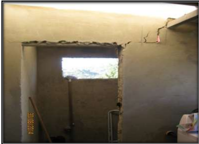
Imagen N° 3: Muros internos que funcionan como muros de carga. Fuente: Ciro F. Rubiel A. yJimenez B. Wilber.
