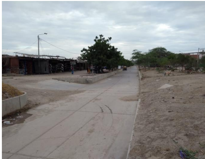
Gráfico 5. Dren de concreto.
