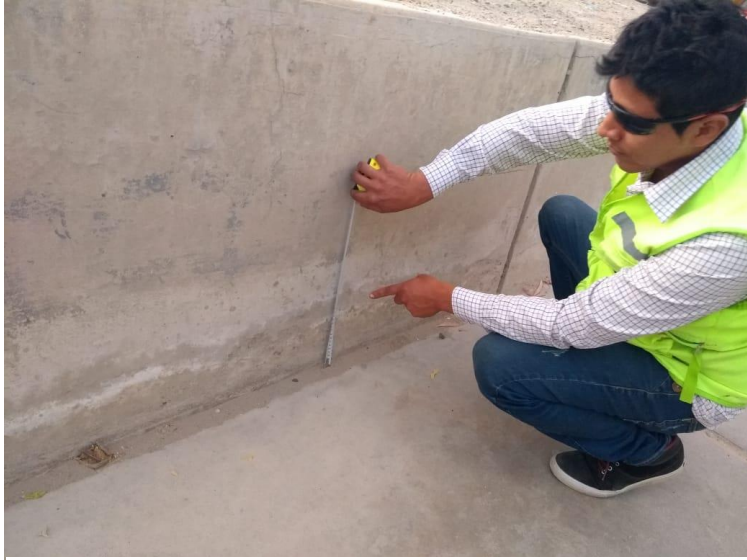
Gráfico 13. Eflorescencia en pared lateral del dren.
