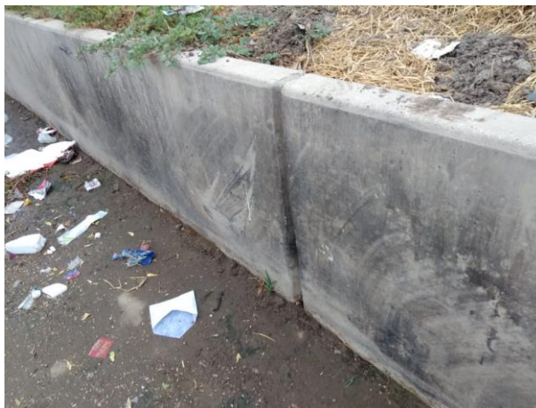
Gráfico 9. Suciedad en pared del dren.
