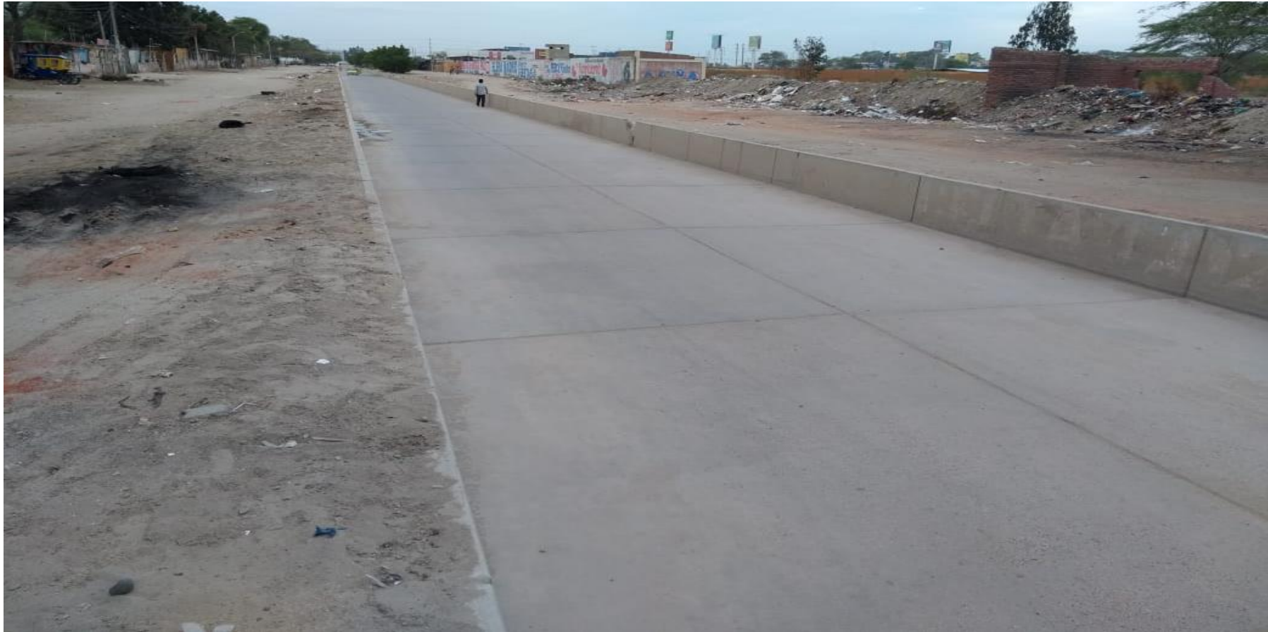
Gráfico 180. Vista panorámica del dren Petroperú.
