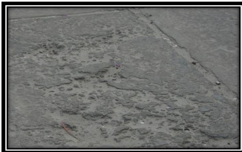
**Figura 15** Descascaramiento de Esquina
