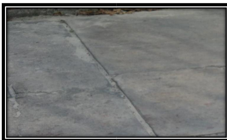
**Figura 16** Descascaramiento de Junta
