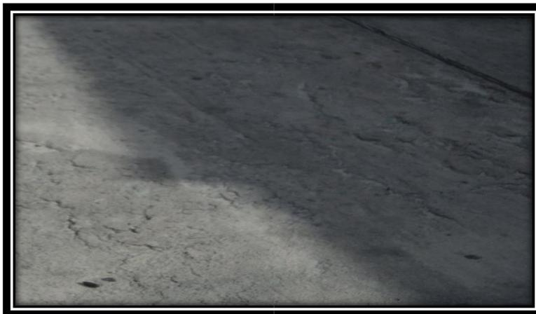
**Figura 27 Pulimiento de Agregado**
