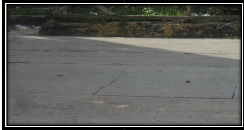
**Figura 19** Grietas de Retracción.
