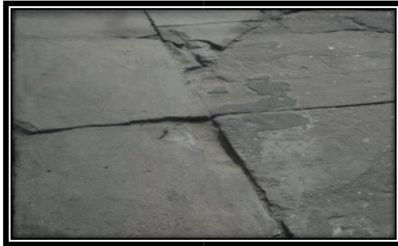
**Figura 18**      **Daño del Sello de la Junta**
