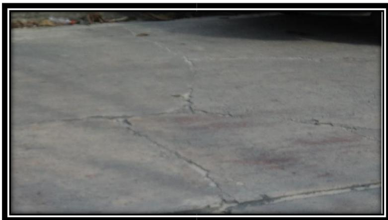
**Figura 23**      **Losa Dividida**
