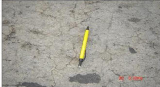
*Figura 4. Fisuración por Retracción*
