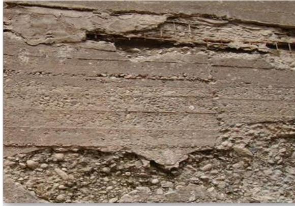
*Figura 6. Erosiones Mecánicas*
