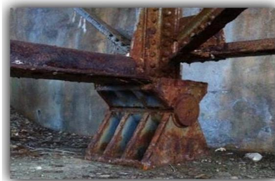
*Figura 8. Corrosión Apoyos de la Estructura de un Puente*
