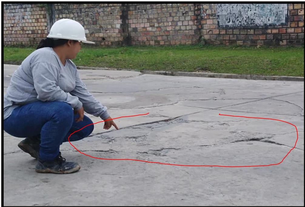
**Figura N° 97: Se observa punzonamiento de severidad alta.**
