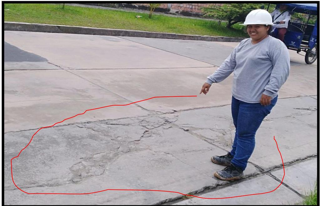
**Figura N° 89: se observa grieta lineal de severidad alta.**
