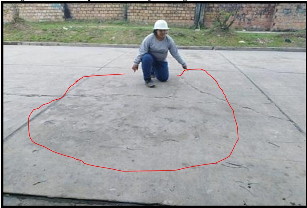
**Figura N° 101: Se observa punzonamiento de severidad media.**
