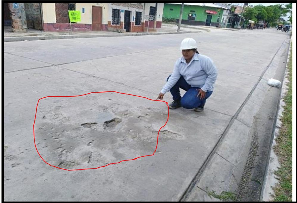
**Figura N° 106: Se observa punzonamiento severidad media**
