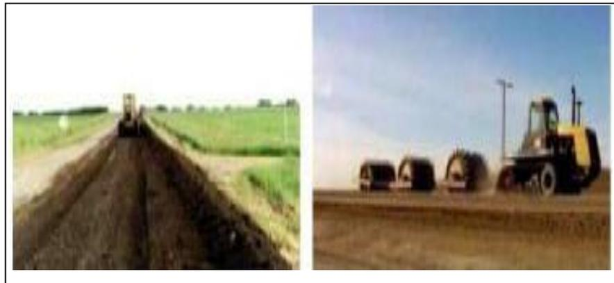
Mientras que (Altamirano L. 2007) <sup>(11)</sup>. Es la capa del terreno de una carretera que soporta la estructura del pavimento, y que se extiende una profundidad que no afecte la carga del diseño. es decir esta capa puede estar a corte o relleno que al ser compactada, debe de tener las secciones transversales, pendientes y sobre todo las especificaciones en los planos finales.
