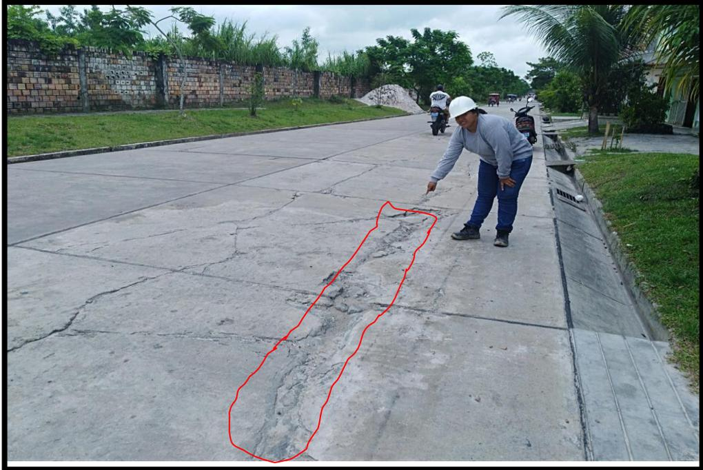
**Figura N° 98: foto de punzonamiento de severidad alta.**
