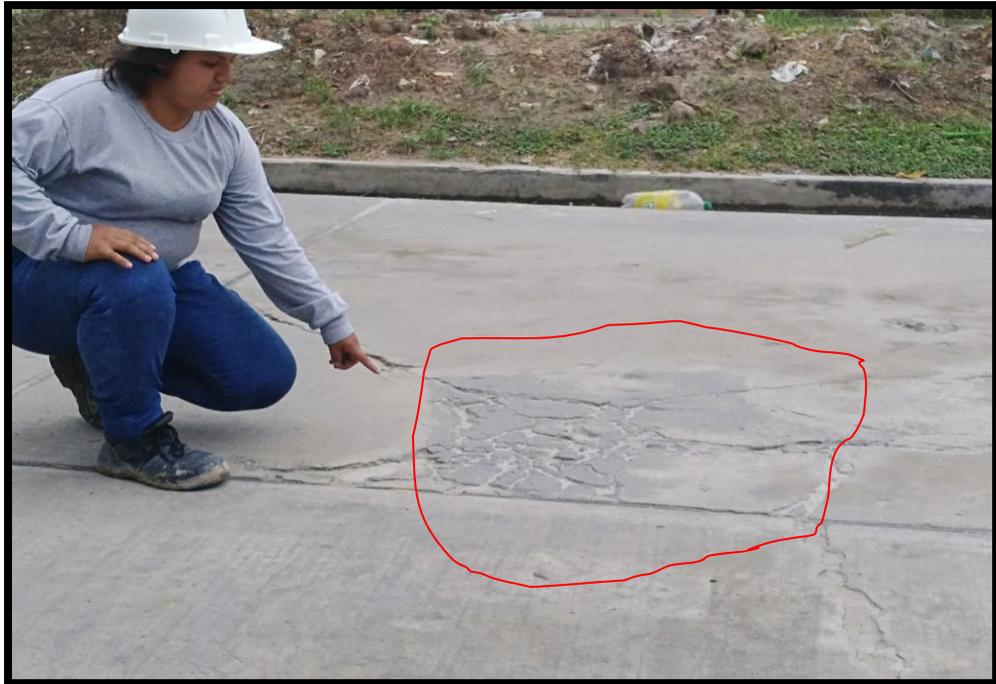
**Figura N° 102: Se observa punzonamiento severidad alta.**
