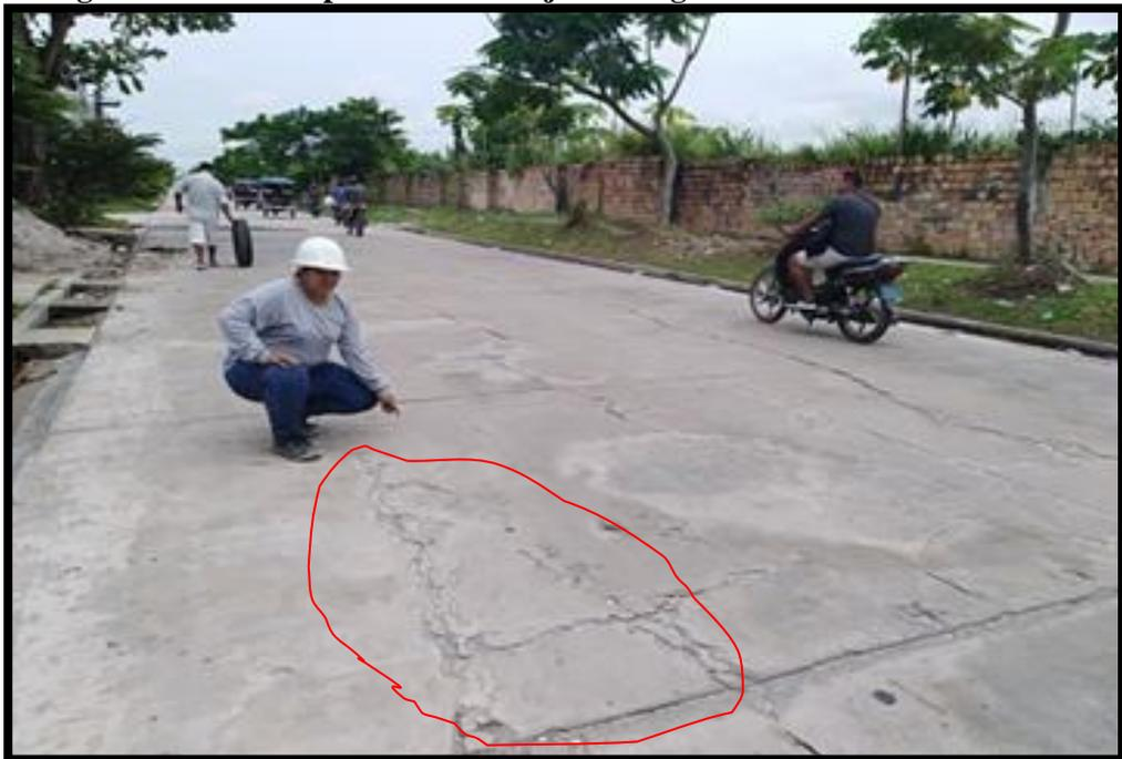
**Figura N° 109: Se observa grietas lineales de severidad media**
