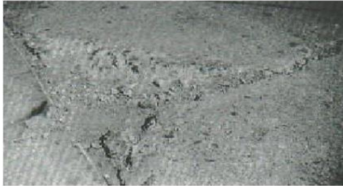
Fig. N° 28 Descascaramiento de esquina
