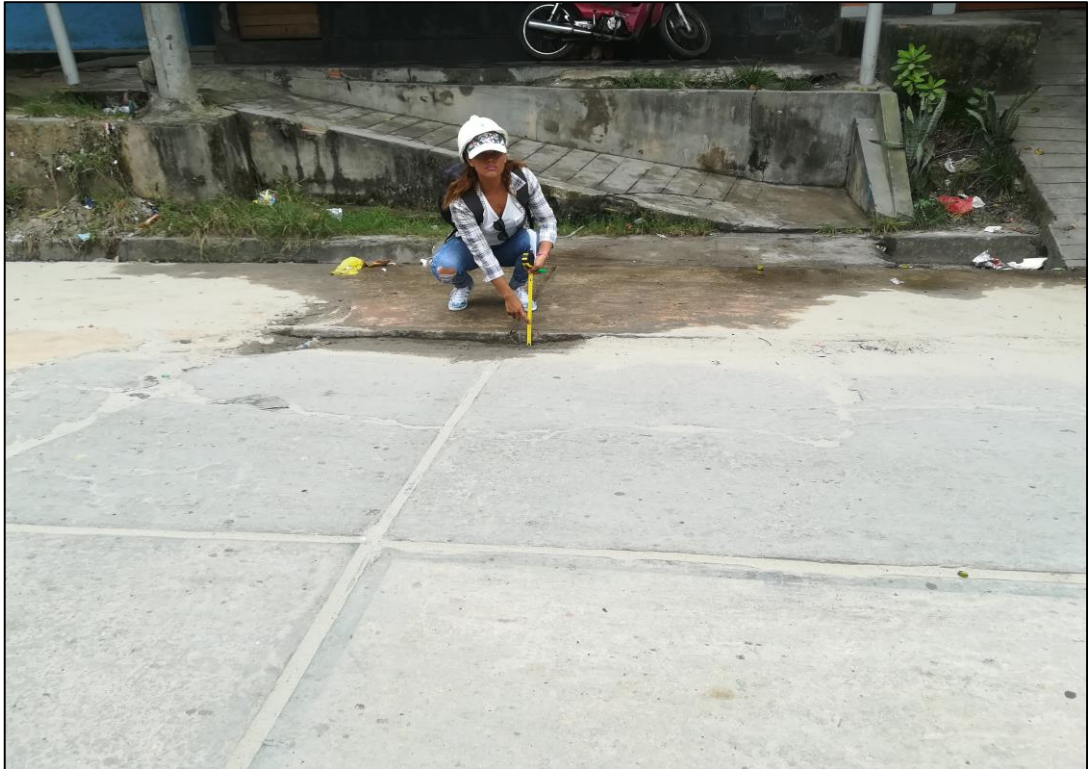
Figura 123 Calle buenos Aires entre (Ca. Rosa Merino con Ca. Pantoja) cuadra 3. Se observa el daño de Escala de severidad Medio de 15 mm.
