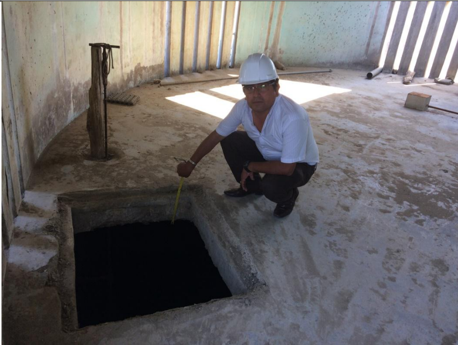
Verificación del Espesor de la losa de Concreto de la Cámara de bombeo N°2 de Negritos
