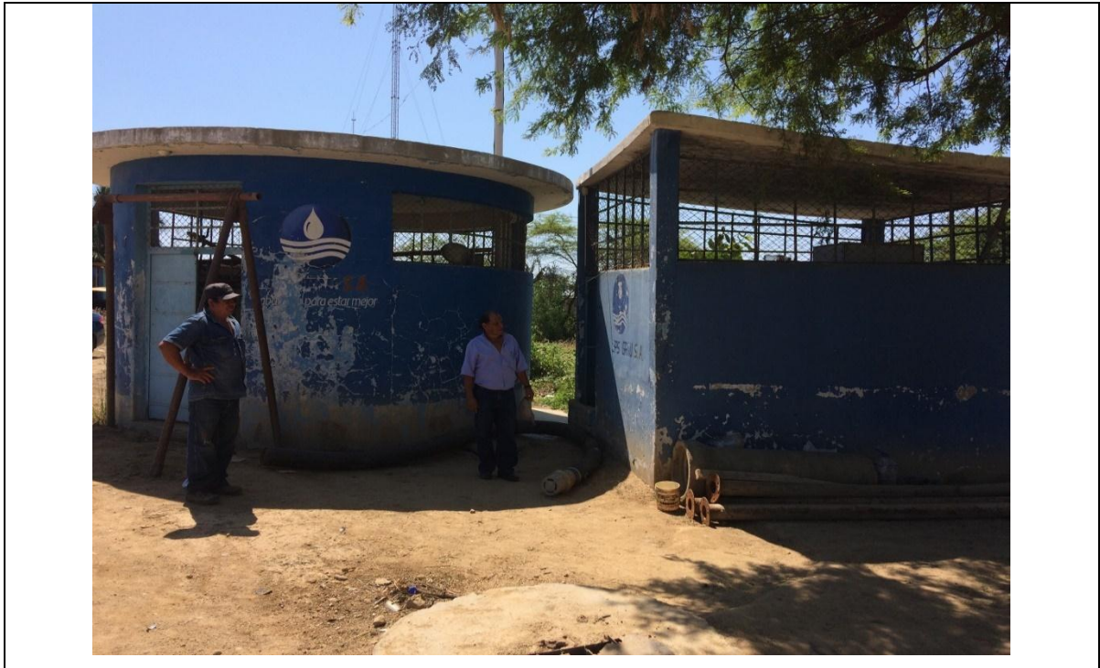
Toma Fotográfica de la Cámara de Bombeo de Aguas Servidas N°2 - Mancora
