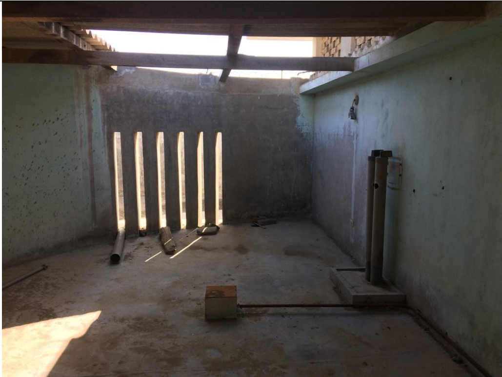
Vista de la losa de Concreto de la CB N°1 - Negritos
