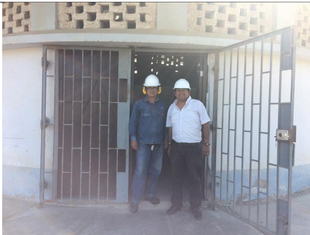
Vista Fotográfica de la Visita de Inspección hecha por el Tesista en la Cámara de Bombeo
