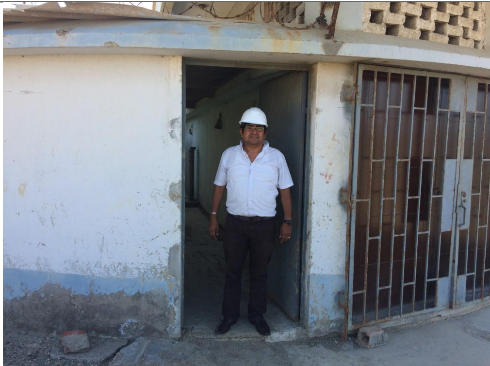
Tesista verificando el grado de deterioro del concreto ubicado en la Cámara de Bombeo
