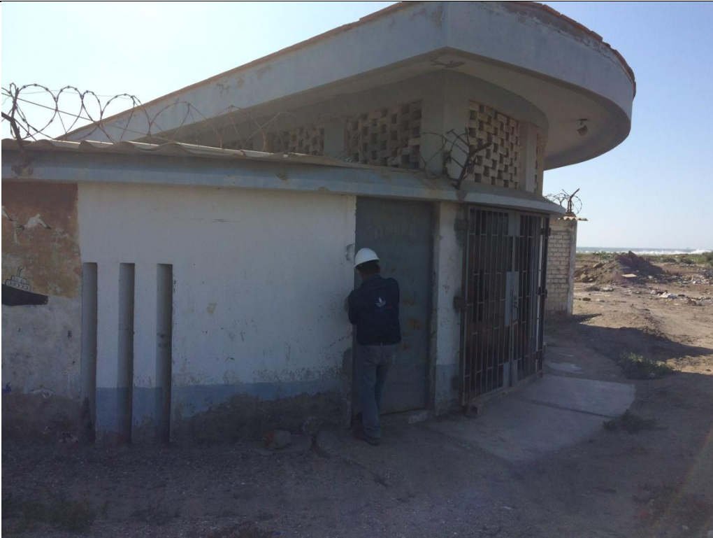
Ubicación de la Cámara de Bombeo de Aguas Servidas N°2 de Negritos
