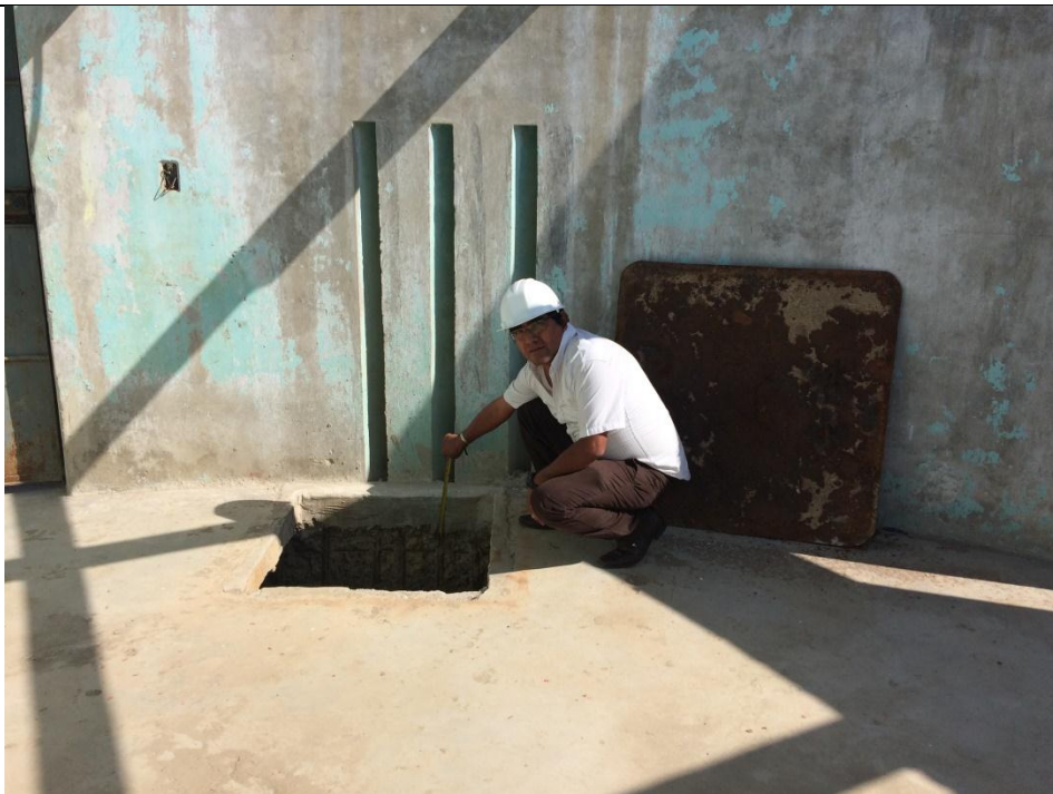
Verificación del Espesor de la losa de Concreto de la Cámara de Bombeo N°3 de Negritos
