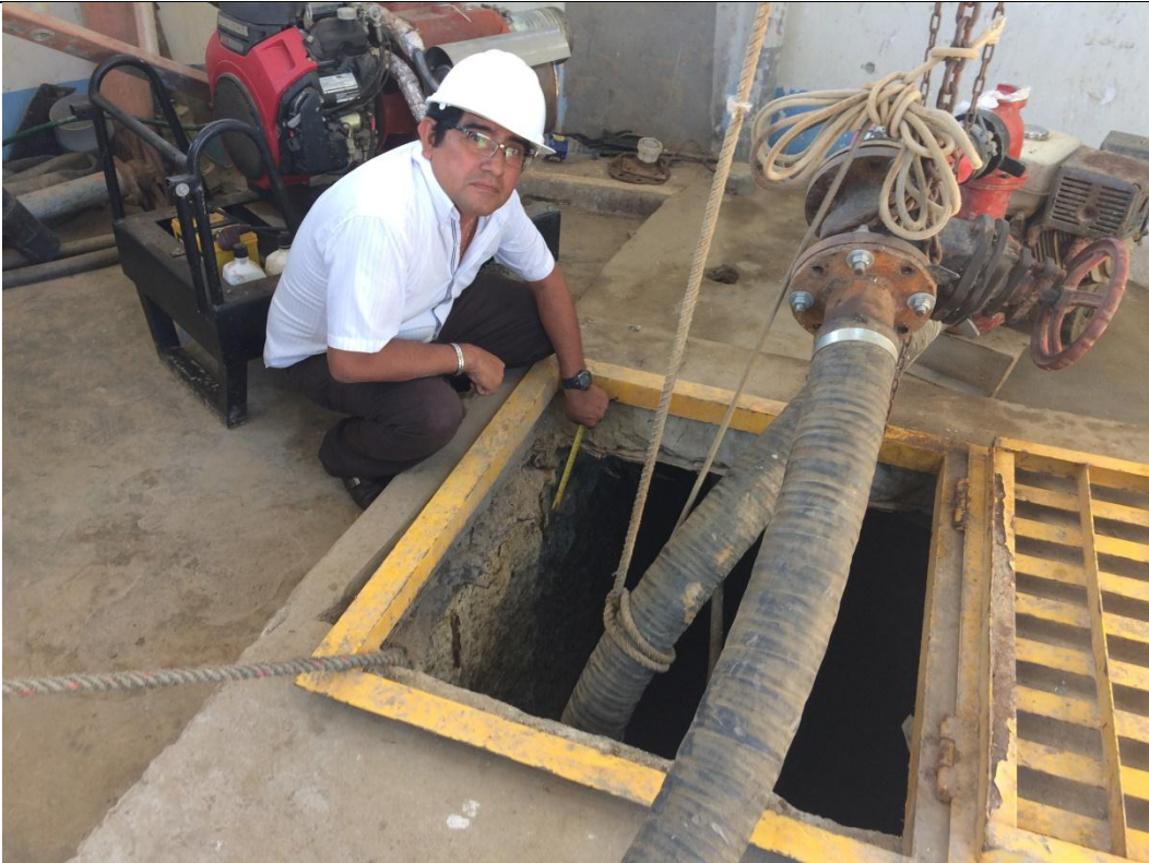
Verificación del Espesor del Techo de la Cámara de bombeo N°2 - Mancora
