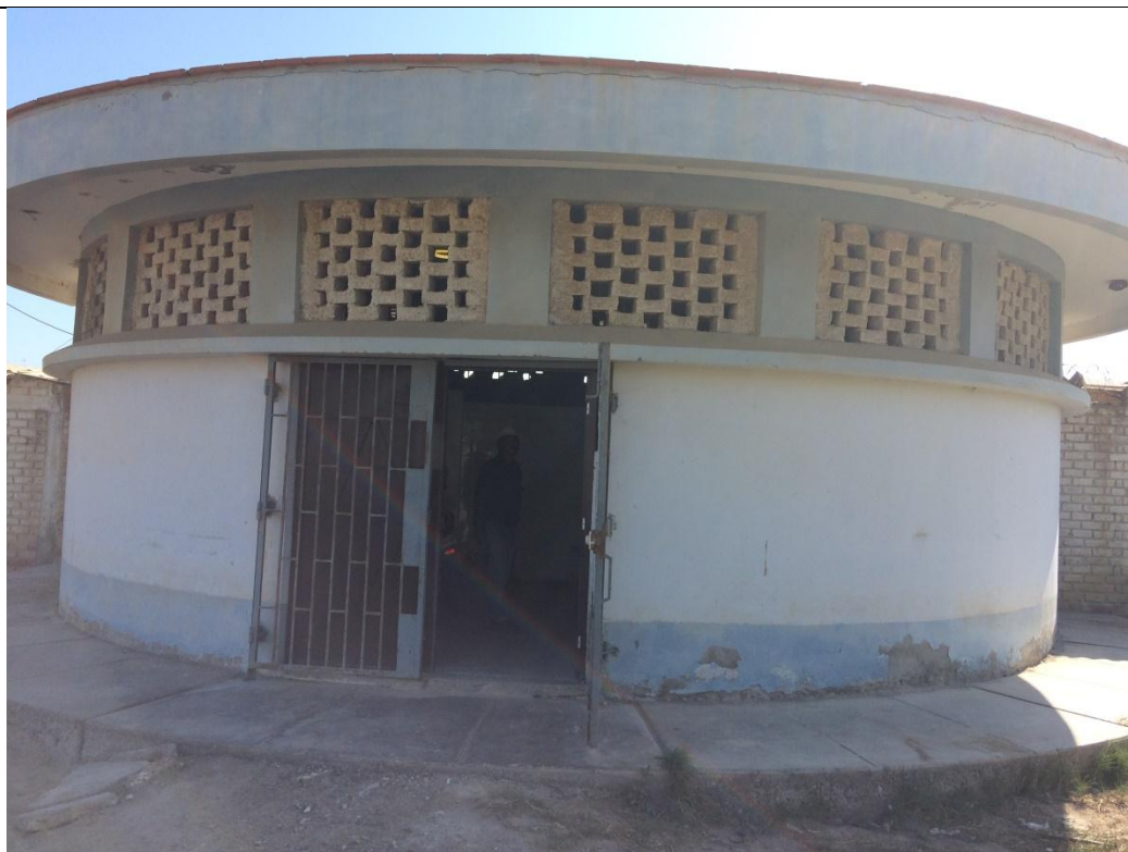
Ubicación de la Cámara de Bombeo de Aguas Servidas N°3 de Negritos
