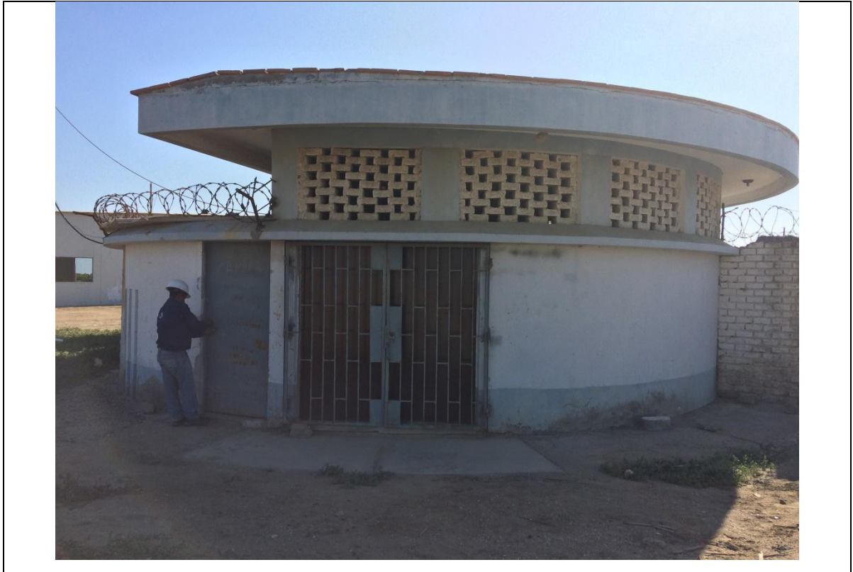
Vista de la Cámara de Bombeo de Aguas Servidas N°1 - Negritos
