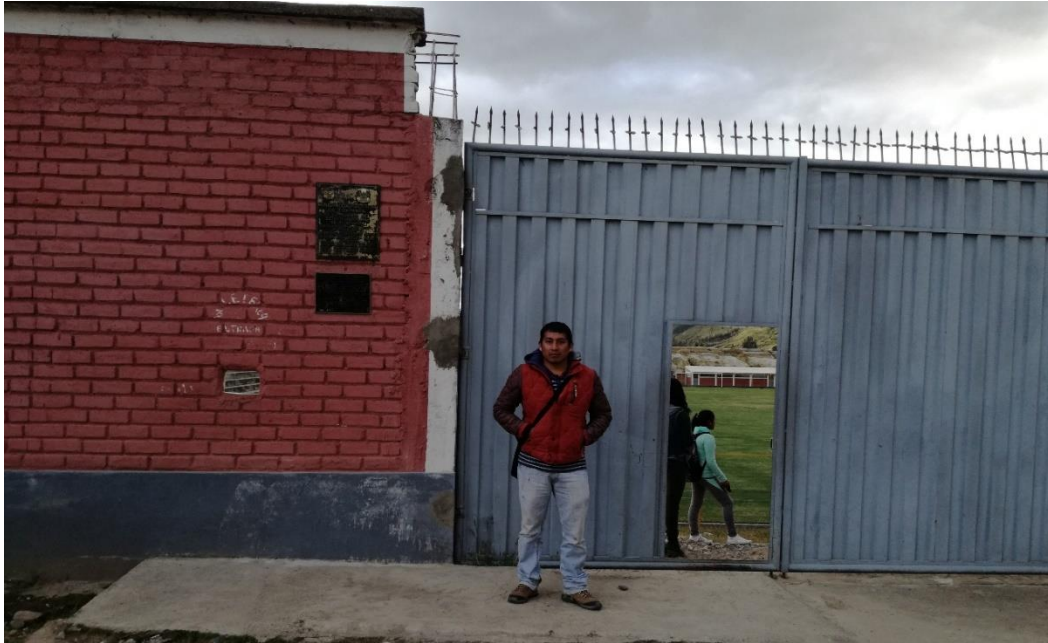
Imagen N° 10: Vista de la puerta de ingreso.
