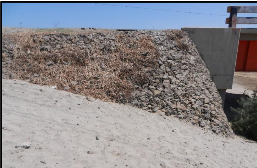
Fig. 21 Protección tipo Gaviones del Puente Pariñas I
