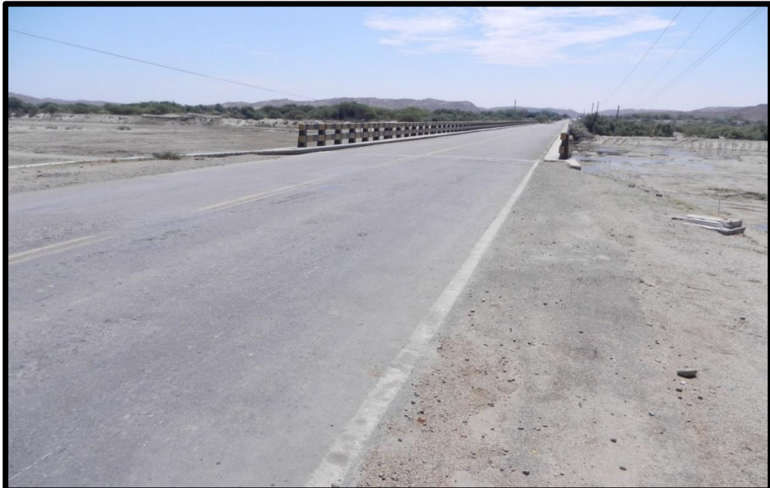
Fig. 20 Acceso izquierdo del Puente Pariñas I
