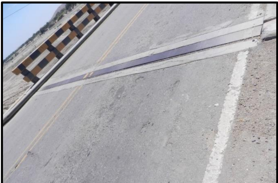
Fig. 23 Planchas deslizantes del Puente Pariñas I
