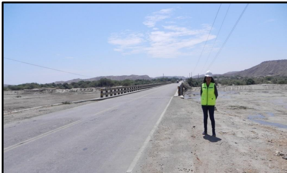
Fig. 19 Inspección de campo
